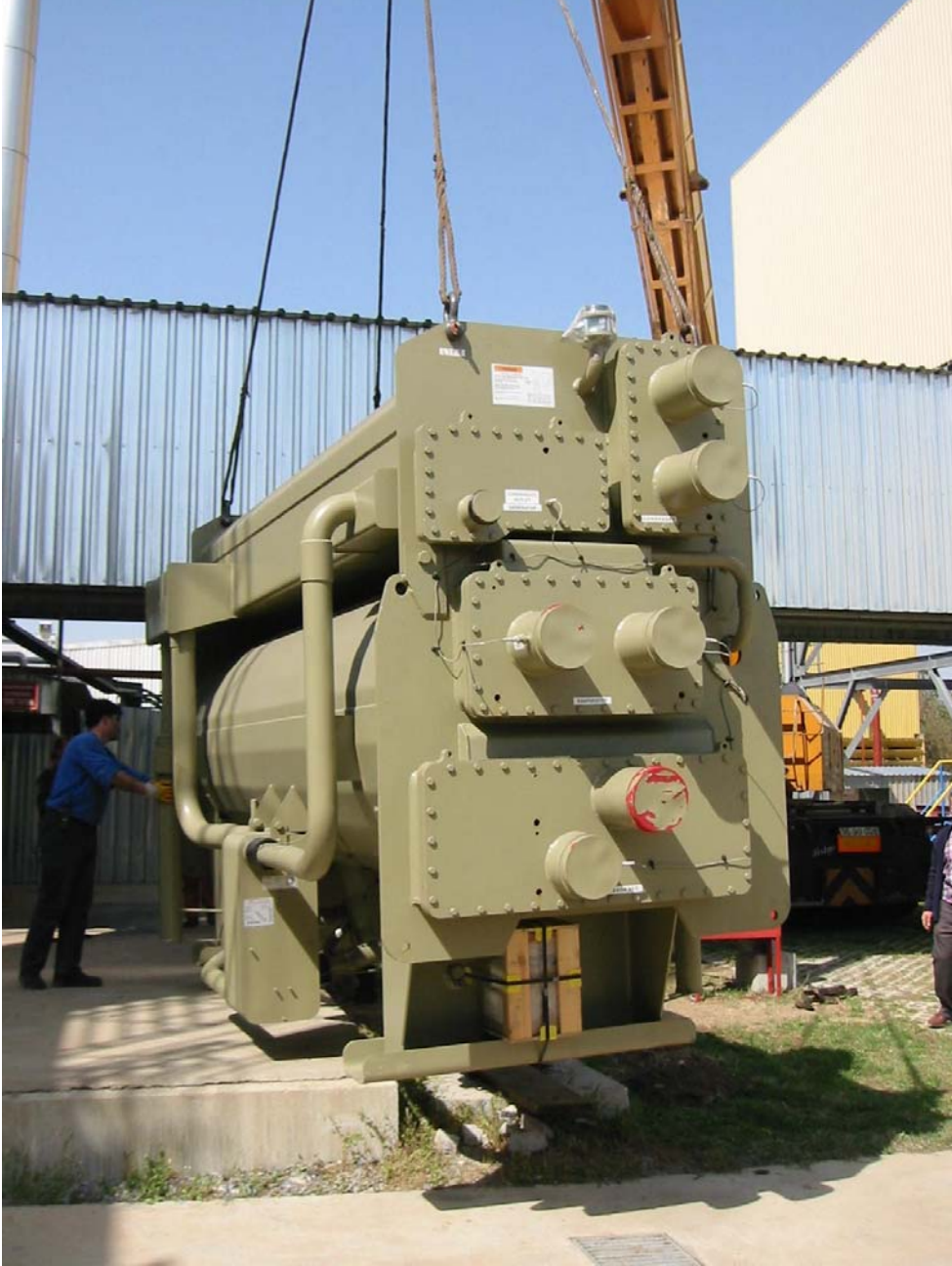
Absorbsiyonlu Soğutma Sisteminin Kurulumu
