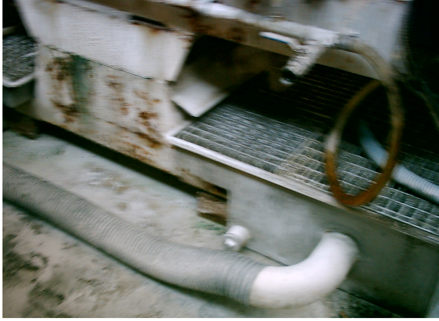
Şekil 5.4 Cam işleme tesisi rodaj makinalarının proses suyunun sirküle olduğu kazanların görüntüsü .
