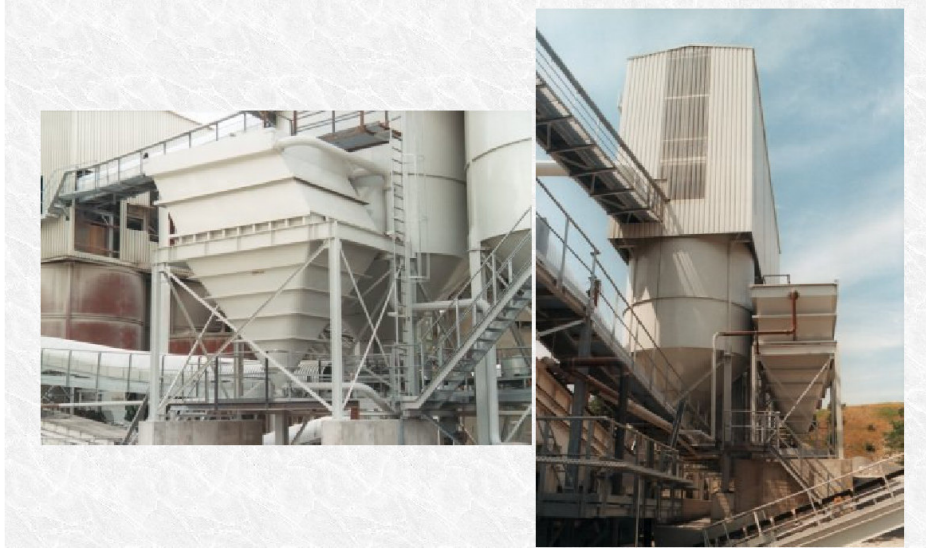
Şekil 3.7 Agrega (Çakıl) Yıkama tesisi [1]
