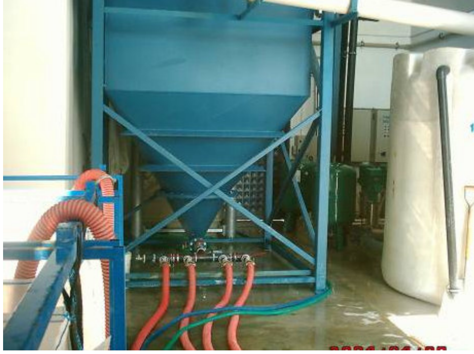
Şekil 6.16 Bükülebilir borular, küresel vanalar ve sedimentasyon tankı Big Bag sistemi bağlantısı.
