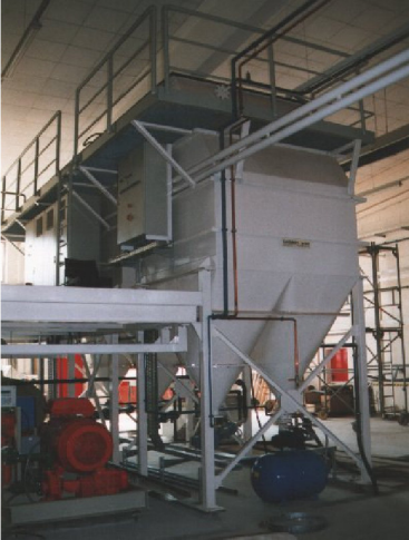
Şekil 3.8 Pissu arıtım tesisinden genel ve sedimentasyon ünitesi üstten görünüş [1]
