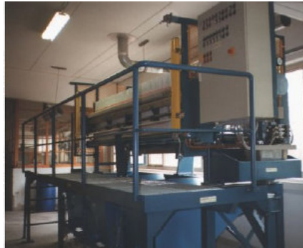
Şekil 3.10 Seramik işleme sedimentasyon tesisi [1]
