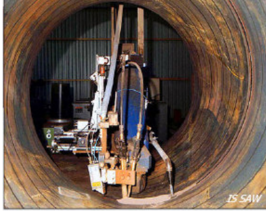
Şekil 4.9 Tozaltı kaynak yöntemi ile iç dikişin imalatı ve kontrolü [13].
