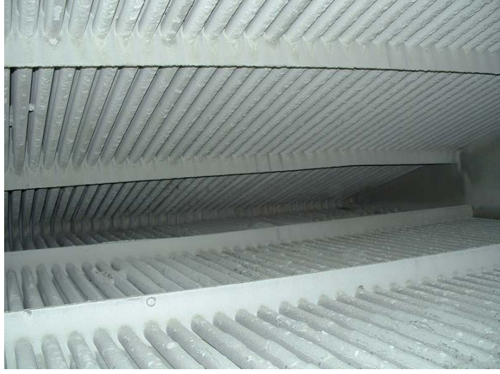
Şekil 4.10 Cam fırını atık ısı kazanları iç görünüşleri, boru demetleri
