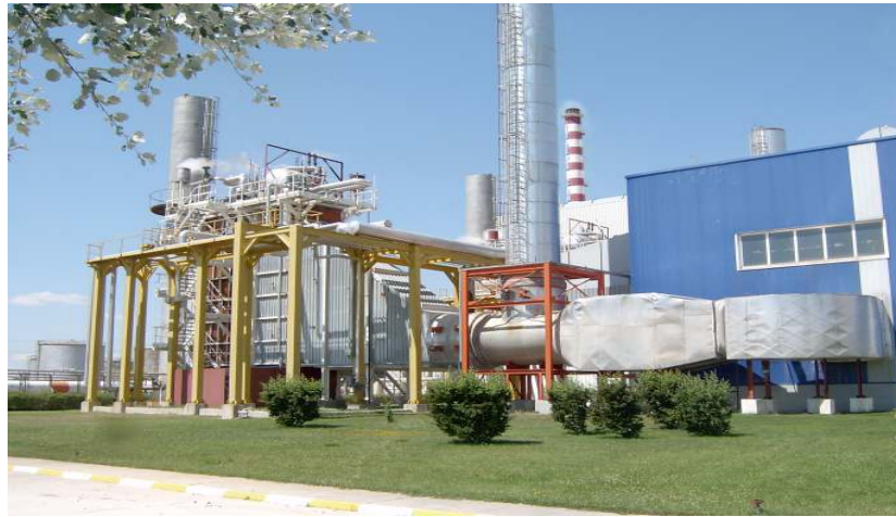
Şekil 4.1 Trakya Bölge Santrali Binası
