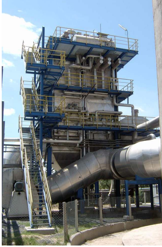
Şekil 4.9 Sistemdeki cam fırını atık ısı kazanları
