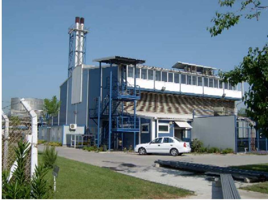
Şekil 5.1 Çayırova Bölge Santrali binası
