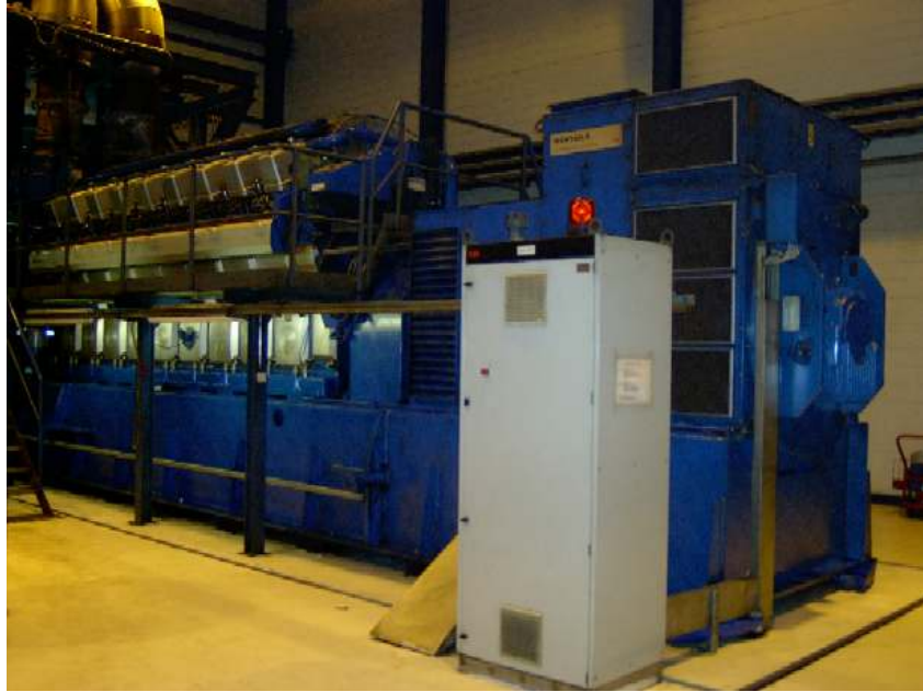
Şekil 5.3 Çayırova Bölge Santralindeki dizel motorlar
