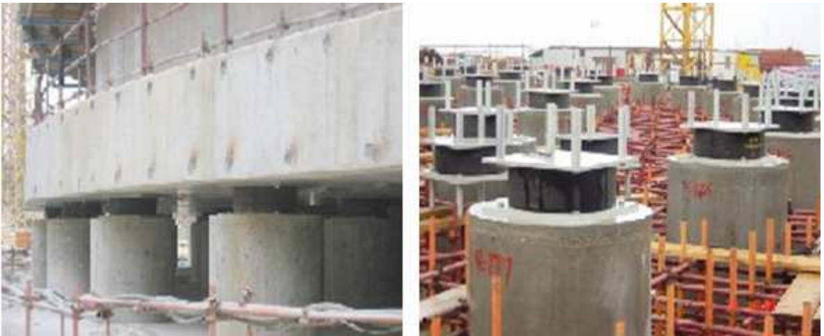
Şekil 2.6 Pasif sönüm sistemi
