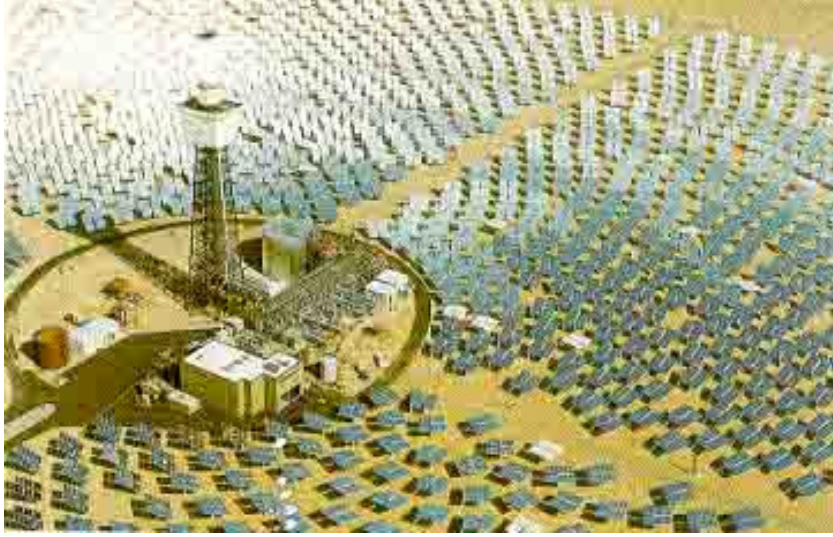
Şekil 2.11 Merkezi alıcılı güneş ısı elektrik santrali
