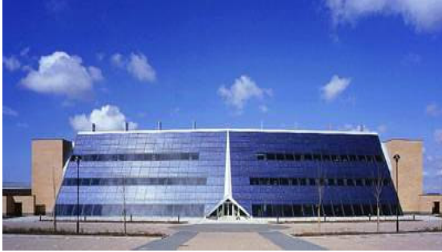
Şekil 3.19 PV kaplama uygulanmış bir bina.
