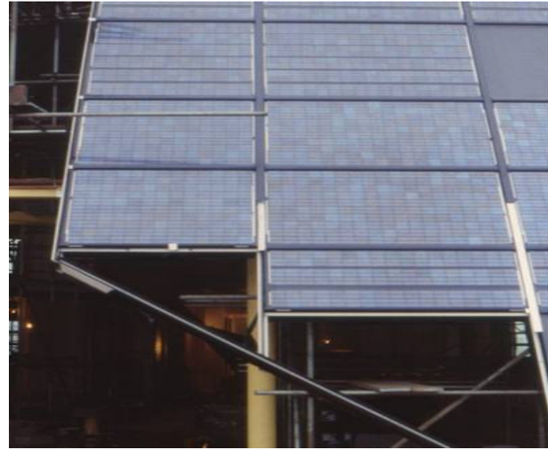
Şekil 3.21 PV kaplamalı binanın inşaat aşamasında çekilmiş resmi.
