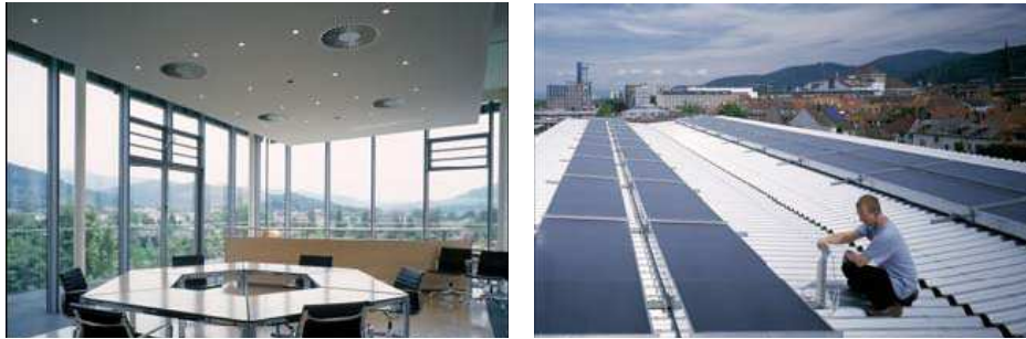
Şekil 2.13 Almanya’da ofise kurulan güneş enerjisi destekli desikant soğutma sistemi
