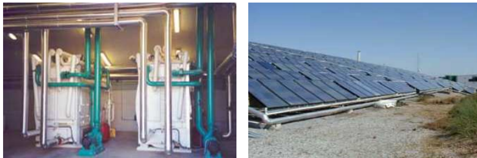
Şekil 2.14 Yunanistan’da kozmetik fabrikasına kurulan güneş enerjisi destekli adsorpsiyonlu soğutma sistemi
