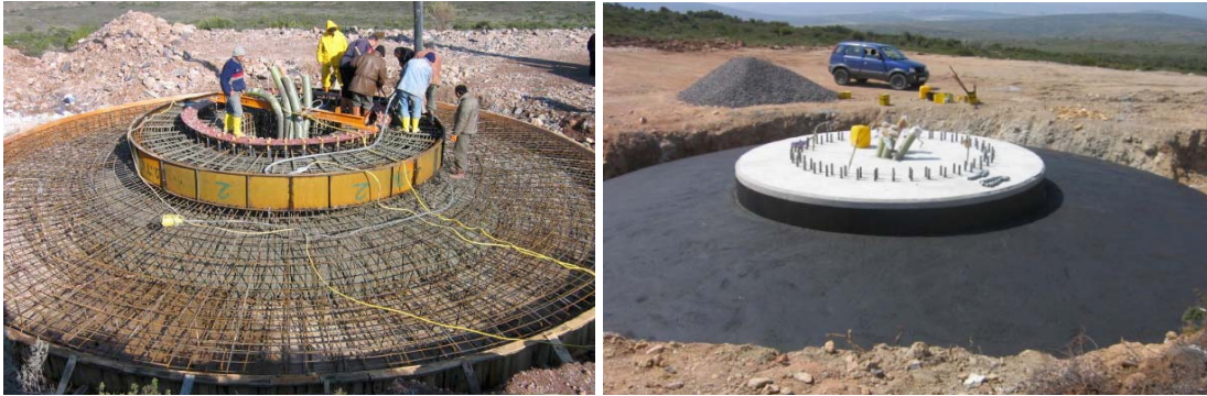
Şekil 4.3 Rüzgar Türbini Zemin Yapısı (Aero A.Ş., İzmir)
