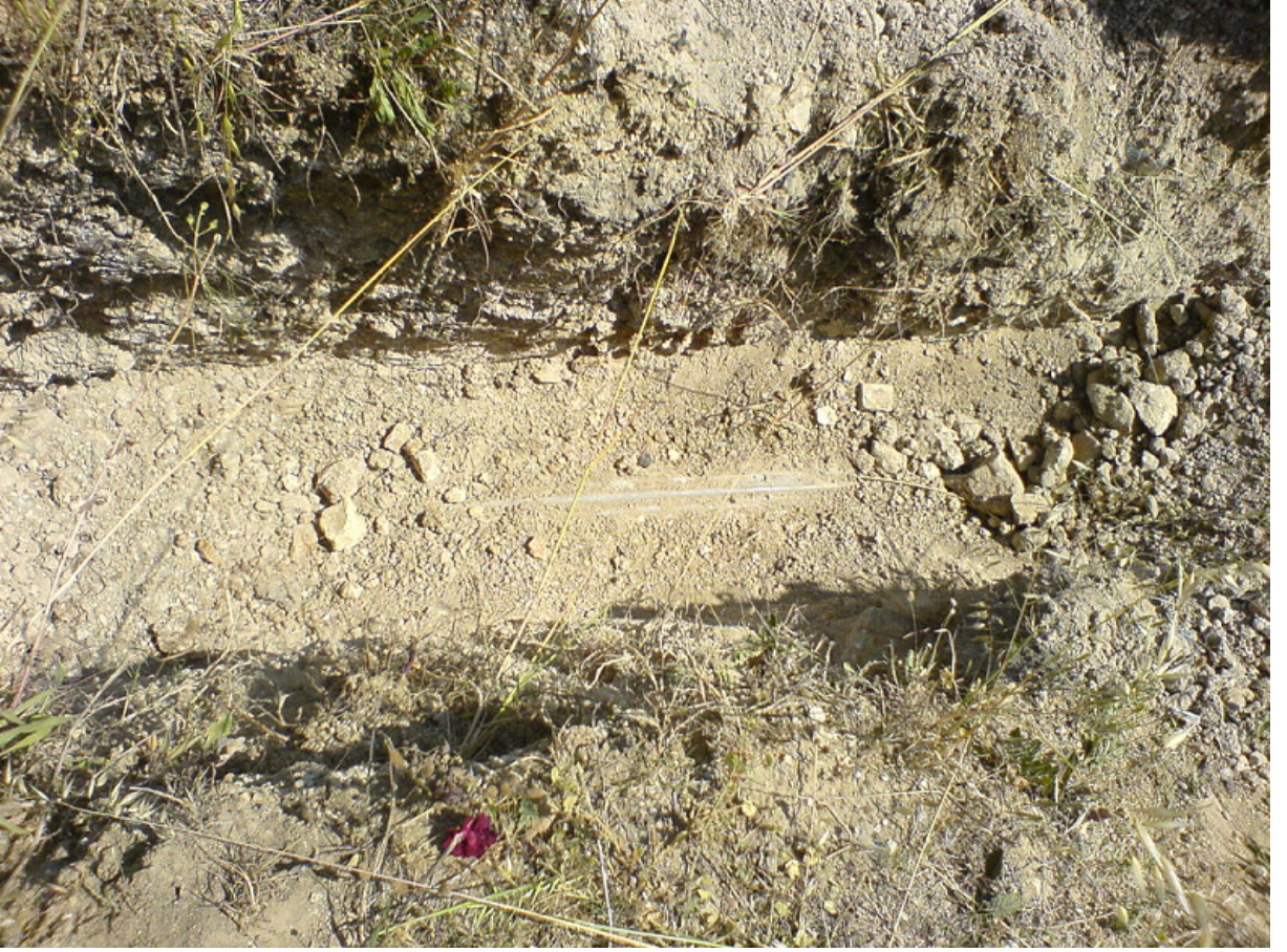
Şekil 14.4 Alüminyum kanatlı borunun toprak kapatılmadan önceki görüntüsü
