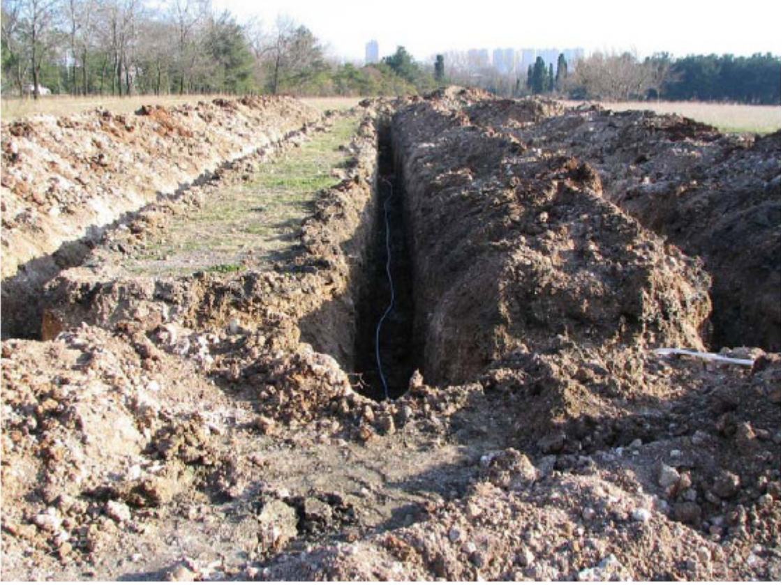
Şekil 14.2 PPRC boruların toprak kapatılmadan önce alınmış görüntüsü
