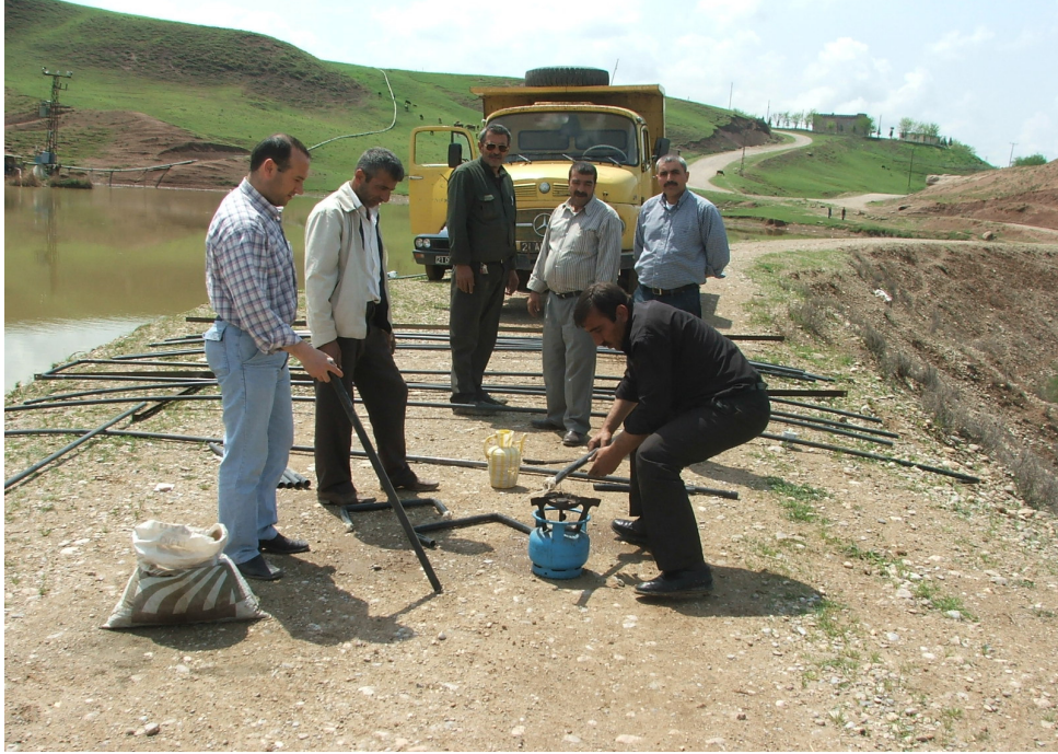
Resim 5.4 : Boru bükme işlemi
