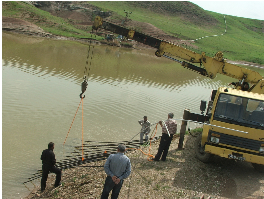
Resim 4.13 : Sistemin vinç ile suya taşınması
