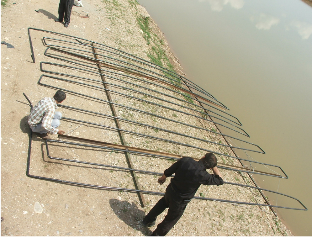
Resim 5.6 : Şasiye çelik halat çekme işlemi
