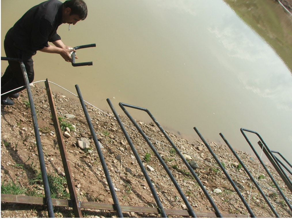
Resim 5.9 : Tesisattaki kaçakların onarımı
