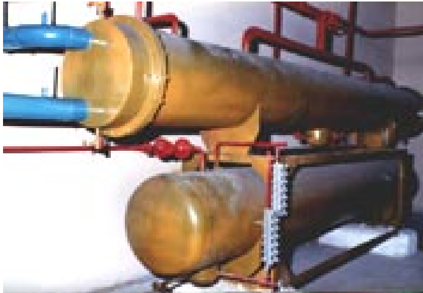
řekil 3.4 Su sođutmalı kondenser (KSI marka)
