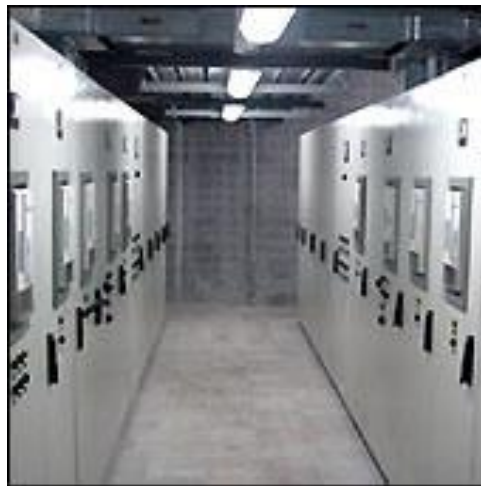
Şekil 6.2 Polat Tower Residence örnek elektrik panoları [31]
