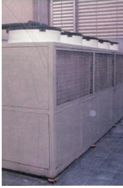
Şekil 4.13 Hava soğutmalı çiller (küçükçalı, 2007)
