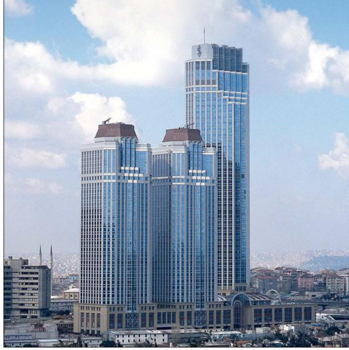
Şekil 6.6. İş Kuleleri dış görünüş [51]
