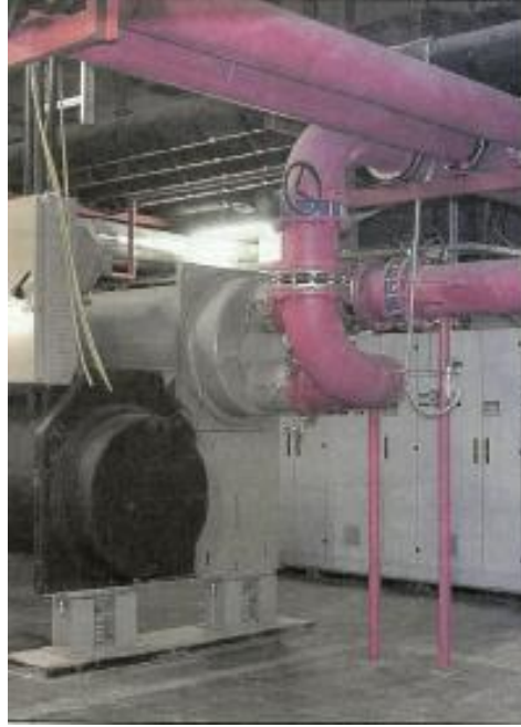
Şekil 4.12 Su soğutmalı çiller (Küçükçalı, 2007)
