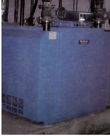
Şekil 4.6 Atmosferik brülörlü kazan (Küçükçalı, 2007)
