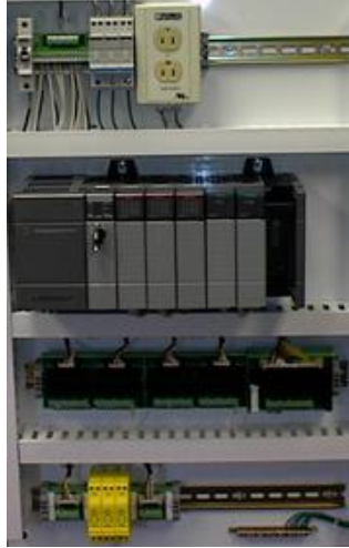
Şekil 5.1 PLC örneği [51]
