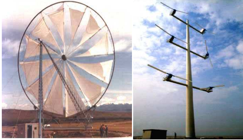
Şekil 3.15 Soldan sağa ABD’de kurulmuş deneme amaçlı rüzgâr türbini, Hollanda’da kurulmuş altı rotorlu rüzgâr türbini
