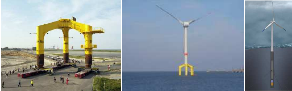
Şekil 3.6 Soldan sağa; üç kirişli (tripile) offshore türbin temeli, üç kirişli türbin temelinin üzerine türbin monte edilmiş hali, yakın gelecekte kullanılması planlanan yüzer tip offshore türbin temeli (Molly, 2009)
