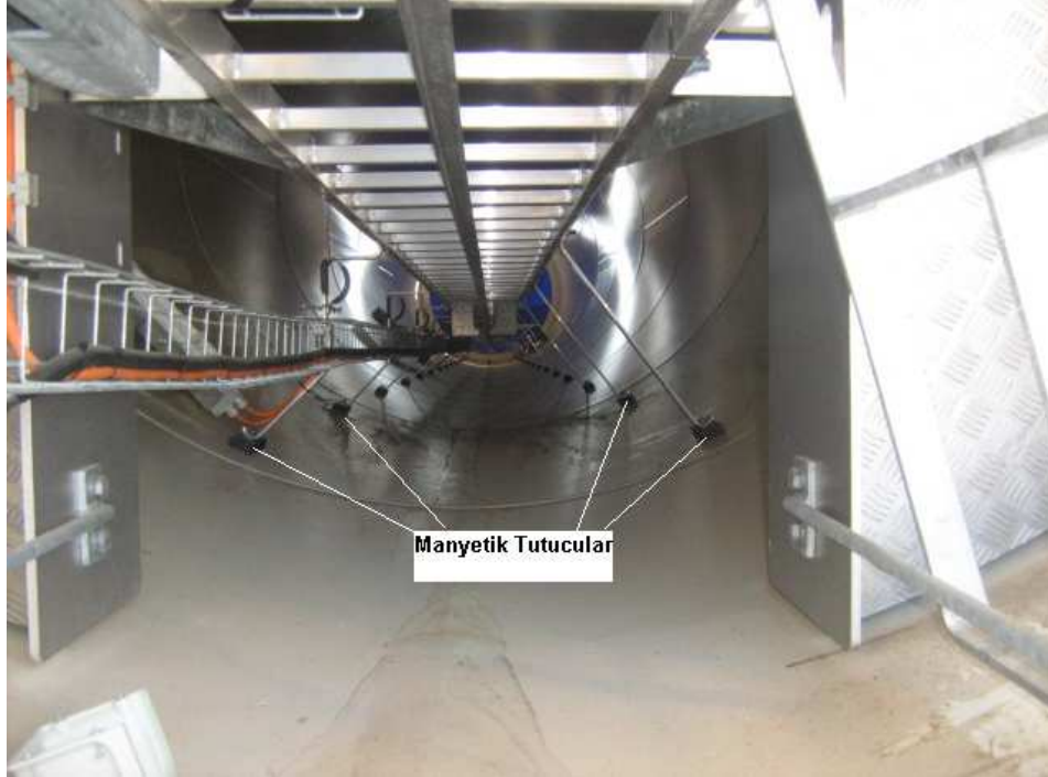
Şekil 4.6 Kule mukavemetini bozmamak için manyetik tutucularla yapılmış olan montaj.
