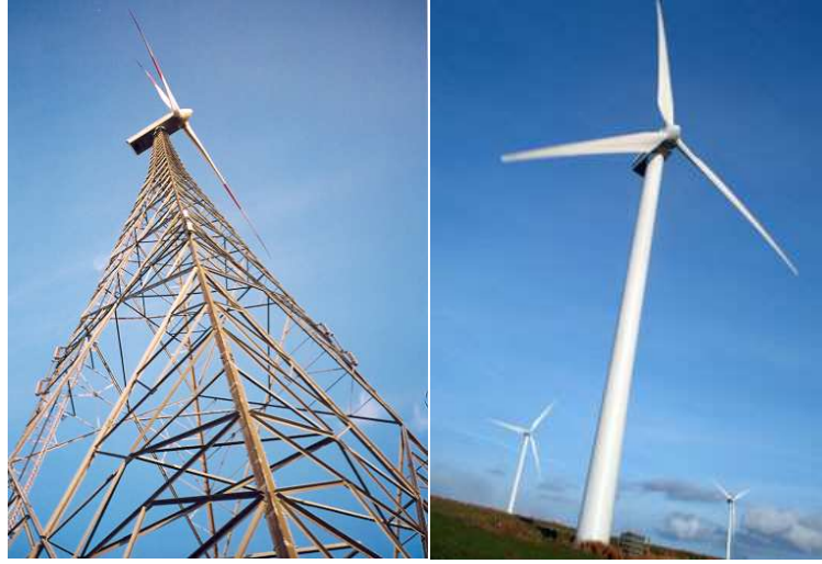
Şekil 4.5 Soldan sağa kafes tipi türbin kulesi, boru tipi türbin kulesi
