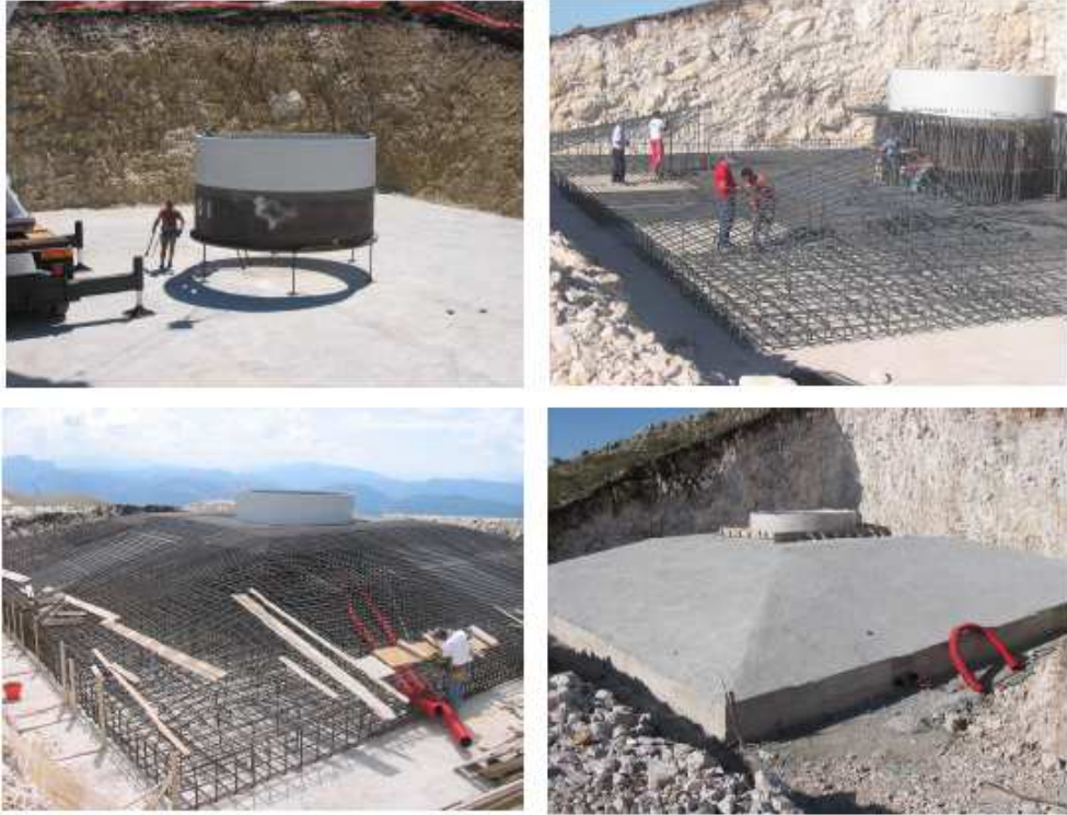
Şekil 4.4 Rüzgâr türbini temelinin yapım aşamaları
