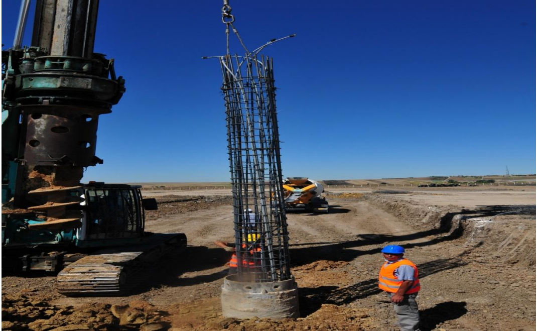
Őekil 6. 8 Destek kafesinin sondaj ukuruna yerleřtirilmesi
