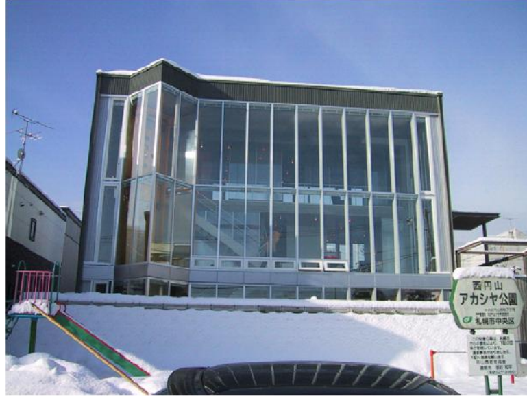
řekil 6. 14 Binanın dıř grnř
