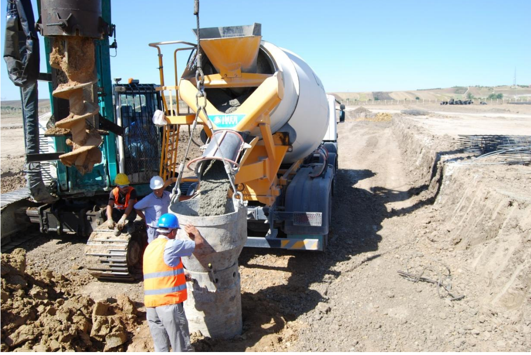
Şekil 6. 9 Huni yardımıyla harcın çukura dökülmesi
