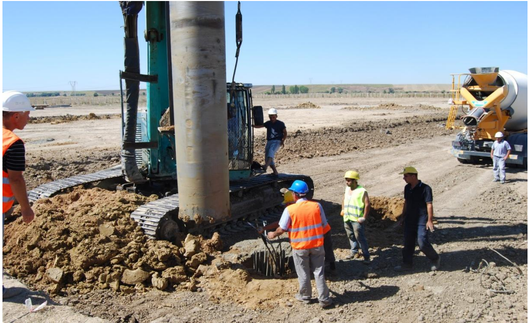
Şekil 6. 10 Muhafaza borusunun sondaj çukurundan çıkarılması
