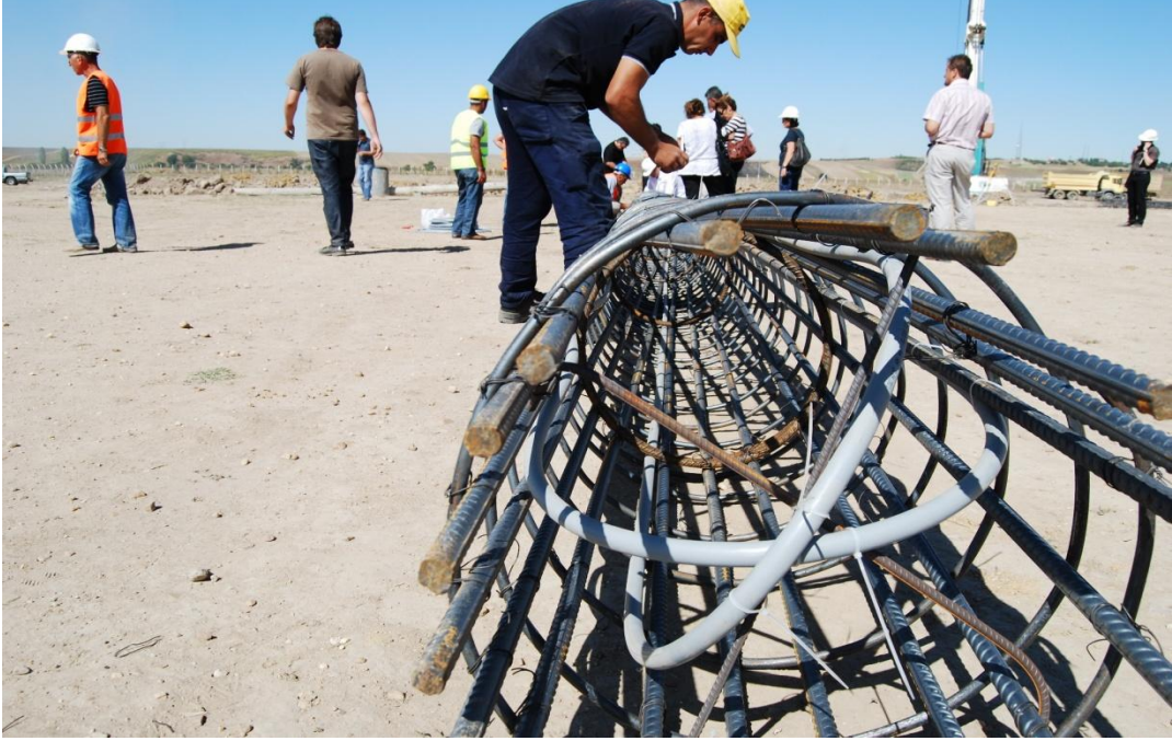
Őekil 6. 7 U-tip kazık ısı deęiřtiricilerinin kafese montajı
