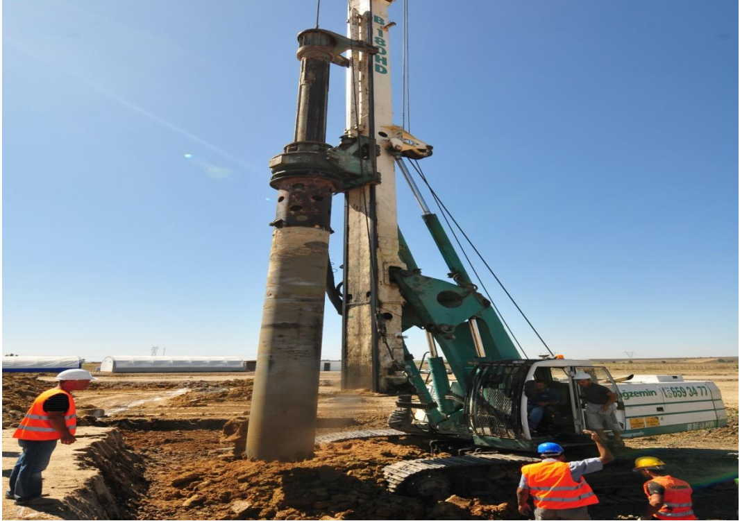
Őekil 6. 6 Muhafaza borusunun yerleřmesi ve sondaj iřlemi
