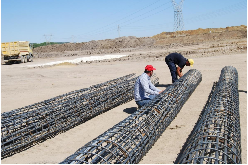
Őekil 6. 5 Destek kafesinin hazırlanması
