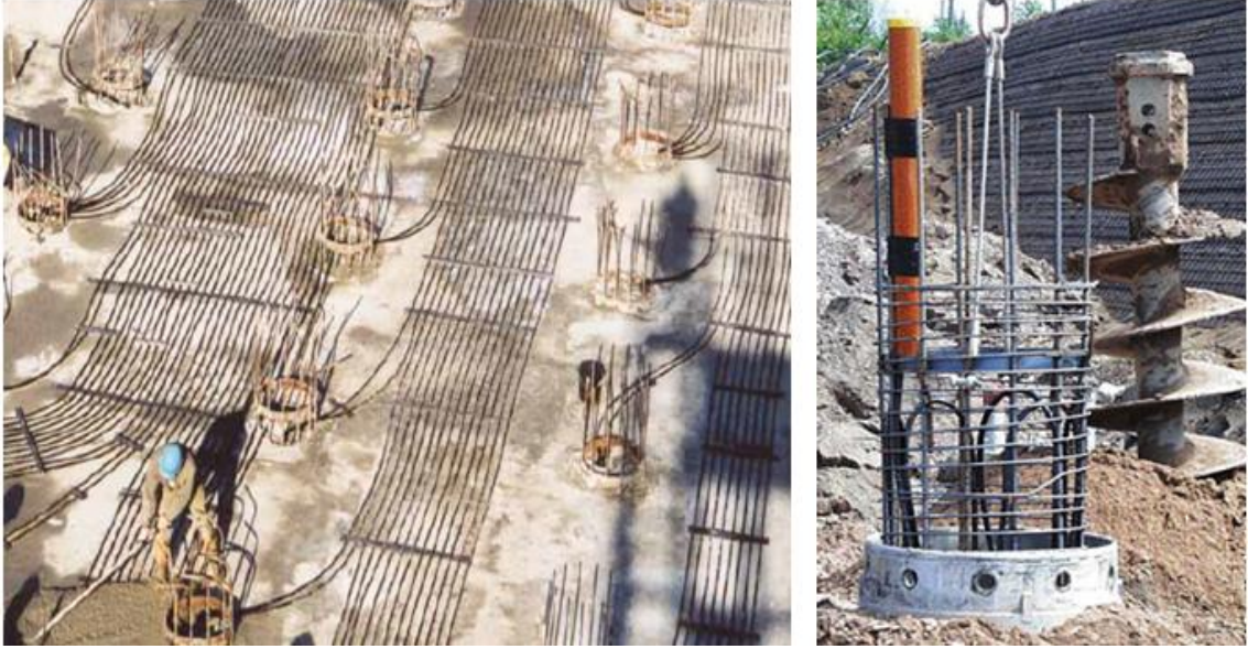
Şekil 4. 14 Zemine yerleştirilmiş enerji kazıkları
