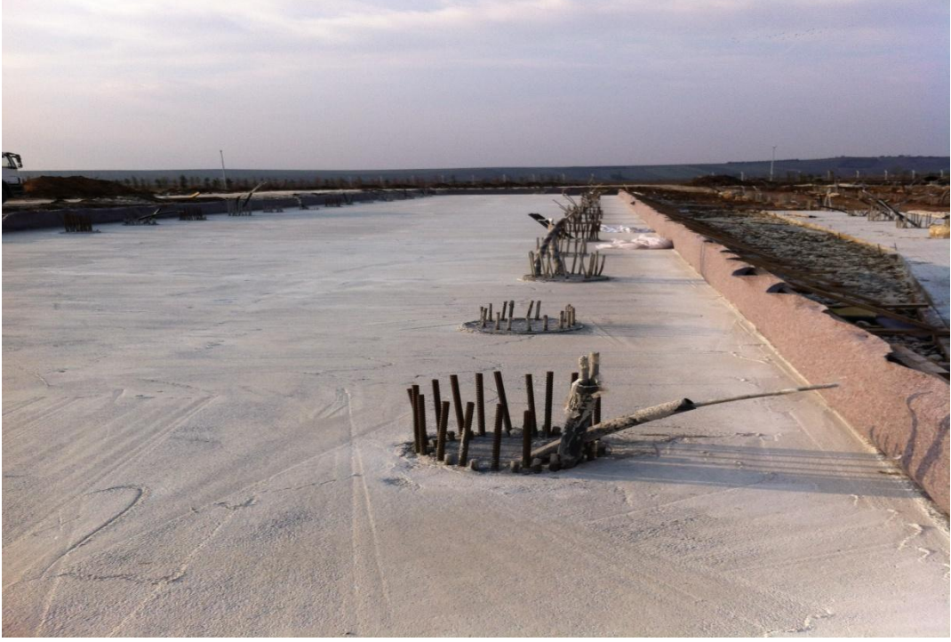
Şekil 6. 11 Enerji kazıklarının son hali
