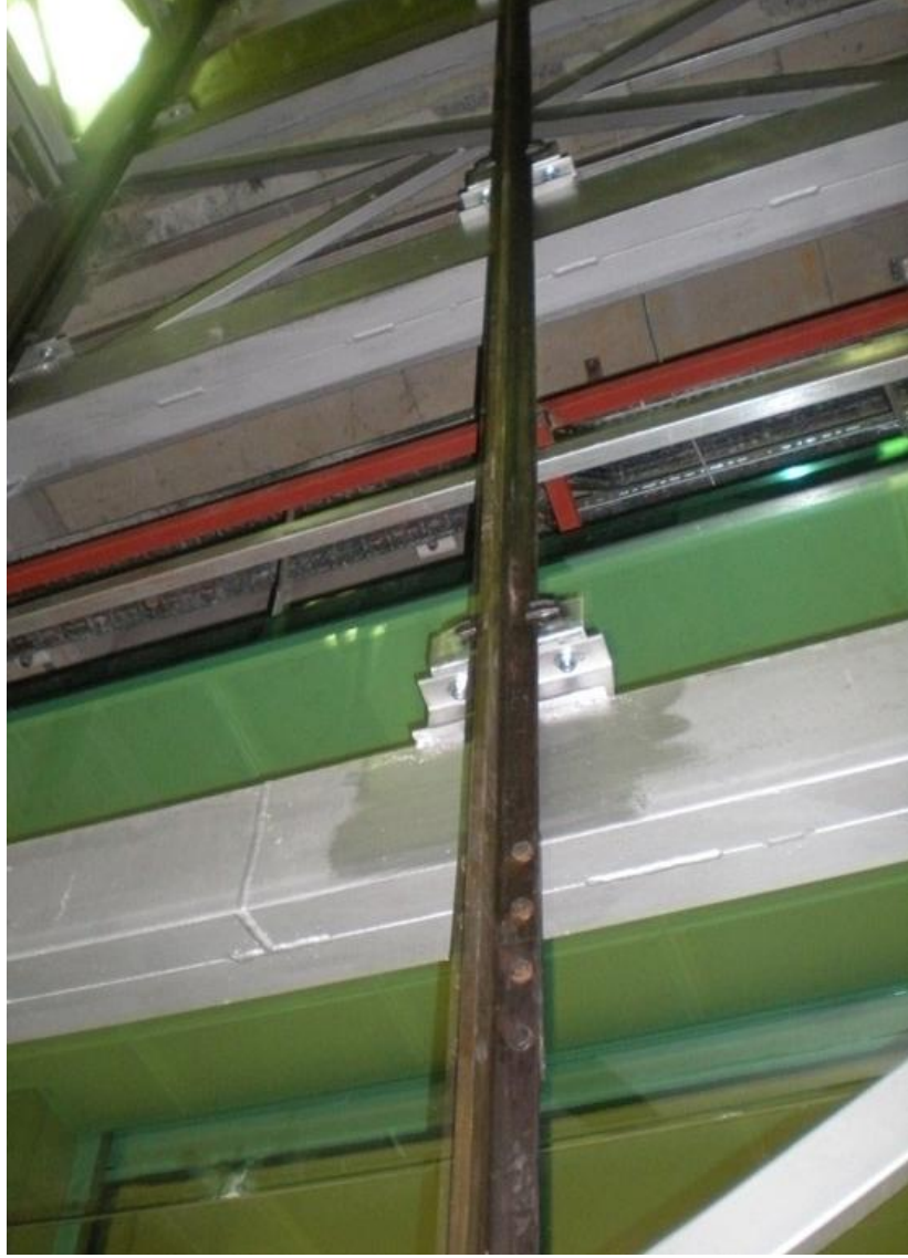
Şekil 4.5 Kılavuz ray montajı
