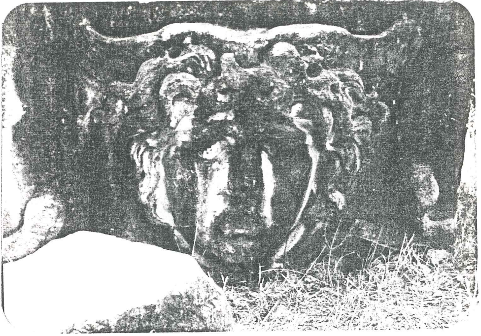
F.7-Hava Kirliliđi Sonucu Yüzeyde Oluşan Kabuk
