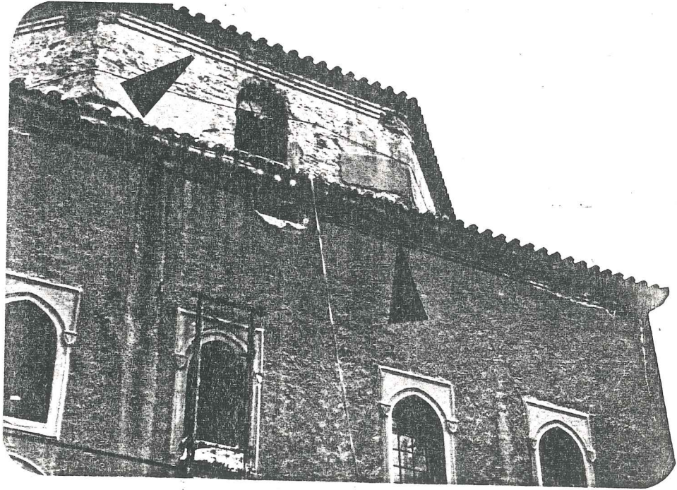
F.33- Celik Gergilerle Binanın Saęlamlařtırılması
