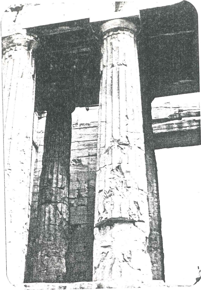
F.36-Taş Yüzeyinde Parça Kayıpları
