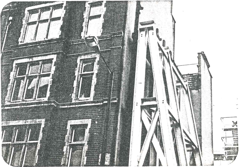
F.31- Binanın Desteklenmesi
