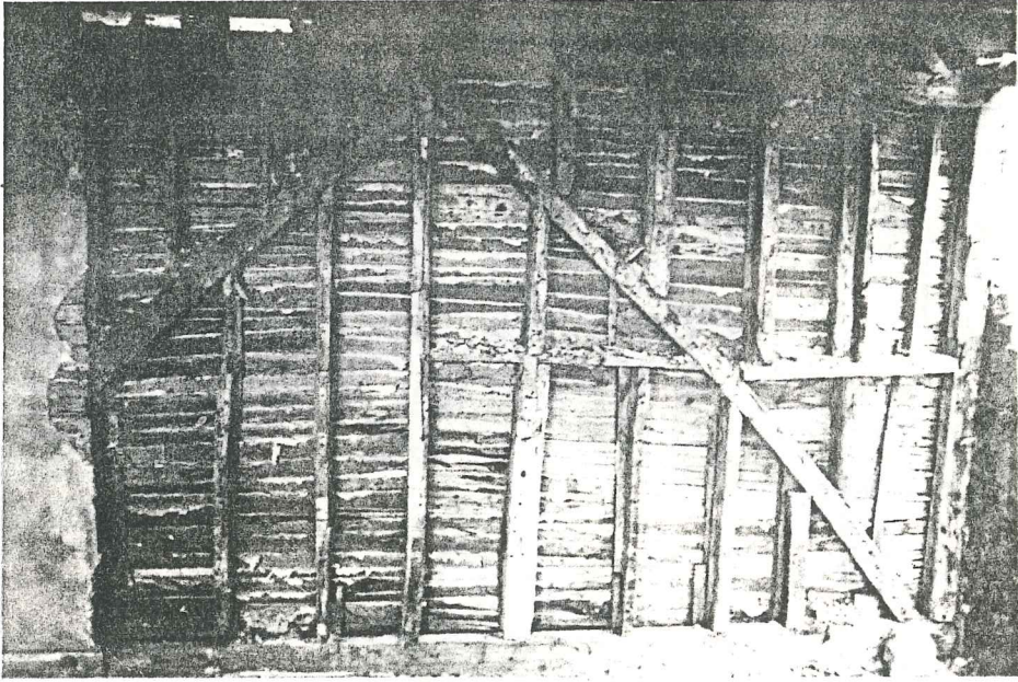
Res.94. Ahşap çatkı yönteminde iç duvar kuruluşu (Selami Efendi Tekkesi Haremliđi)
