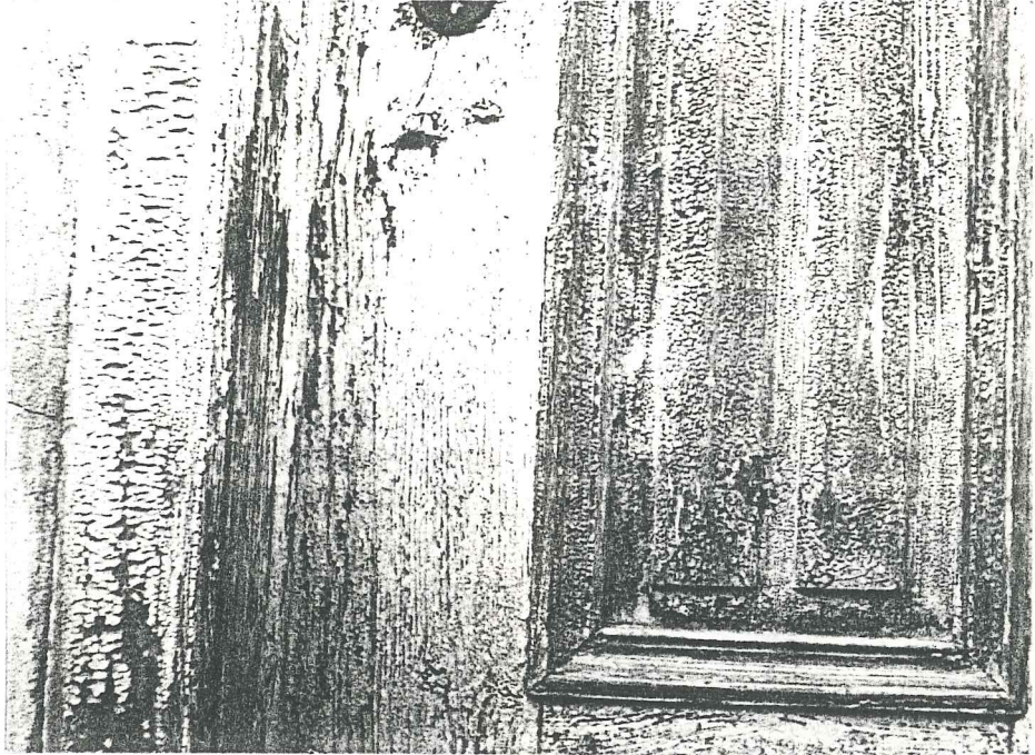
Res.104. Güneş radyasyonunun boyalı ahşap üzerindeki etkisi (Gülsuyu sokağı, ev no:2 kapısı)
