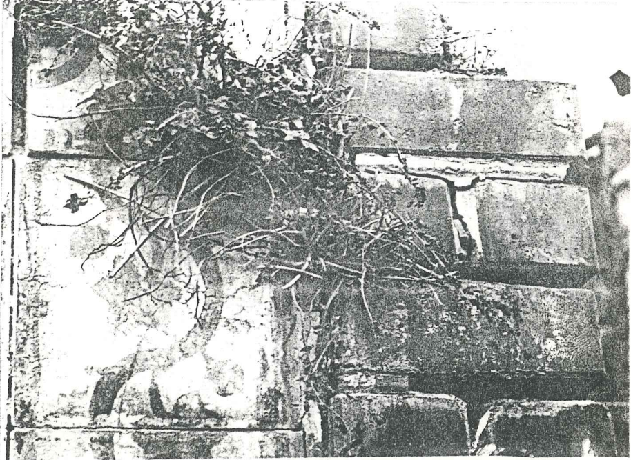
Res.100. Bitki köklerinin yapı malzemesi arasına girerek malzeme ayrışmasına neden olması örneği (Selami Efendi Tekkesi)
