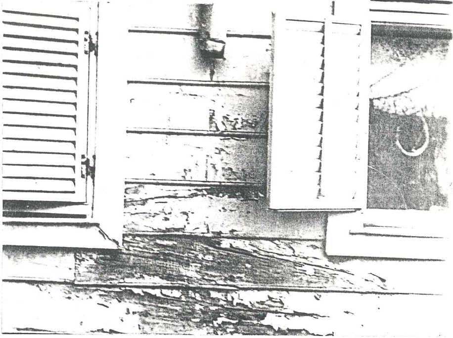
Res.106. Malzeme üzerinde su etkisi(Selami Efendi Tekkesi)
