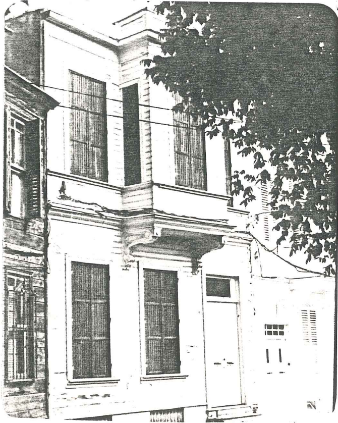
Resim 7. Ümit Sokak No: 8'deki restorasyon geçirmiş ve cep-nezi önemsiz oranda özgünlüğünü yitirmiş yapı.
