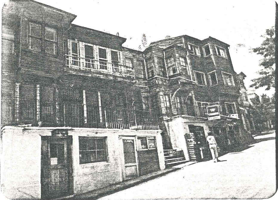
Resim 3. Refah Şehitleri Caddesi No: 25A-27-2931. Ahşap konutların alt katları işyeri olarak düzenlenmiş.
