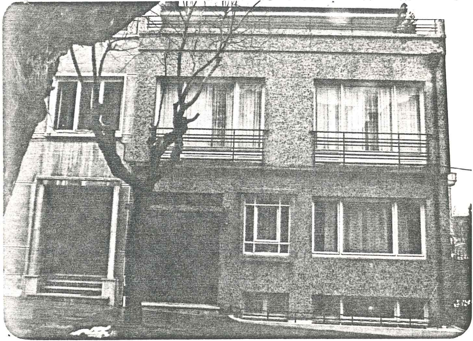
Resim 12. Refah Şehitleri Caddesi No: 50'deki kitle olarak çevreye uyumlu, cephesi aykırı yapı.
