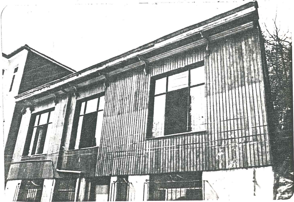
Resim 10. Şadiye Sokak No: 27'deki pencere boyut ve oranları, kaplama tahtaları deęişmiş kötü restorasyon örneklerinden bir yapı.
