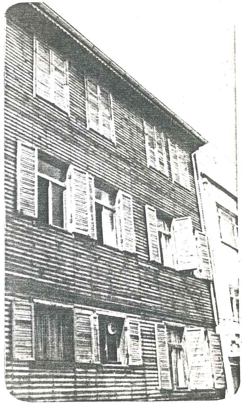
Resim 9. Şadiye Sokak No: 2'deki pencere şekil ve boyutları, kepenkleri, kaplama tahta boyutları deęiştirilmiş yapı.
