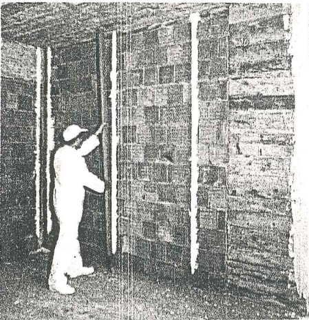
Şekil-1. Alçı sıva uygulama örnekleri
