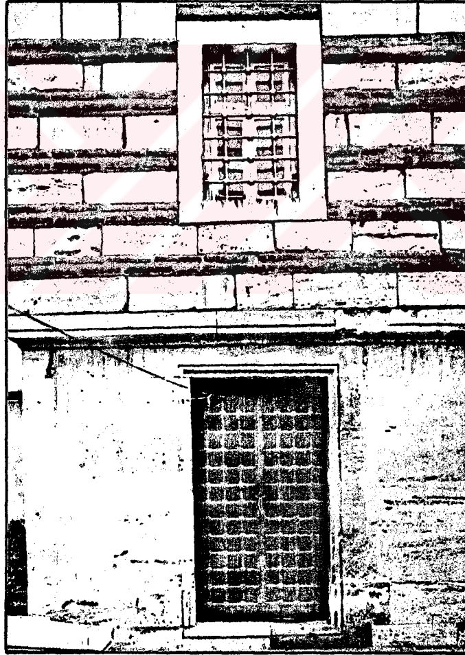
Mektebin giriş cephesinden detay
