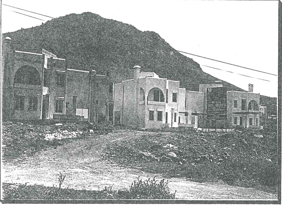
Ft. 13: 1991 yılında, kaba inşaatı tamamlanan bir bölüm kottan görünüm.
