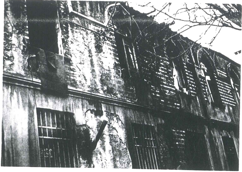
Resim 4.12 Mektep avlu cephesi.
