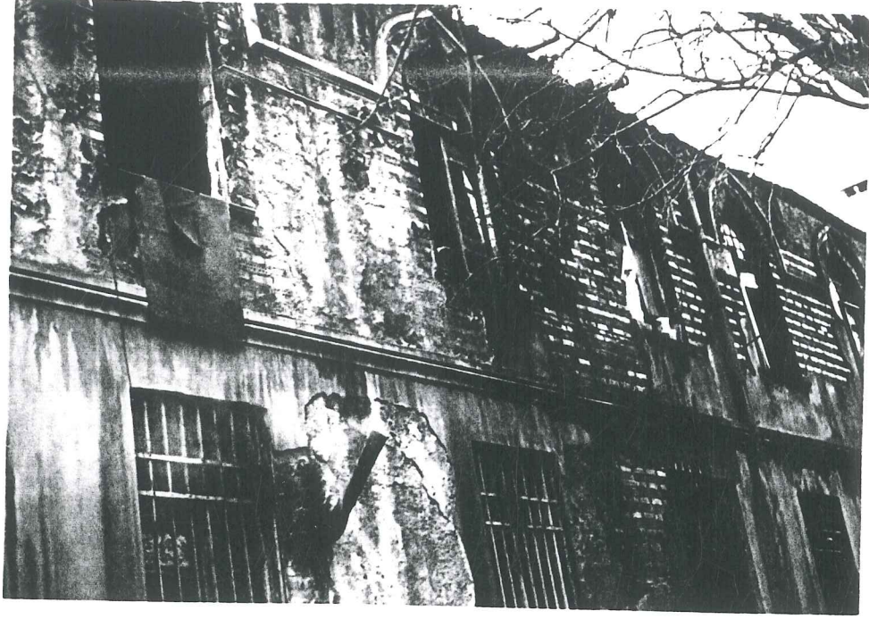
Resim 4.12 Mektep avlu cephesi.
