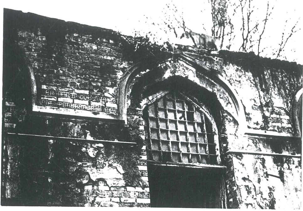
Resim 4.13 Kemerlerdeki silmeler.
