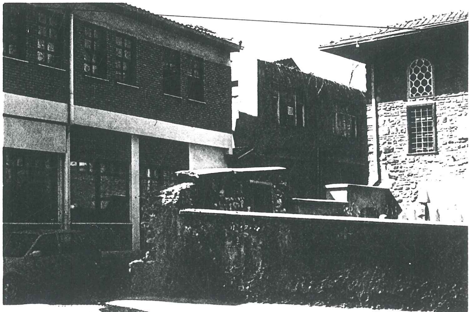
Resim 3.27 Orjinal Külliye duvarının Alemdar Caddesi'nden görünüşü.
