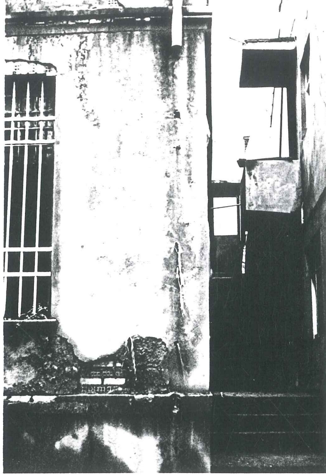
Resim 4.6 Alemdarpaşa Mektep yanındaki imam evi.
