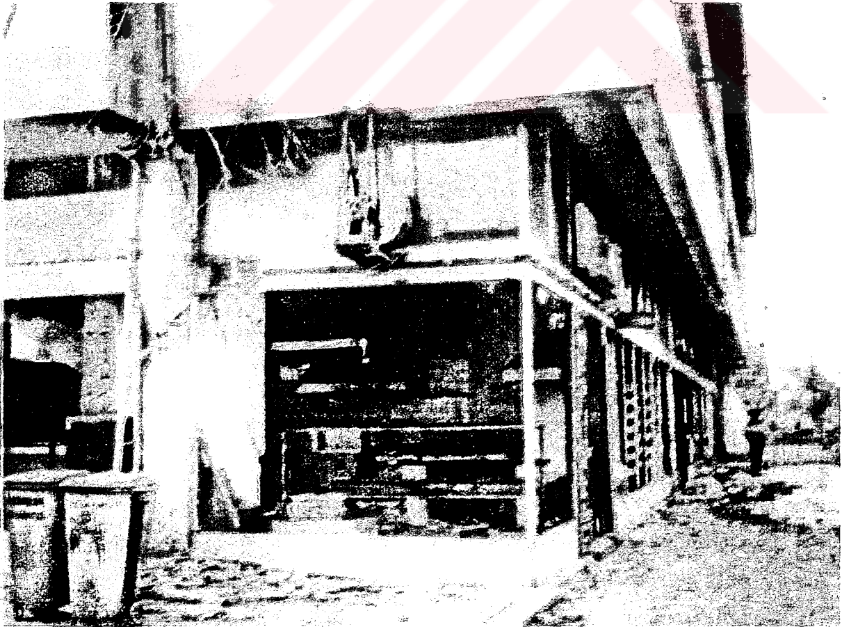
Şekil 4.2.. Yumuşak kat oluşumu.
