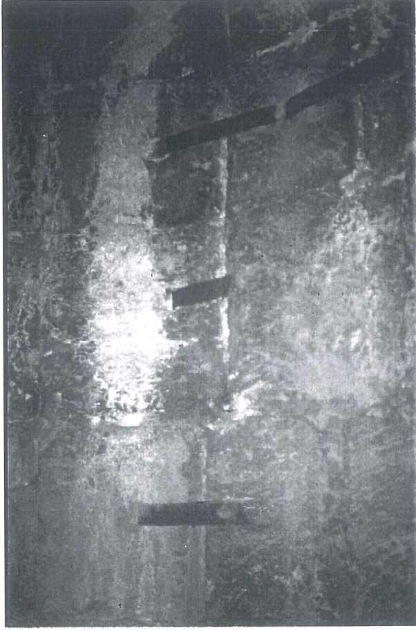
R.31.Gövde içyüzünde yapılmış demir ankrajlar.
