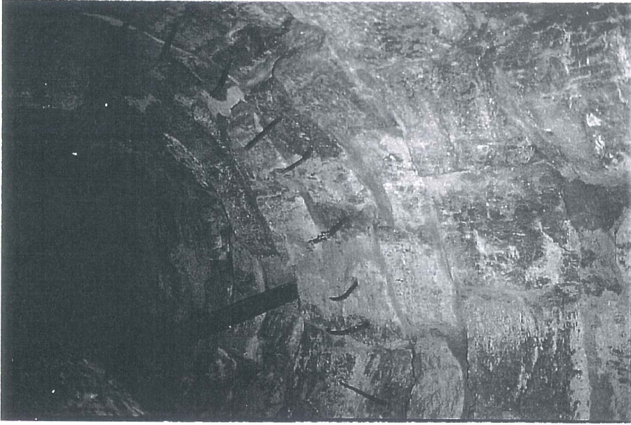
R. 38. Petek içinde uygulanmış demir ele manlar.
