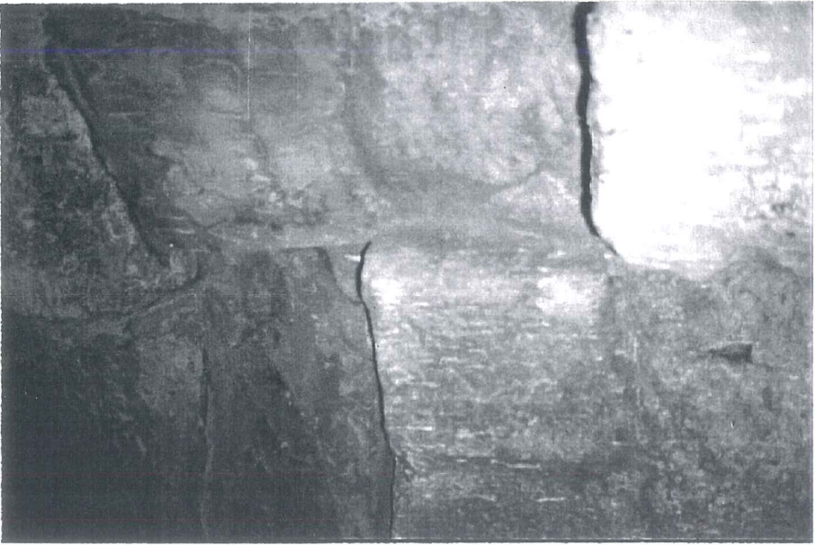
R. 37. Petek duvarının içten görünüşü.
