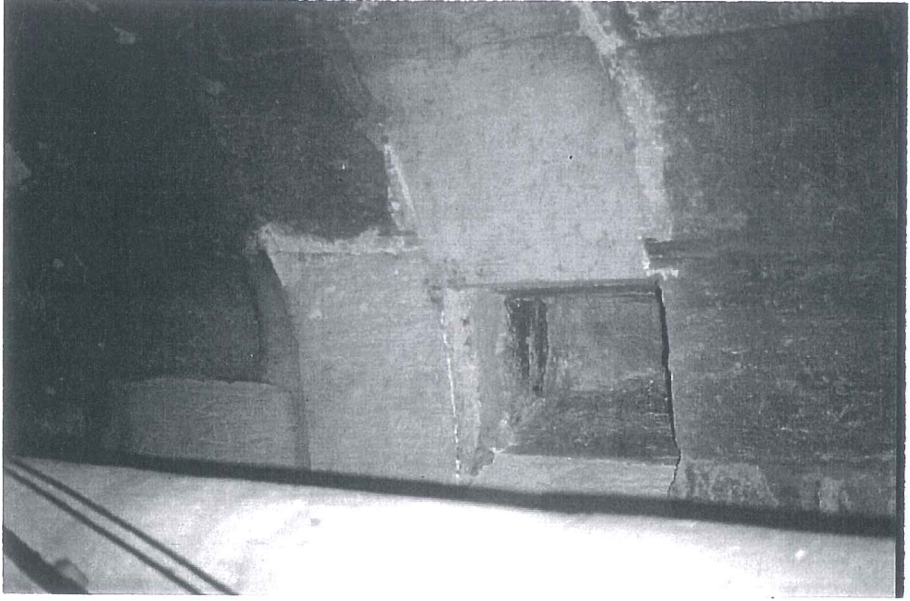
R.56. Gövde içyüzeyinde çürütme uygulaması ile yenilenmiş tas yüzeyleri.
