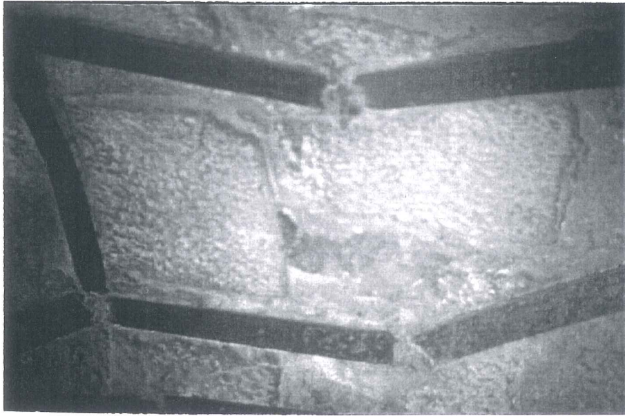
R.44.Gövde içiündeki demir bağlantı elemanları.
