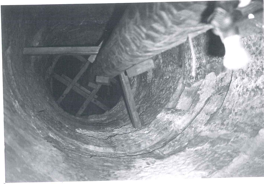
R.7. Petek bölümü ve külâhın içten görünümü
