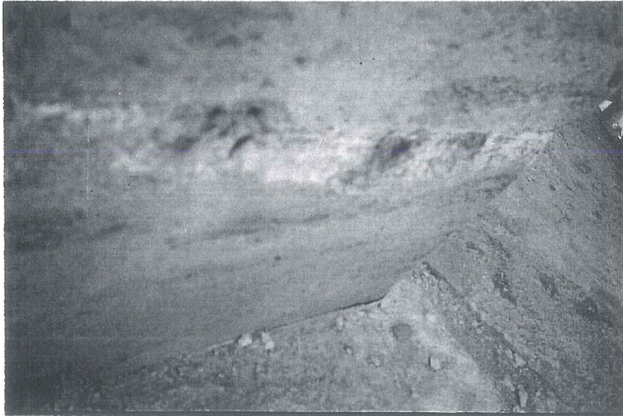
R.48. İkinci gövde dışyüzünde, şerefetabanına yakın malzeme bozulması.
