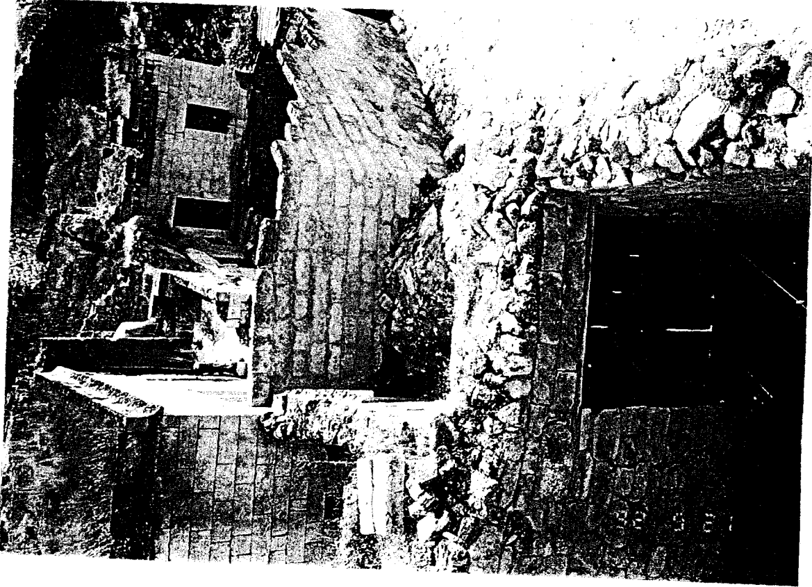
Resim a:Ek binanın restorasyon öncesi görünüşü
