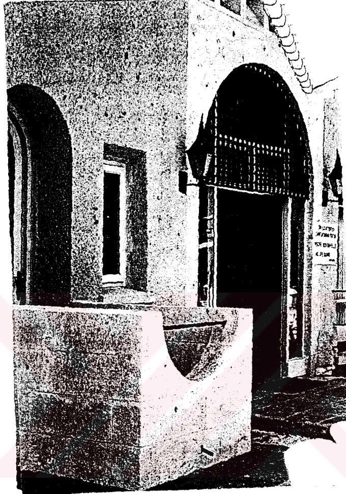
Resim 5.47: Oda cephesi ve havuz giriş kapısı.
