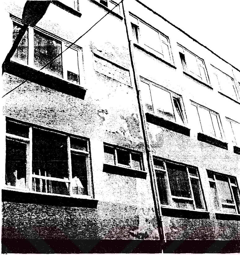
Resim 4.25 Kondansasyon sonucu duvar yüzeyinden boyanın dökülmesi ve sıva yüzeyinde oluşan lekelenmeler.
