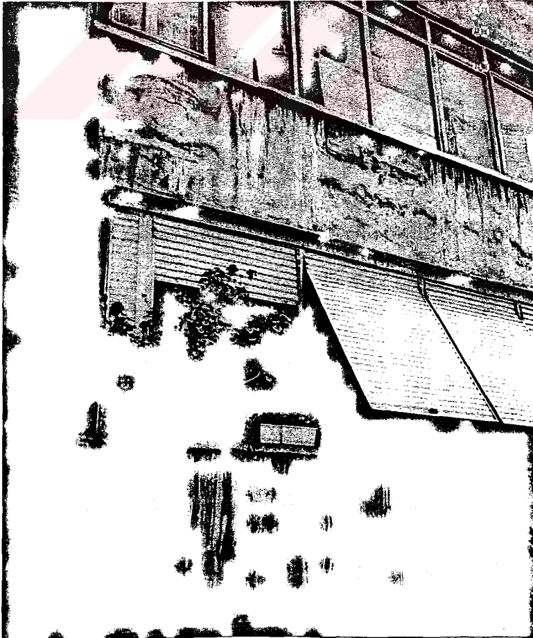
Resim 4.14 Parapet duvarında hatalı detaylandırma sonucu suyun oluşturduğu lekelenmeler.
