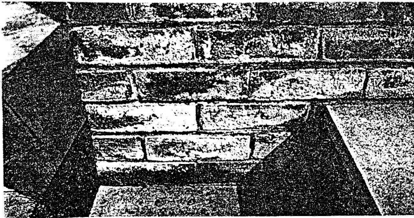
Resim 4.1 Çiçeklenmenin duvar yüzeyindeki etkisi
