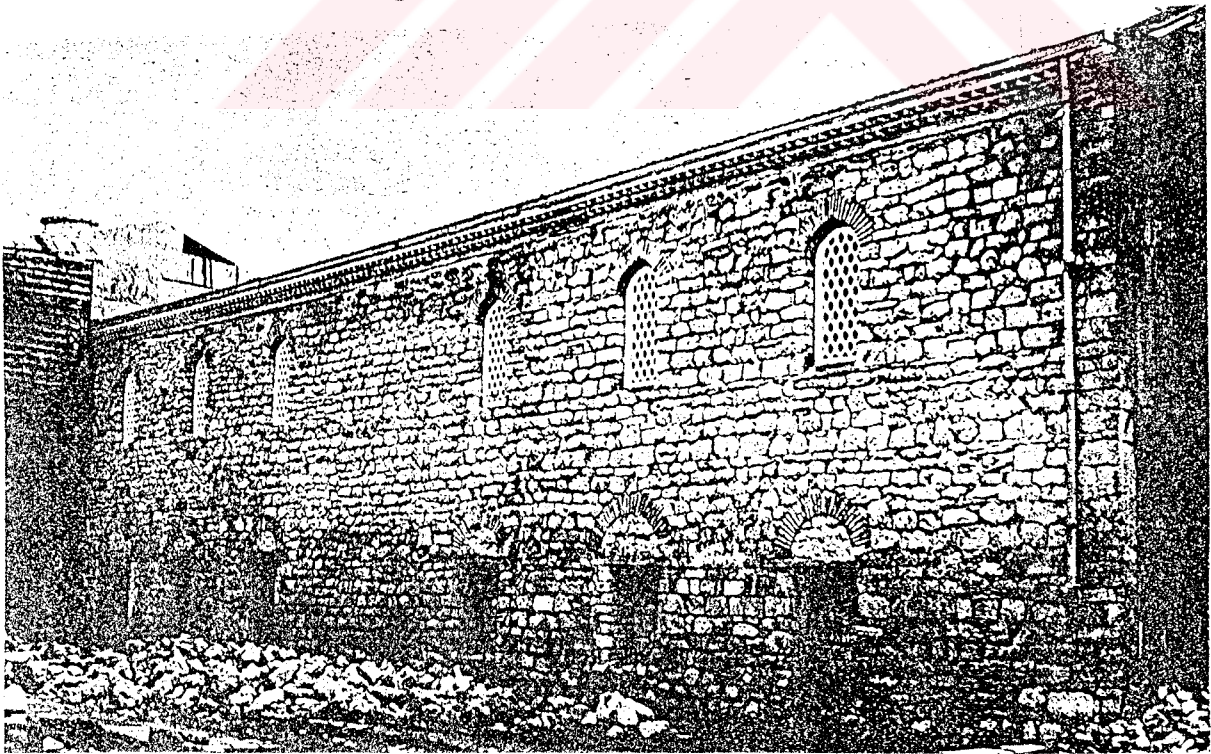
Resim 4.37 Yağhanenin restorasyon sonrası durumu (Öz, 1949).
