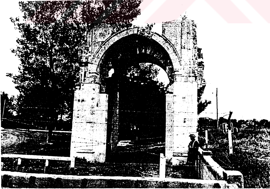
Resim 4.1 Askeri bölge içinde kalan Bab-üs Saade Kapısı'nın ön cephesinin bugünkü durumu.
