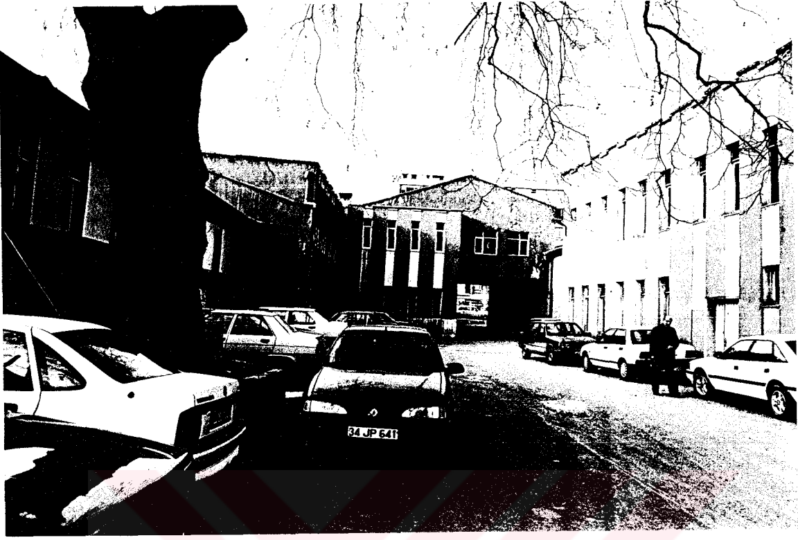
Resim 4.58 Mutfak Avlusu'nun restorasyon öncesi durumu.
