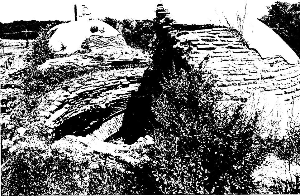
Resim 4.24 Kubbelerin bugünkü durumu.
