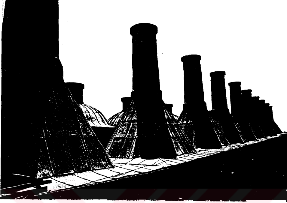
Resim 4.54 Geiş mekanını örten konik tonozlar.
