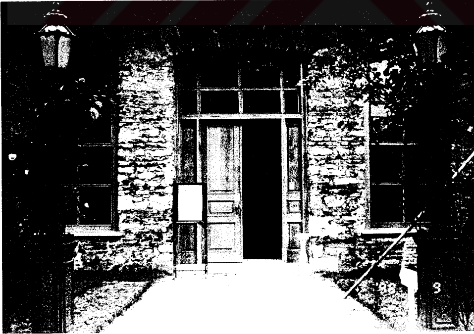
Resim 4.73 Avlu cephesinden bir kapı.
