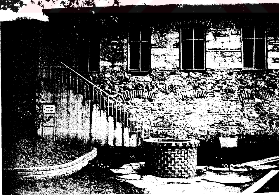
Resim 4.69 Koğuşların raspalandıktan sonraki durumu.
