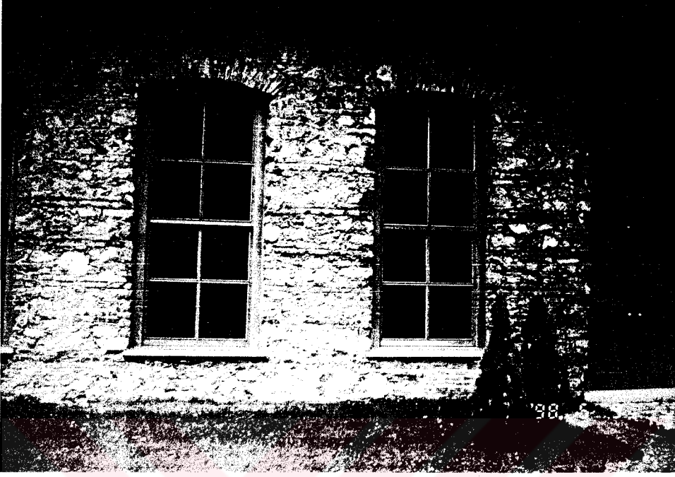
Resim 4.72 Avlu cephesi pencereleri.
