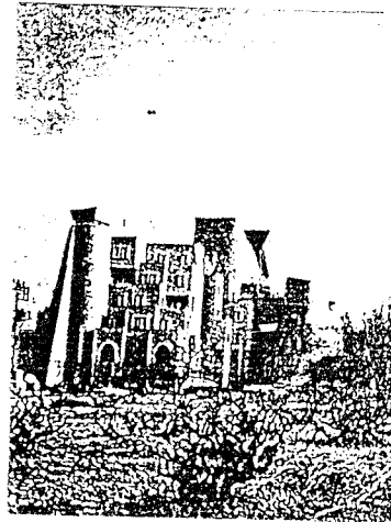
Resim 4.6 Peri Tower Otel, Nevşehir.
