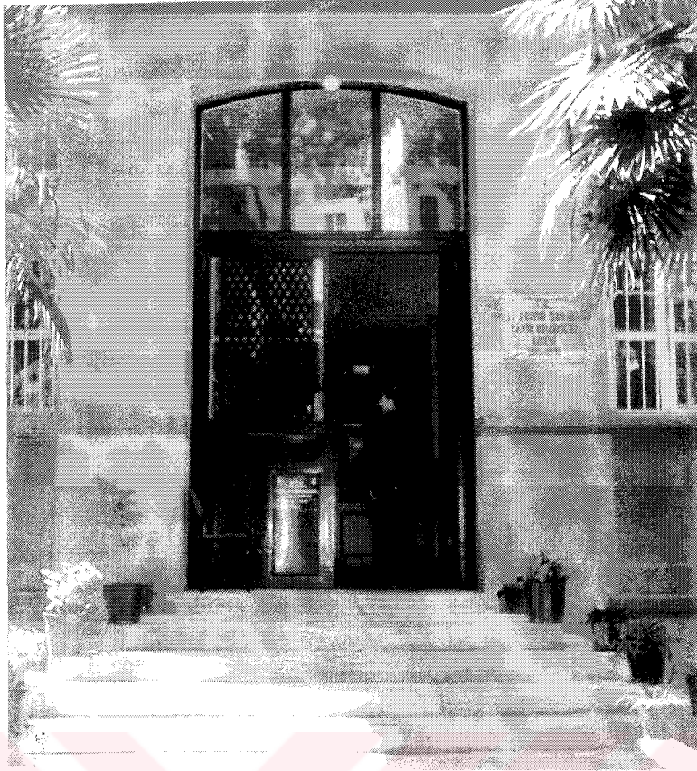
Resim 3.21 Fatih Gelenbevi Ortaokulu giriş kapısı
