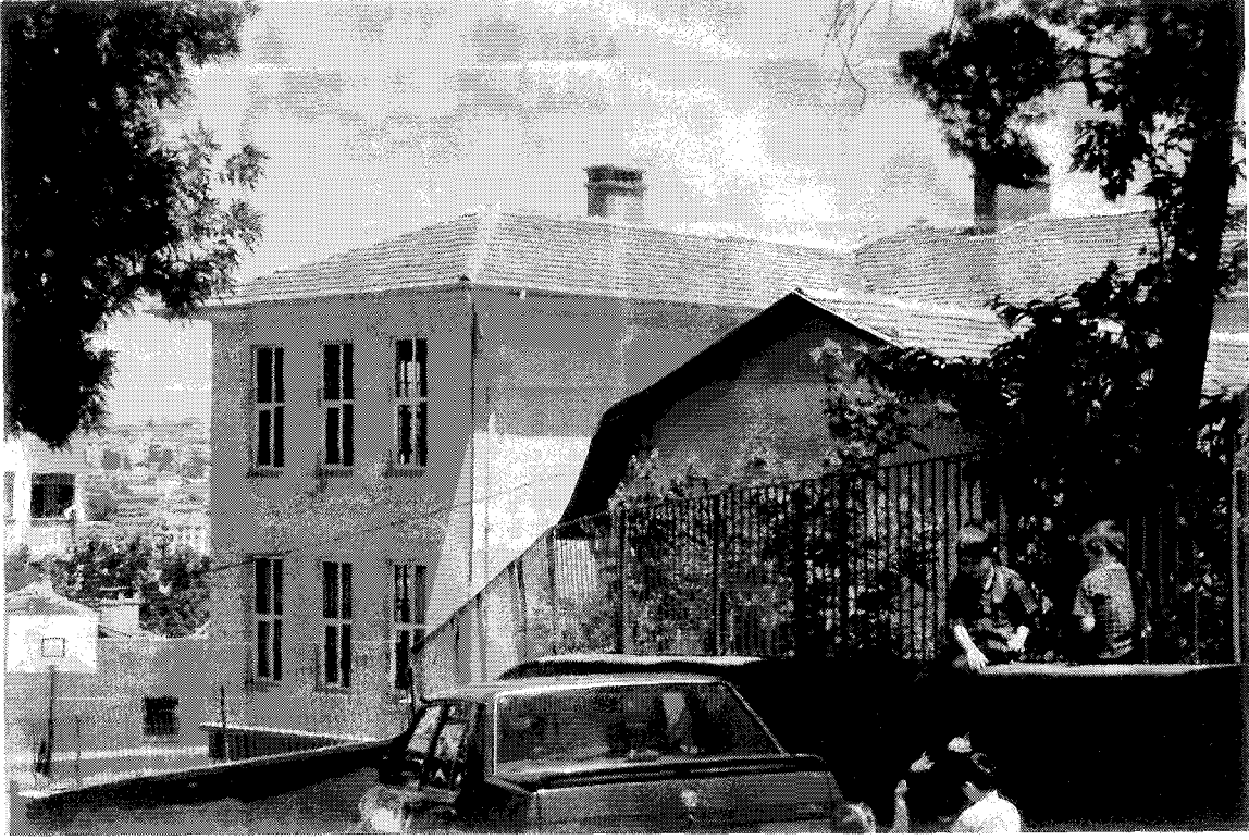
Resim 3.7 Ulubathı Hasan İlköğretim Okulu arka cephe
