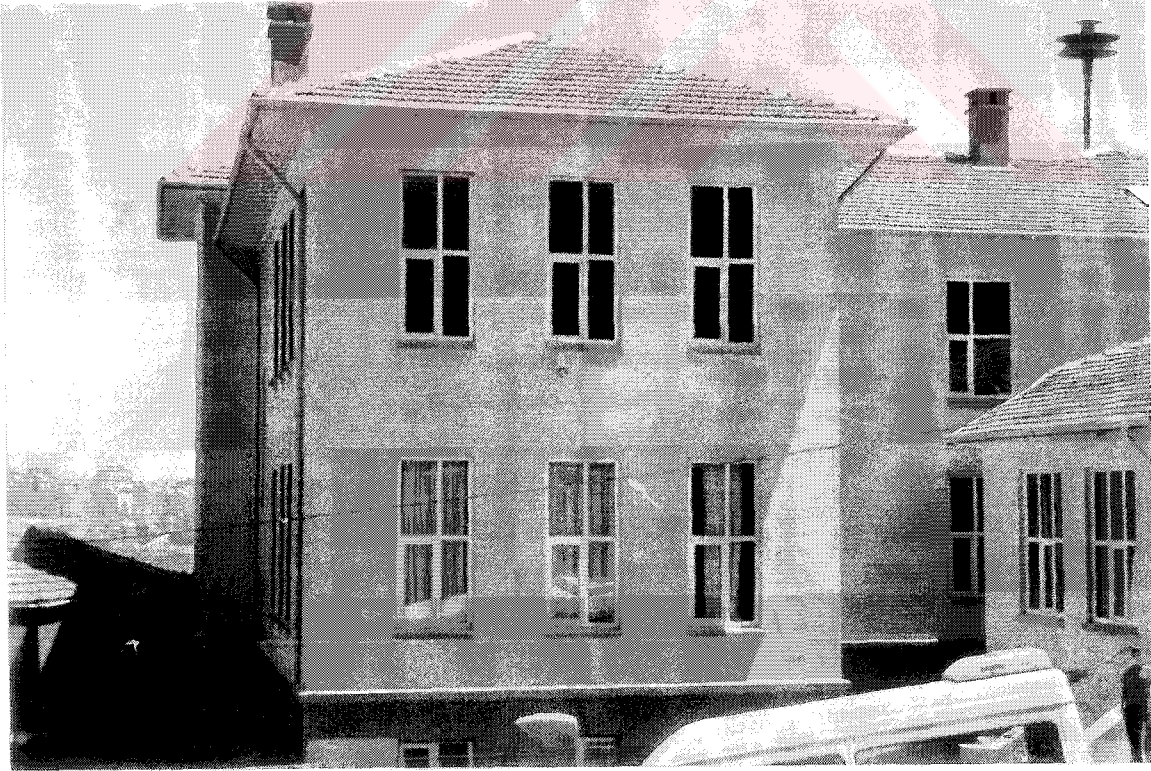
Resim 3.8 Ulubathı Hasan İlköğretim Okulu arka cephe
