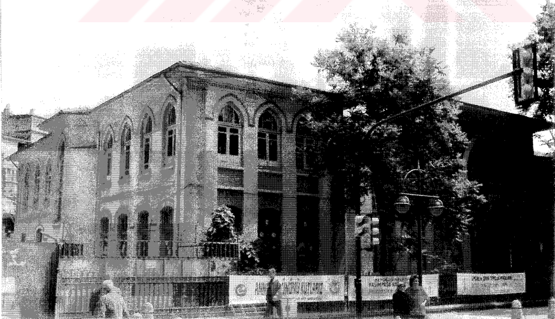
Resim 2 Ahmet Emin Yalman İlköğretim Okulu giriş cephesi
