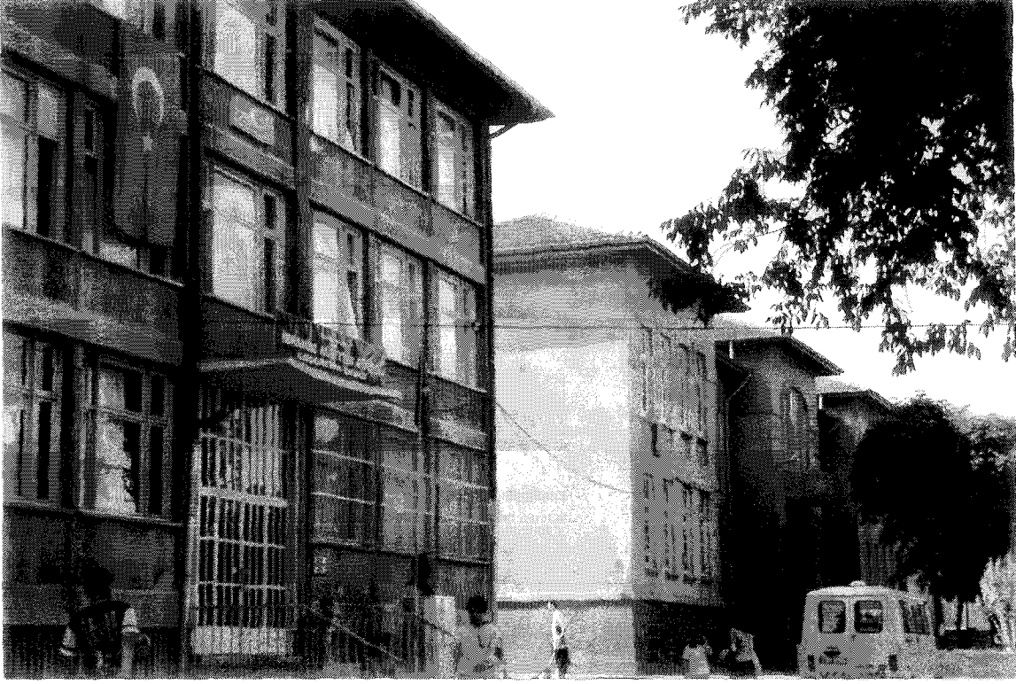
Resim 3.13 Karaahmet Paşa İlköğretim Okulu ön cephe
