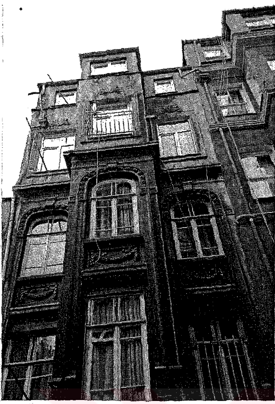
Resim Ek1.32 Beyoğlu Faikpaşa Yokuşu no:44-46
