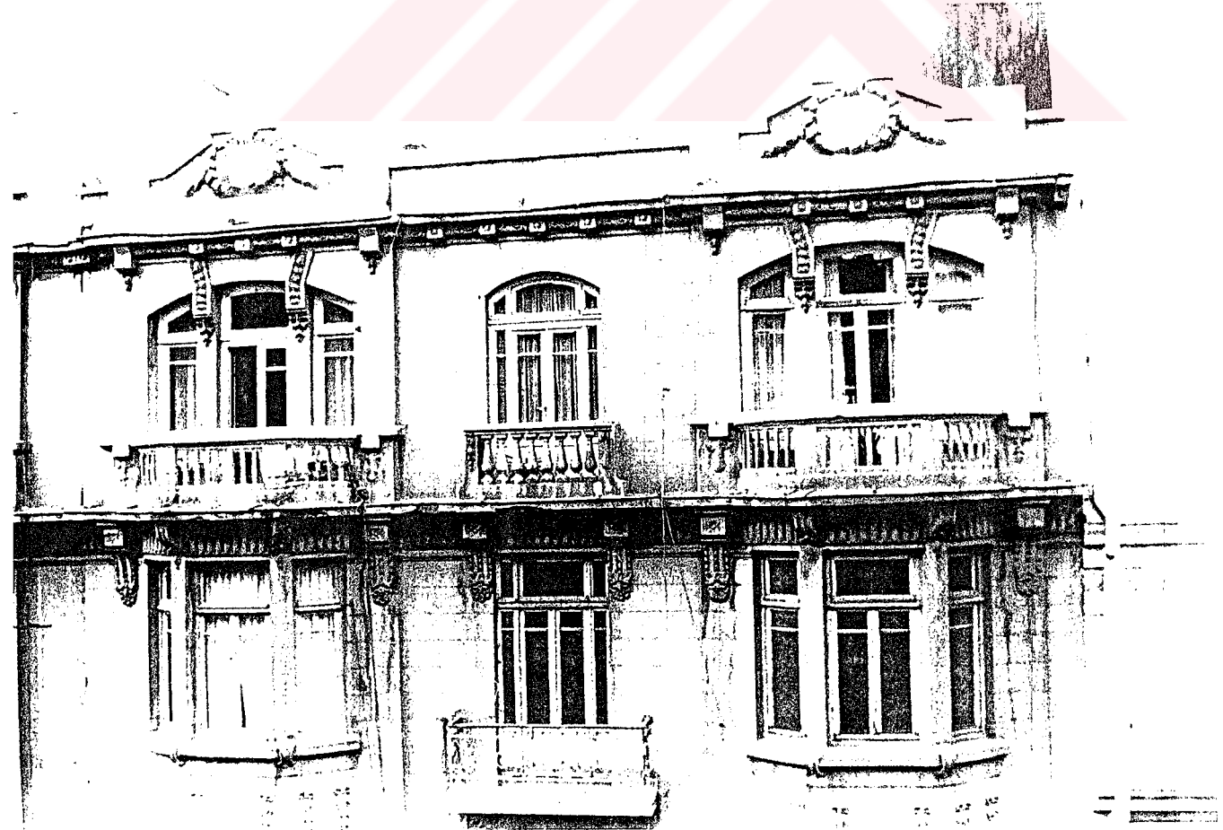
ÖN CEPHE GÖRÜNÜŞLER
