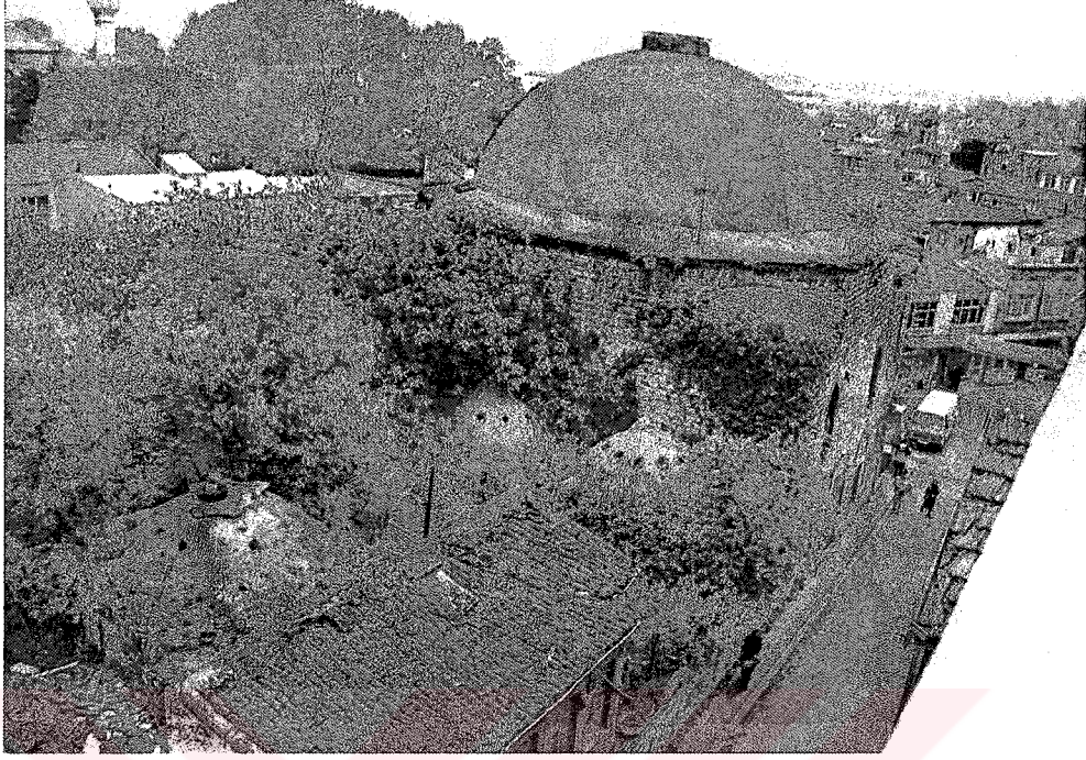
Resim 4.2 Çardaklı Hamam – Çatı görünüşü.
