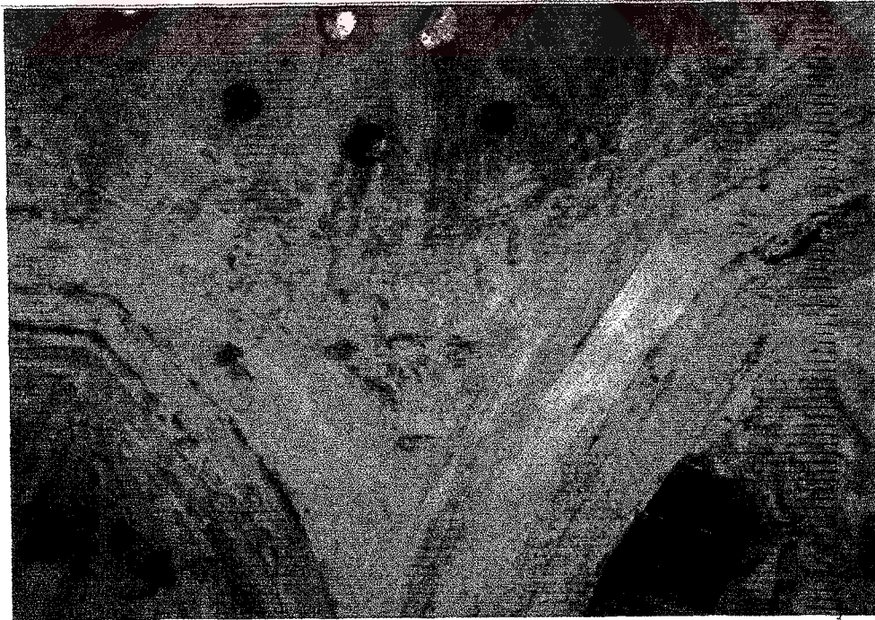
Resim 4.57 Erkekler hamamının sıcaklık mekanındaki mukarnaslar ve kemerler.
