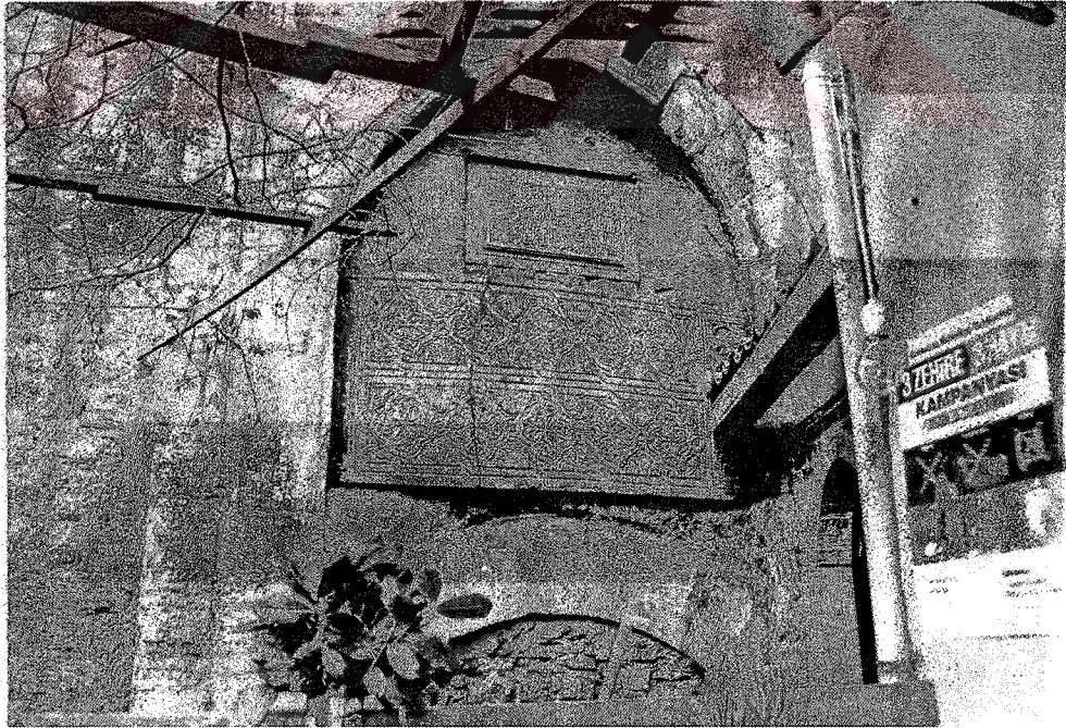
Resim 4.10 Eski giriş kapısı.
