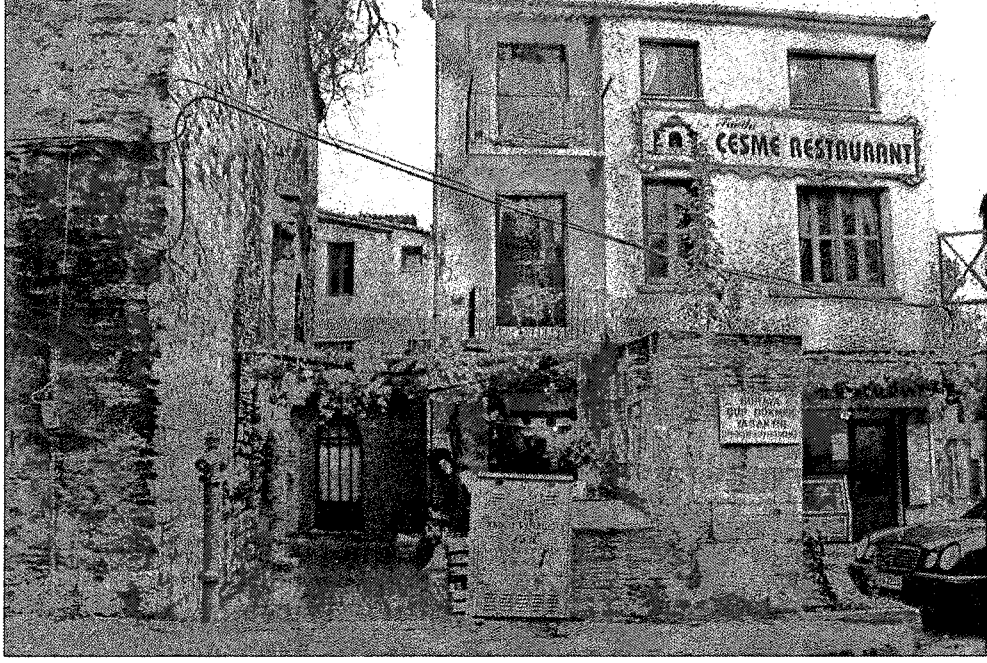
Resim 4.9 Hamamın batı cephesinde yer alan ekler.
