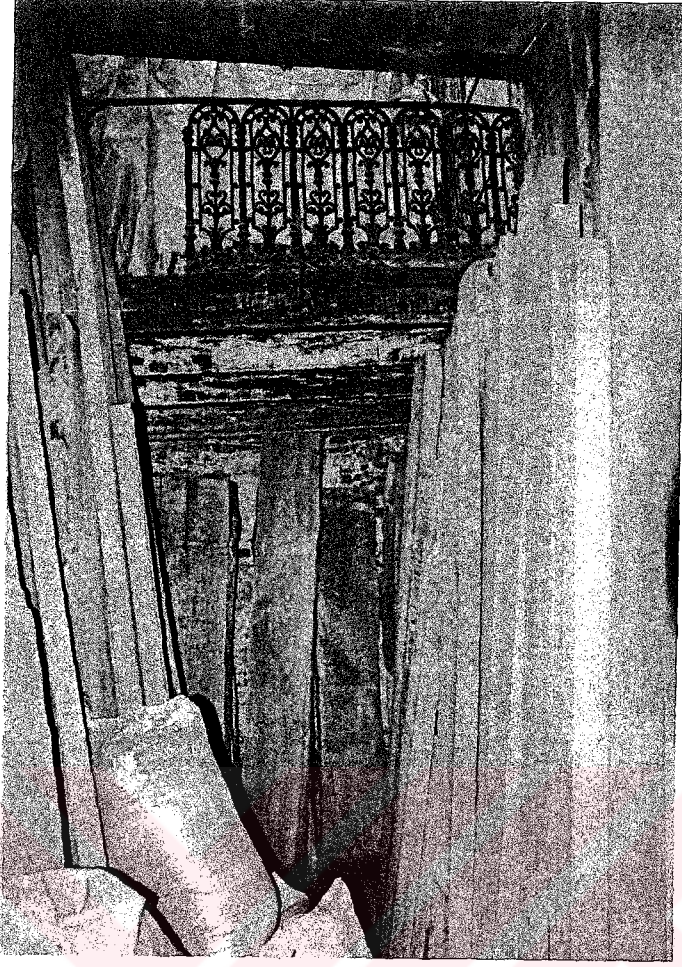
Resim 4.125 Köprüye ait dökme demir korkuluk.
