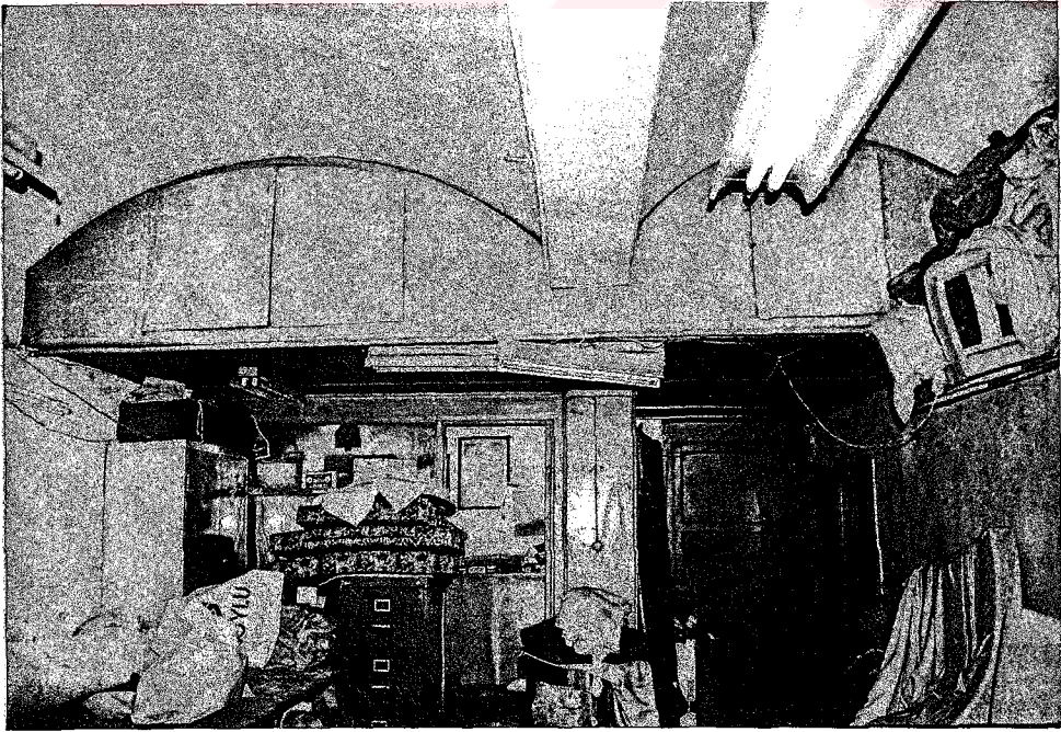
Resim 4.5 Z01 mekanının beşik tonoz örtüsü.
