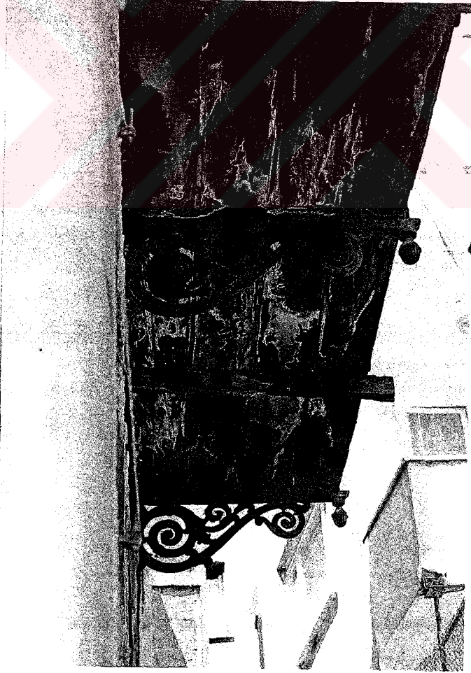
Resim 4.147 Balkonun dökme demir konsol taşıyıcıları.
