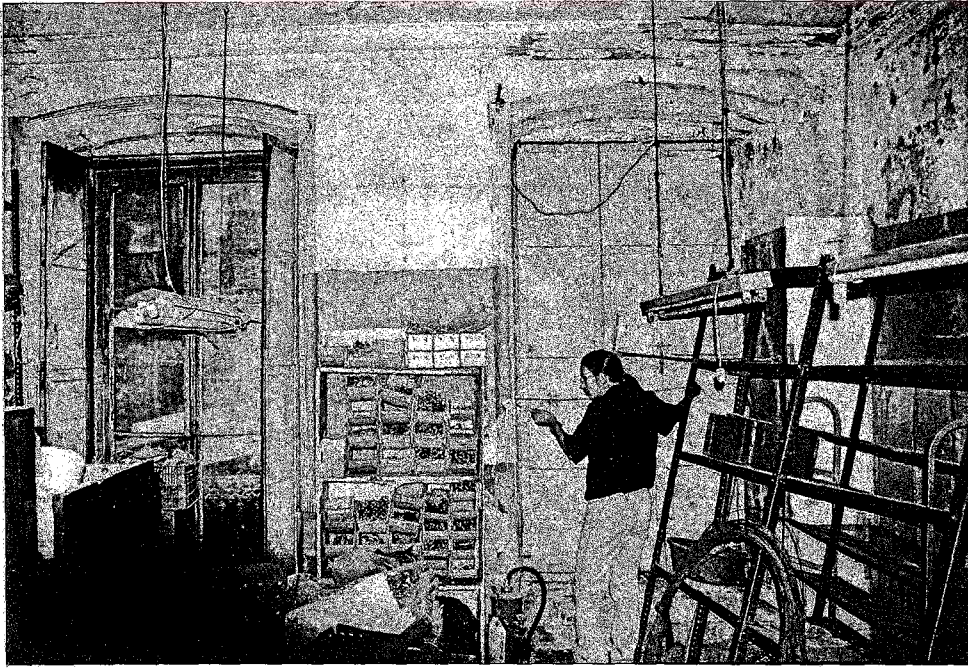
Resim 4.55 104 no'lu mekanın avluya açılan pencereleri.
