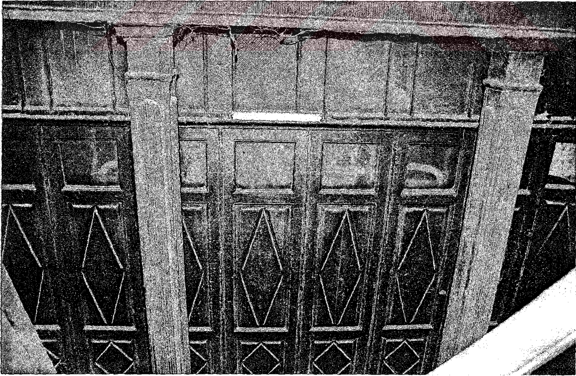
Resim 4.81 301 no'lu merdiven holü kapıları.
