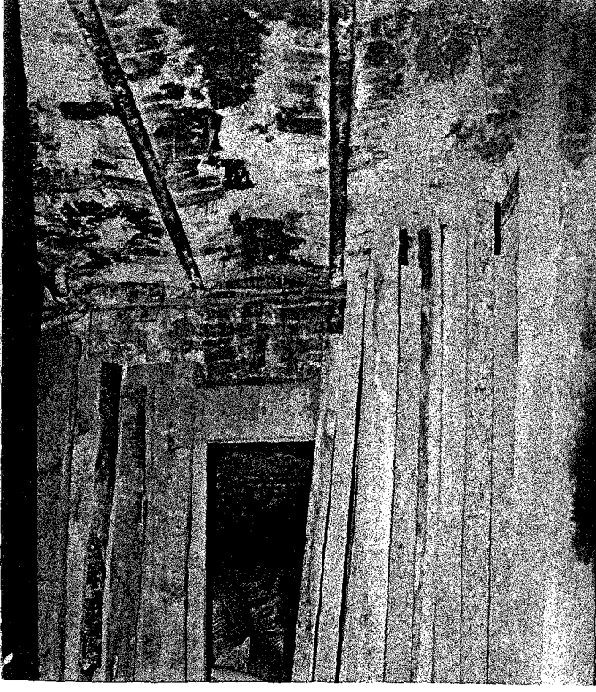
Resim 4.146 Köprüyü taşıyan putralli döşemeden ayrıntı.
