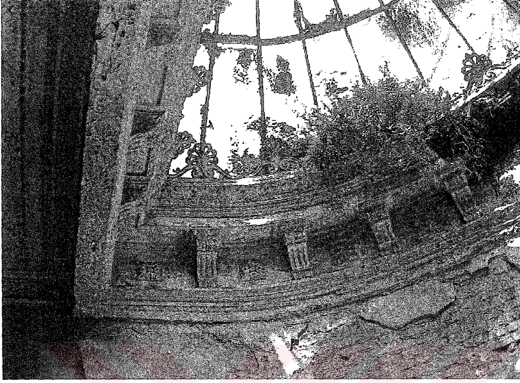
Resim 5.1 İstiklal Caddesi üzerinde yer alan Şişmanoğlu(Sismagleon) Binası çatı ışıklığı.
