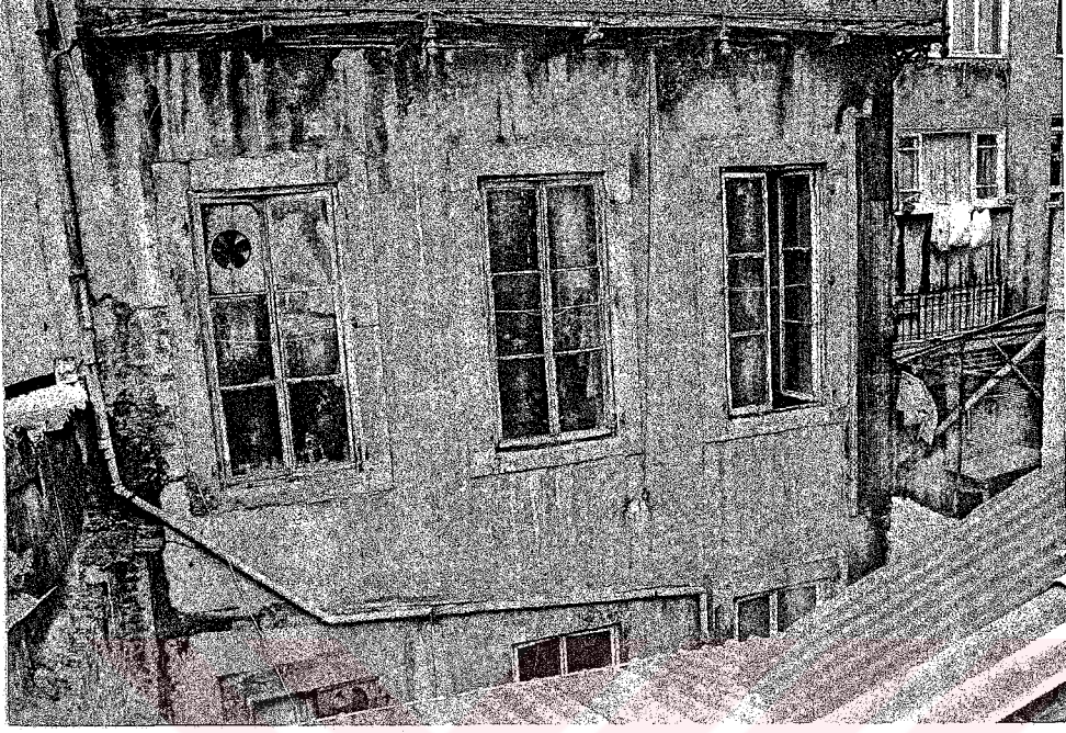
Resim 4.138 İkinci katta avluya bakan pencereler.
