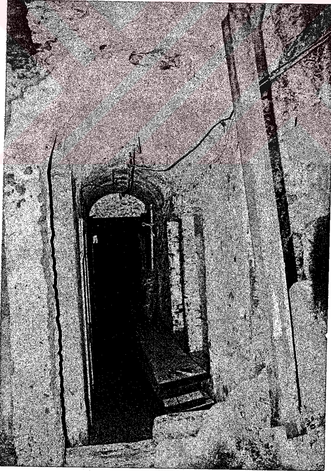
Resim 4.25 Z08'den avluya çıkış koridoru olan Z09 mekanının beşik tonoz örtüsü.
