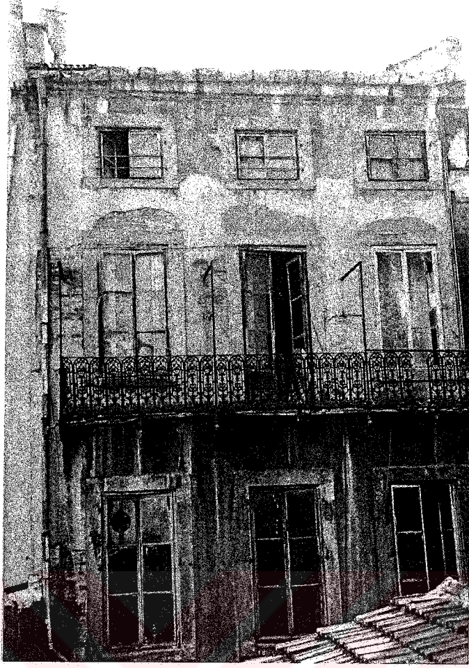
Resim 4.129 Arka cepheden genel görünüm.
