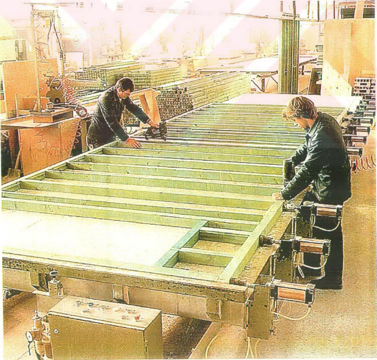
Şekil 4.11 Duvar çerçevesi oluşturulma aşaması
