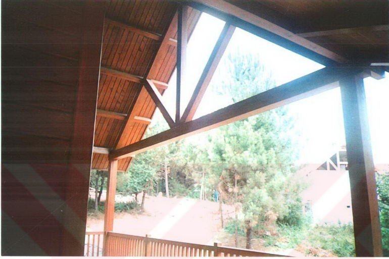
Şekil 4.9 Çatı oluşumunda kullanılan makaslar
