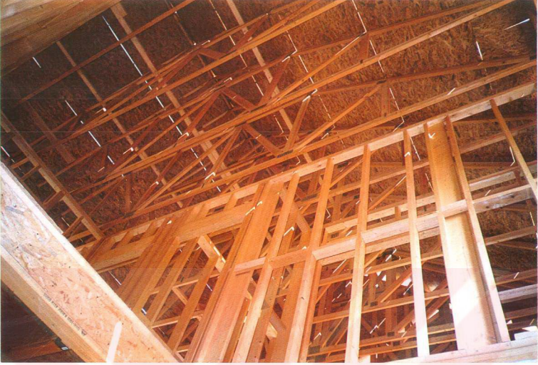
Şekil 4.6 Yapıda kullanılan çatı makasları ve kuşak bağlantıları
