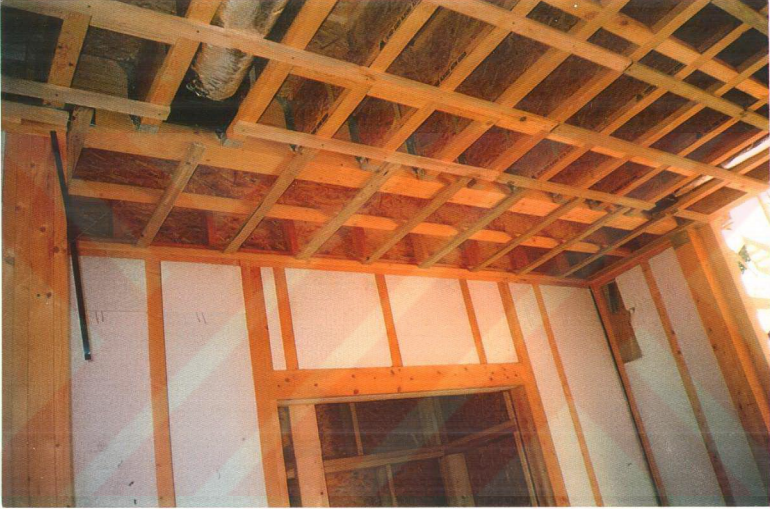
Şekil 4.27 Taşıyıcı I kirişler ve duvar çerçeveleri
