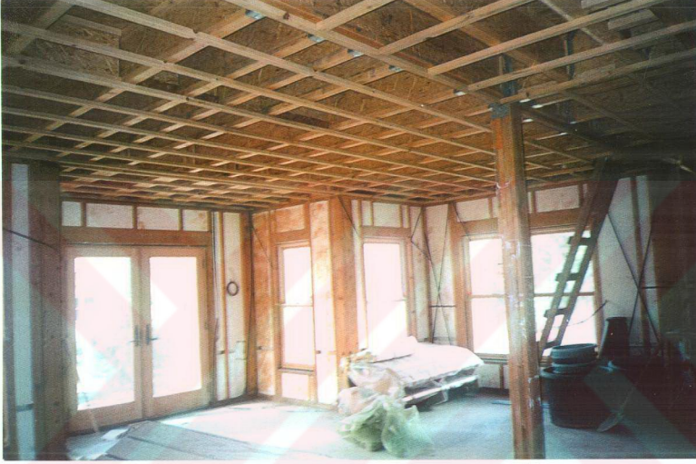
Şekil 4.21 Döşeme I kirişleri ve duvar çerçeveleri
