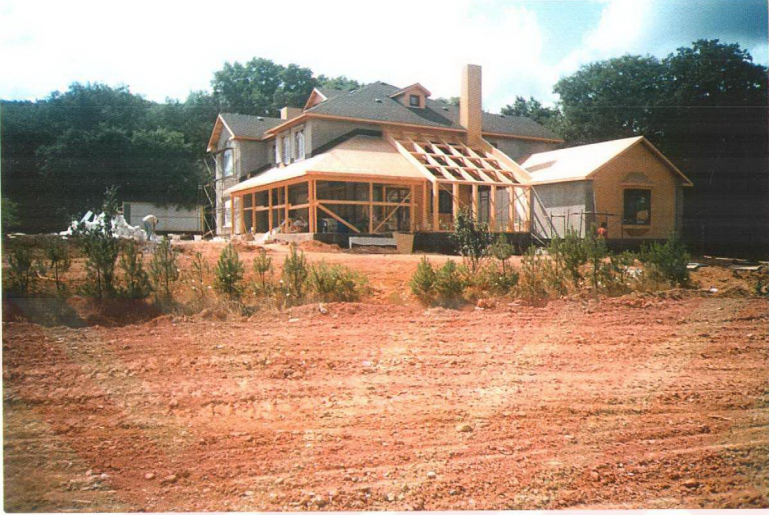
Şekil 4.32 Ahşap konutun yapım aşaması
