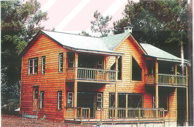
Şekil 3.25 Dikmeli kütük yapım yöntemiyle oluşturulan ahşap konut
