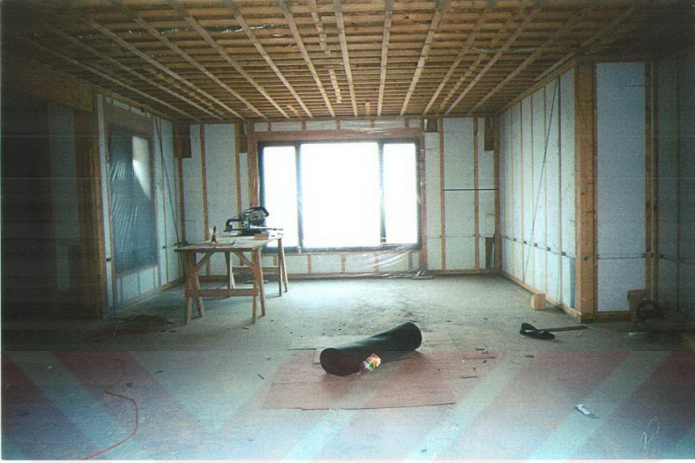
Şekil 4.28 Duvar çerçevelerinin iç bölümünde yalıtım amaçlı kullanılan extrude polistren
