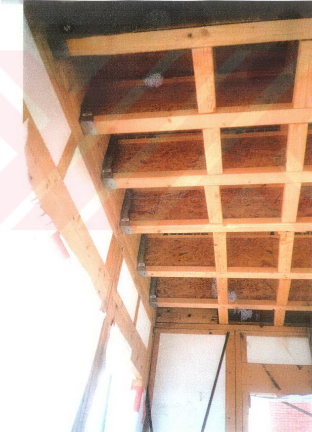
Şekil 4.35 Taşıyıcı I kirişler ve duvar çerçeveleri
