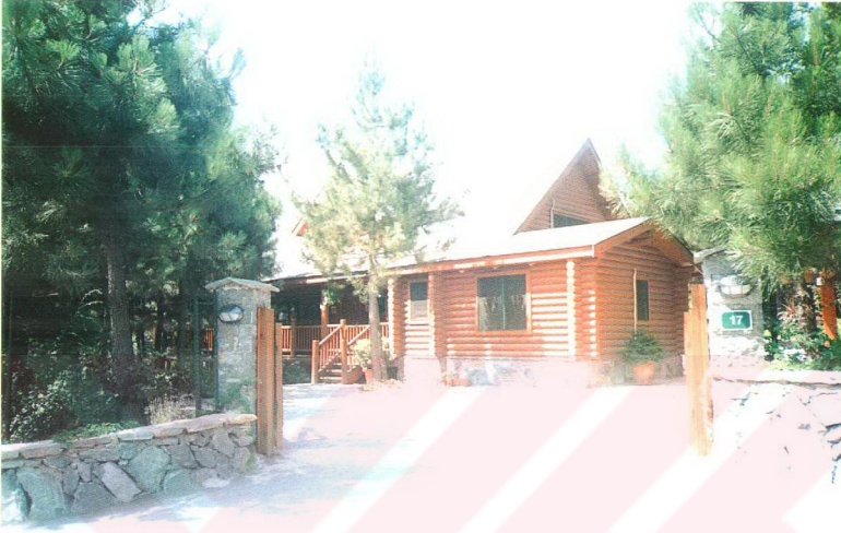
Şekil 4.8 Kütük sistemle oluşturulan konutun genel görünümü
