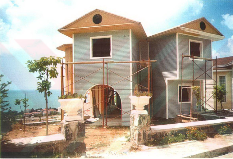
Şekil 4.38 Cephe kaplaması olarak OSB levha ve yalıbaskı uygulaması
