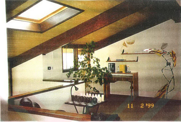
Şekil 4.17 Yapının iç mekanında görülen kirişler
