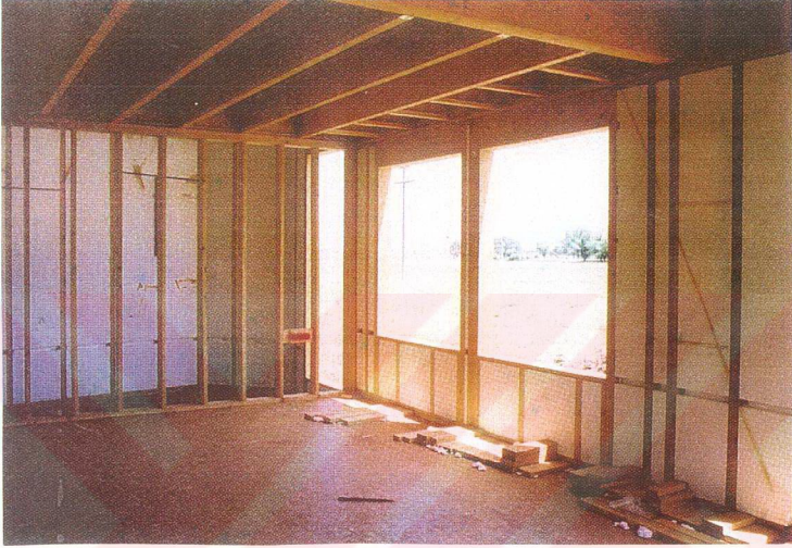
Şekil 3.10 Kaburga çerçeve duvar ve döşeme sistem kurgusu
