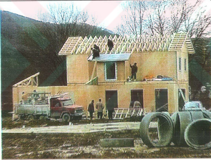
Şekil 4.12 Ahşap çatı makaslarından oluşan çatı sistemi
