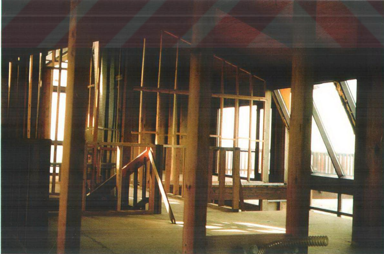
Şekil 4.16 Taşıyıcı dikme ve kirişler
