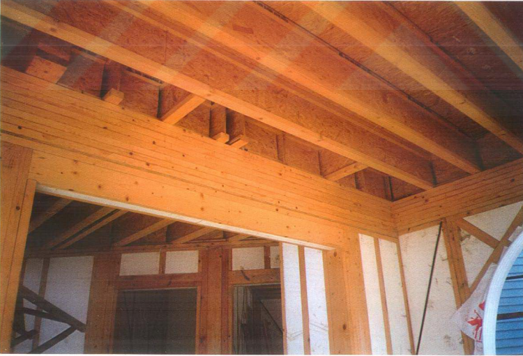
Şekil 4.37 Duvar çerçevelerinin iç bölümünde yalıtım amaçlı kullanılan extrude polistren uygulaması
