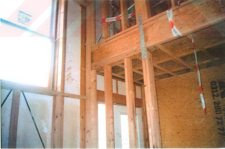
Şekil 4.23 Duvar ve döşeme birleşim detayları
