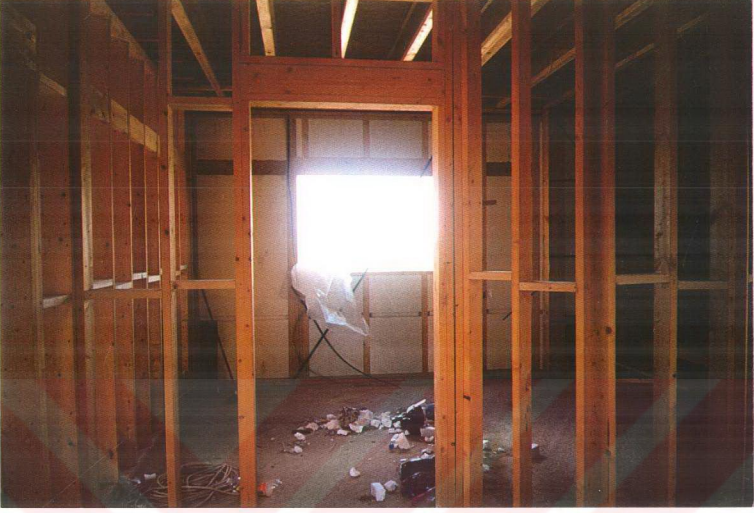
Şekil 4.3 Duvarlarda kullanılan yatay kuşaklar
