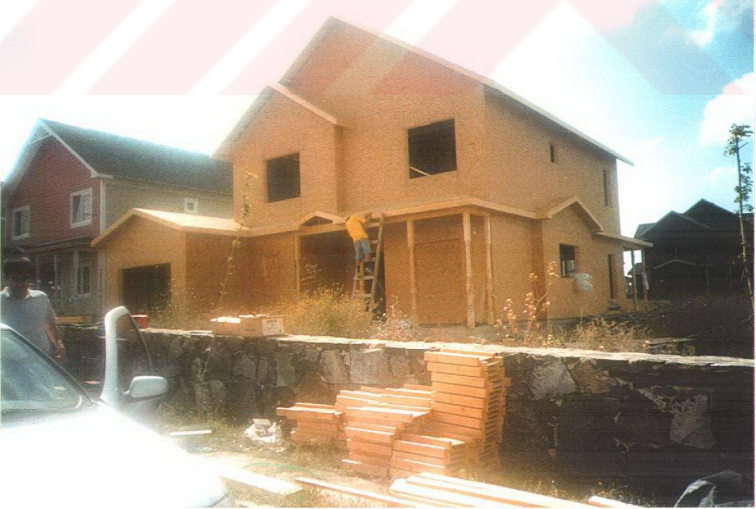
Şekil 4.4 Yapının dış duvar çerçeveleri üzeri OSB kaplaması
