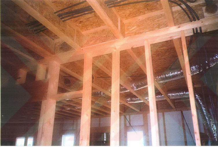
Şekil 4.5 Klima ve mekanik tesisatın I kirişlerin arasından geçirilerek uygulanması
