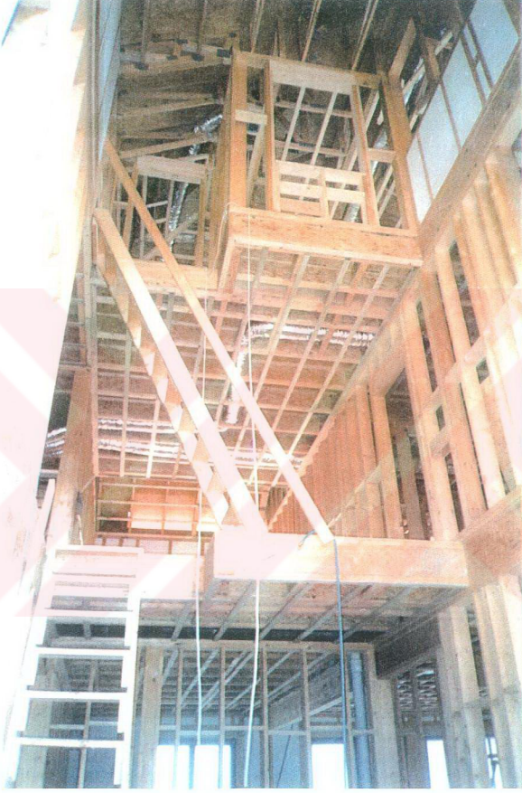
Şekil 4.31 Ahşap taşıyıcı sistem oluşumu ve klima tesisatının uygulanması
