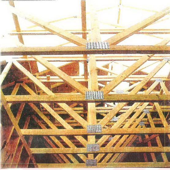
Şekil 4.25 Çatıda rijitliği sağlama amacıyla yapılan zımbalama ve makaslama
