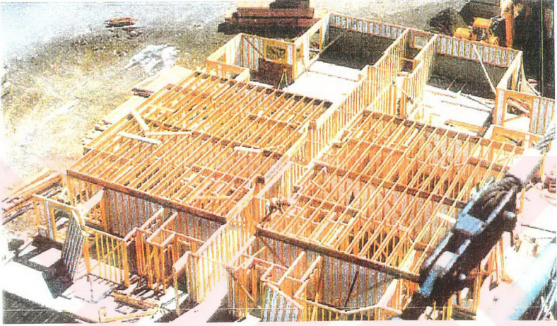
Şekil 4.24 Döşeme sisteminin kuruluşu
