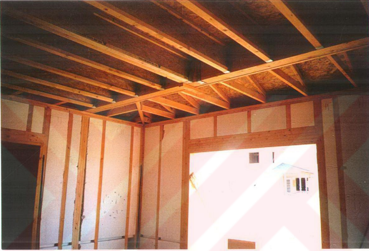
Şekil 4.2 Taşıyıcı I kirişler ve duvar çerçeveleri
