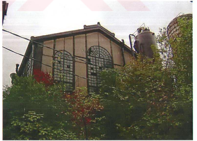
Şekil 6.4 Silahtarağa Elektrik Santrali-2002
