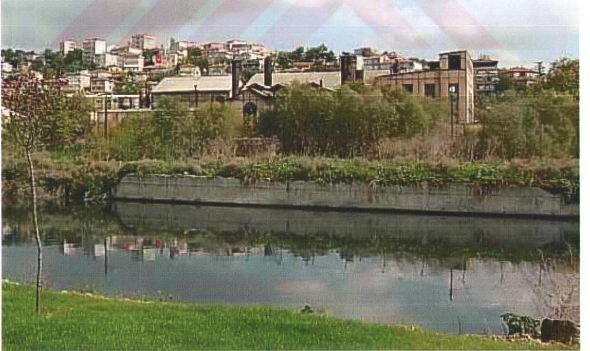
Şekil 6.3 Silahtarağa Elektrik Santrali-2002
