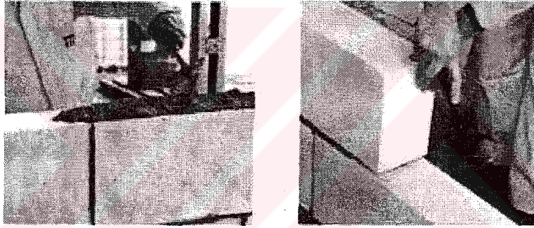
Şekil 3.14 Gazbeton harçlı blok uygulaması (Ytong,2001)
