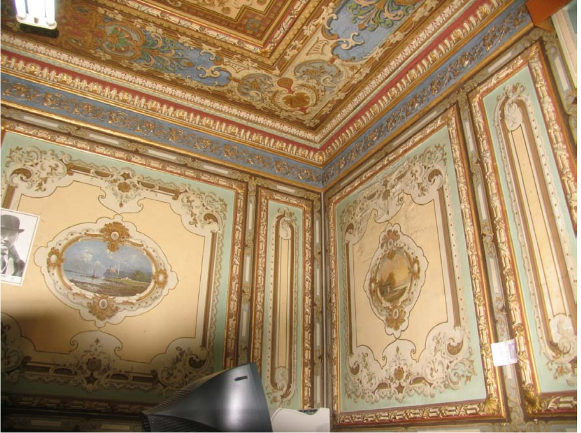
Resim 4.27 102 Oda mekanı duvar ve tavan süslemeleri
