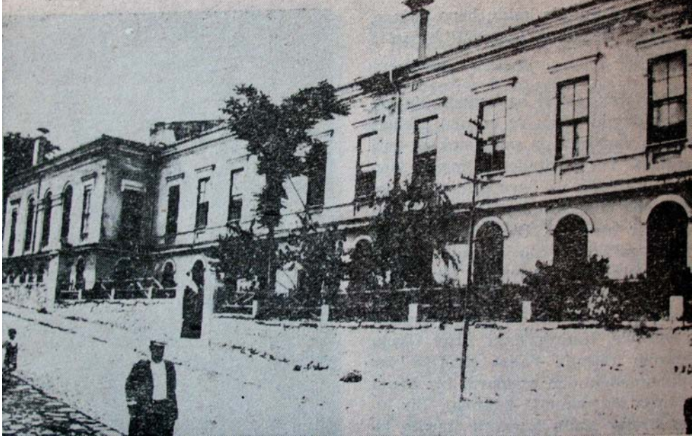
Resim 3.2 Nafia Fen Mektebi Gümüşsuyu Kışlasında (Ilgım, 1973)
