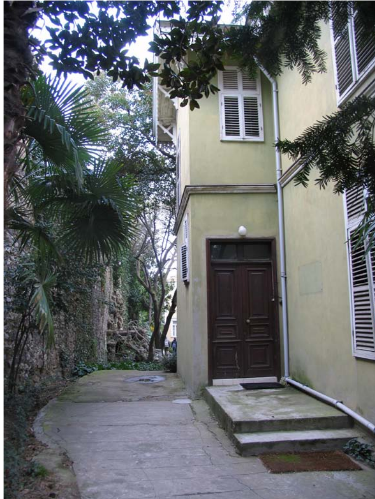
4.68 Kuzey cephesi giriş kapısı ve doğu cephesi
