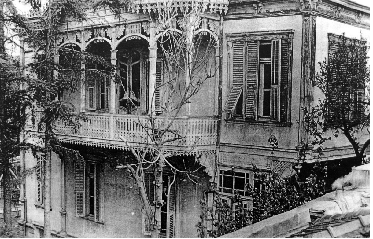
Resim 4.92 4 numaralı köşk (Y.T.Ü. Yapı İşeri arşivi)
