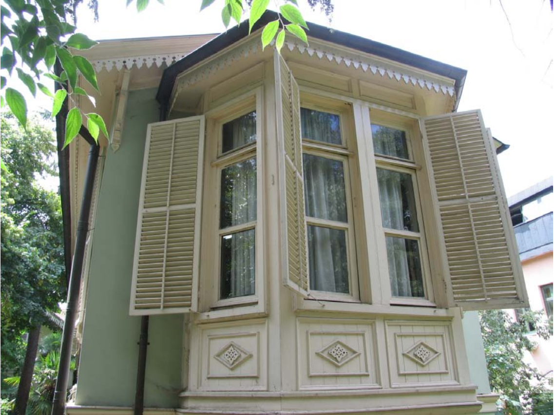
Resim 4.33 Kuzey cephesindeki ahşap çıkma bölüm
