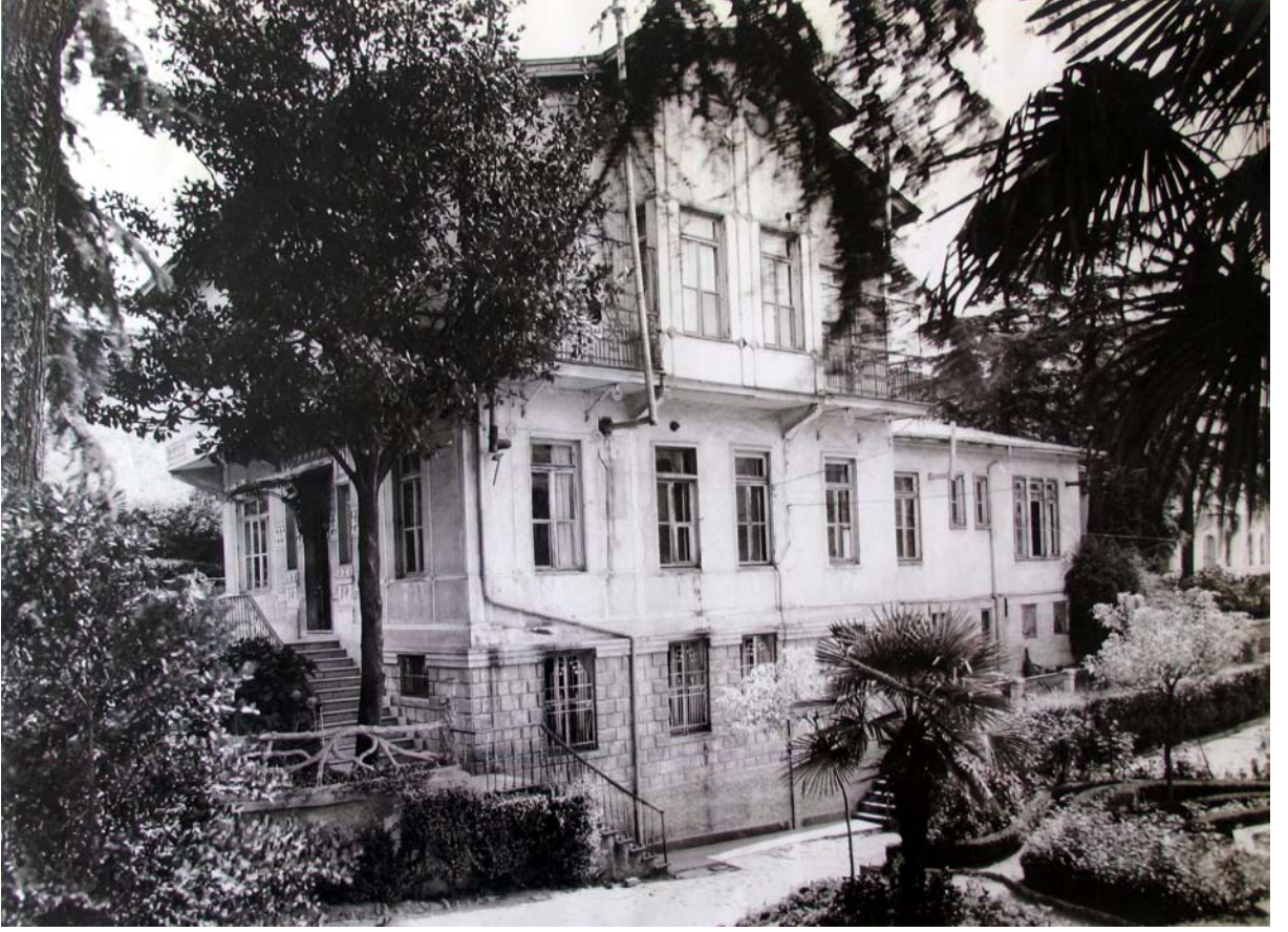
Resim 5.13 Köşkün batı ve kuzey cephelerini gösteren fotoğraf (Y.T.Ü. Yapı İşleri Arşivi)
