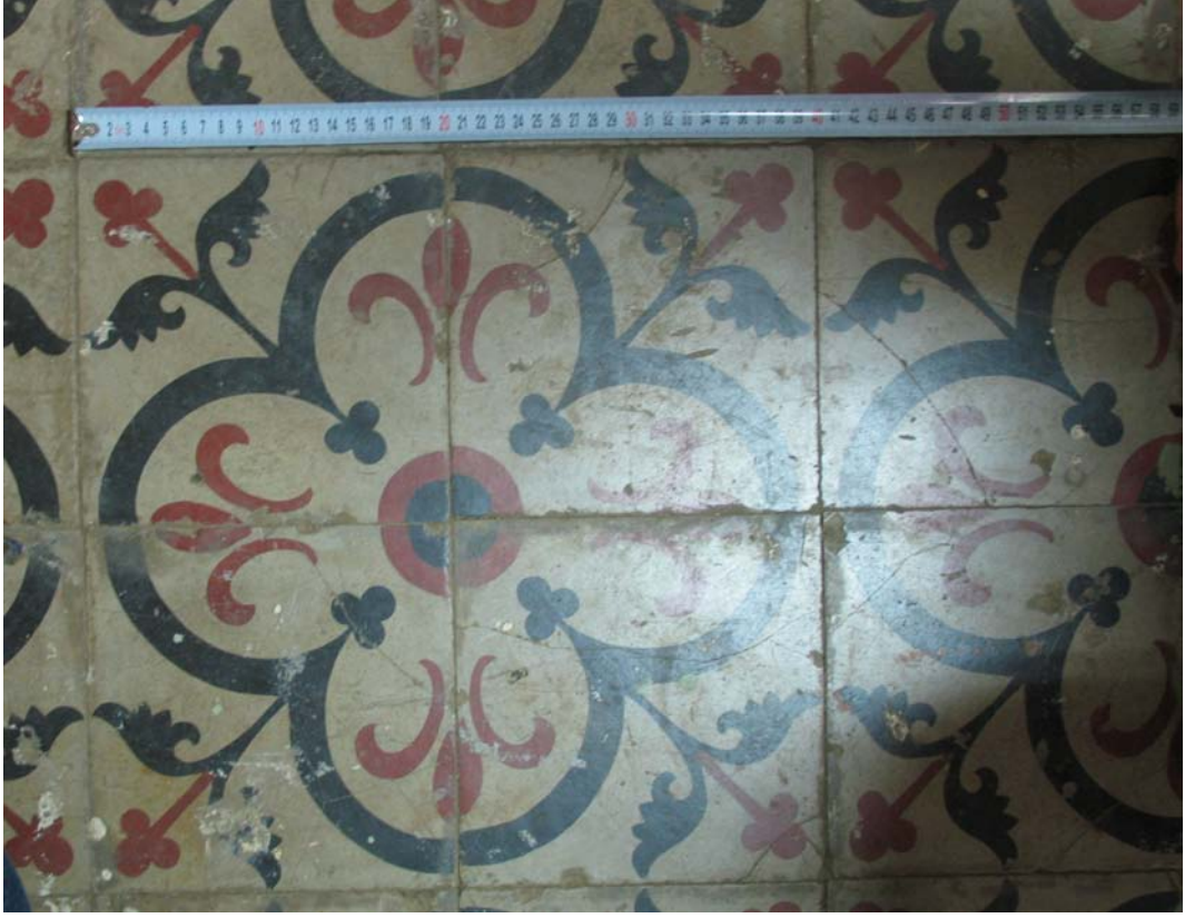
Resim 4.74 Bodrum kat zemin döşemesi
