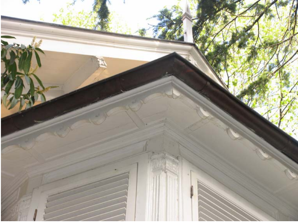
Resim 4.88 Batı cephesindeki ahşap çıkma bölüm
