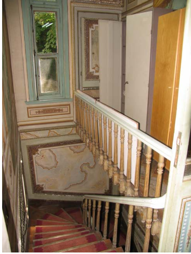
Resim 4.28 Birinci kat merdiven sahanlığı ve kullanılmayan balkon kapısı
