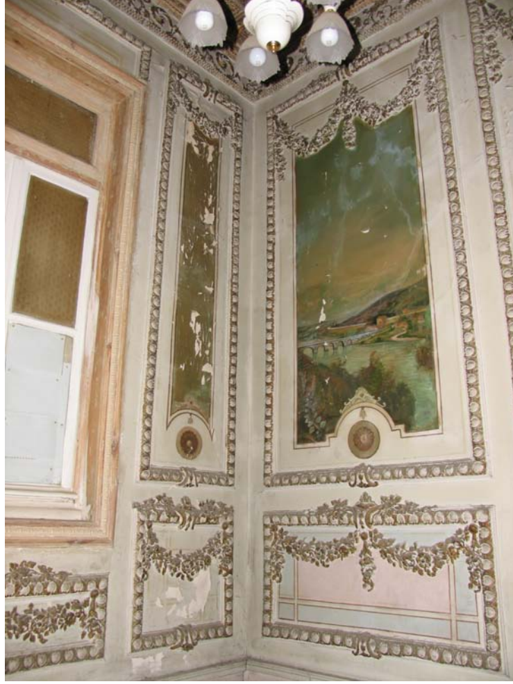
Resim 4.112 Merdiveni çevreleyen duvarlar
