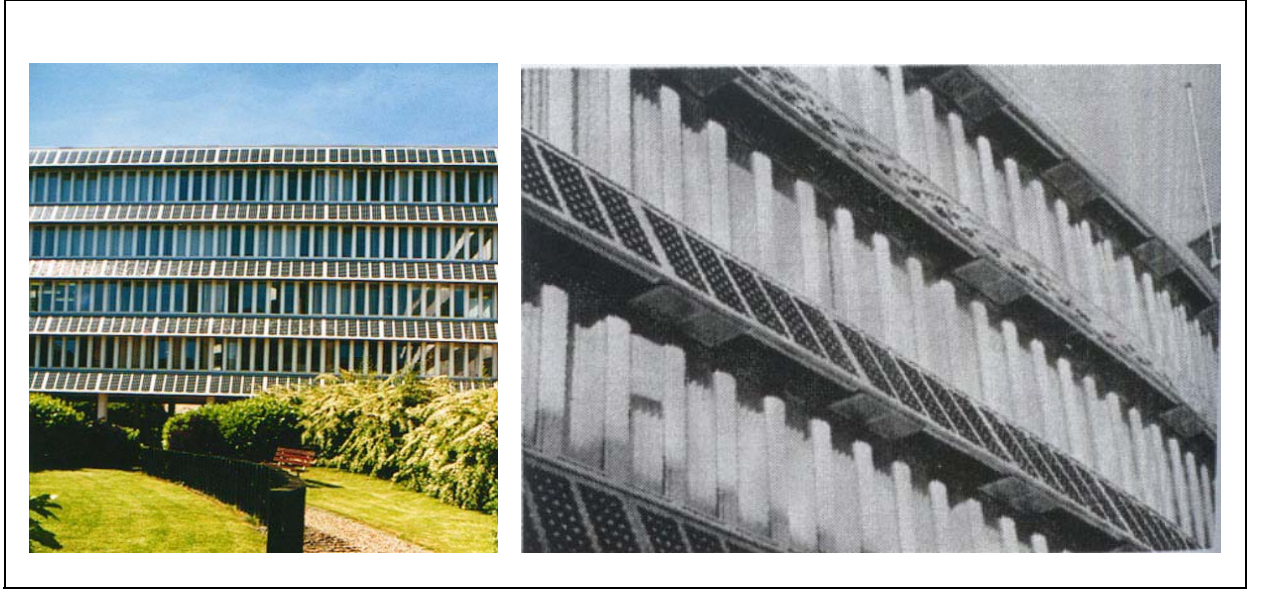
Şekil 4. 33 Binanın genel görünüşü [17]
