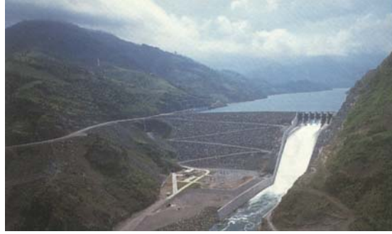
Şekil 2. 14 Hasan Uğurlu Barajı (Çeçen, 1994).
