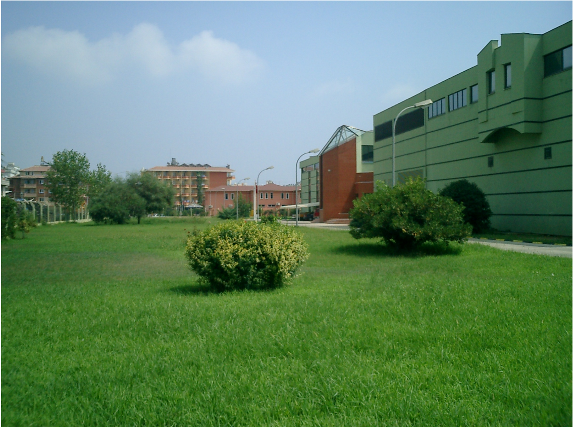
Şekil 5.23. Alanya’daki atık su arıtma tesisi.
