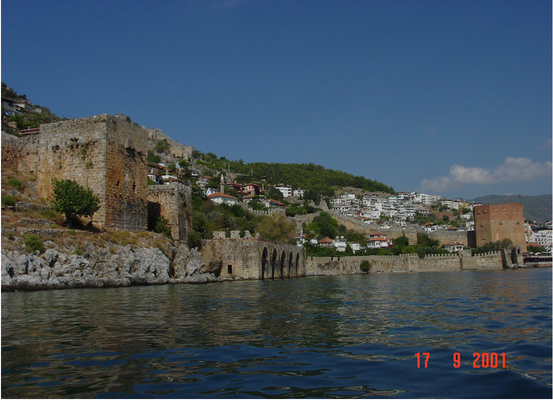
Şekil 5.5. Sağdan sırayla; kızıl kule, tersane ve tophane binası.
