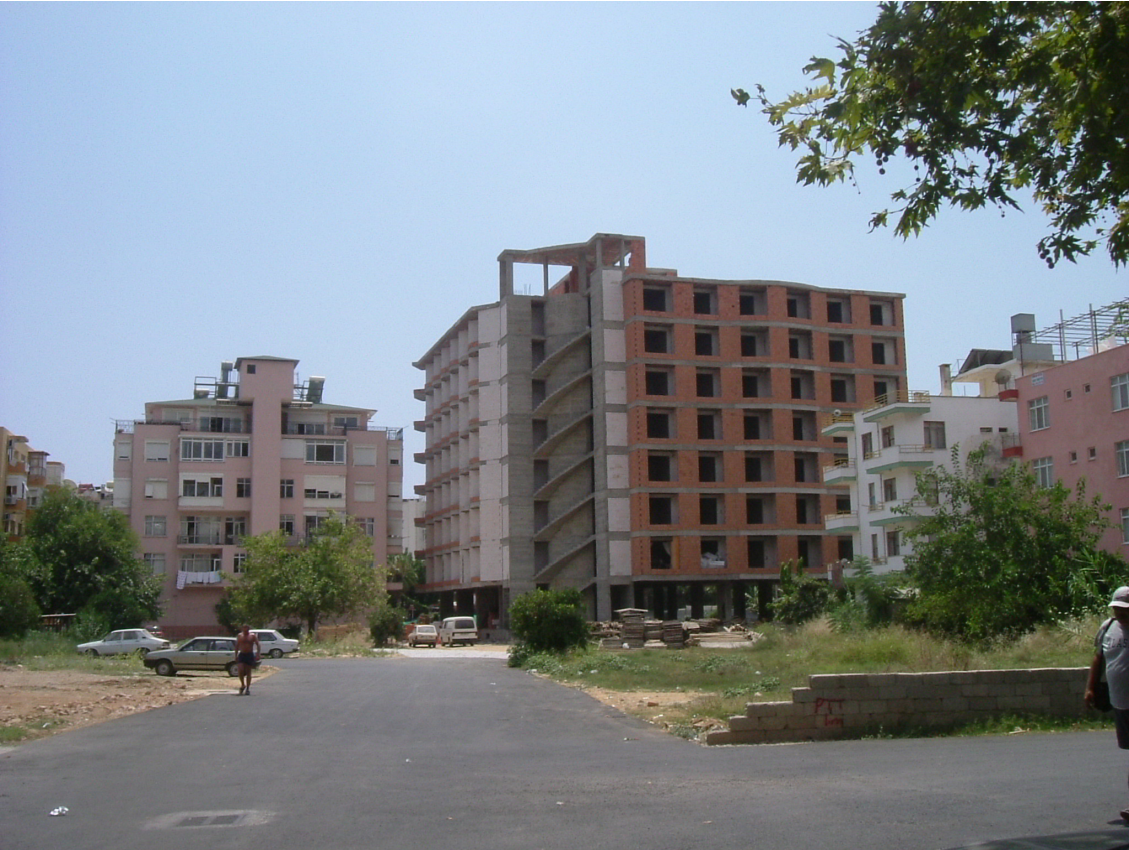
Şekil 5.22. Şehir merkezinde devam eden bir otel inşaatı.
