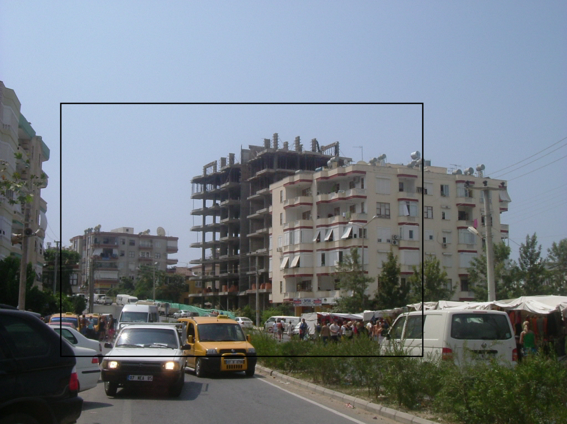
Şekil 5.20. Stad Caddesi üzerindeki yapılaşma.
