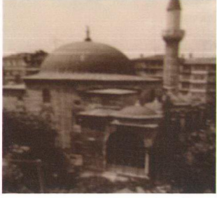
Şekil 4.43 Bali Paşa Camisi (Kuran, 1986b)
