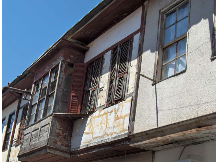
Şekil 5.29 Antalya Kaleiçi Evleri'nin güney ve batı cephelerinde kullanılan ahşap kepenkler
