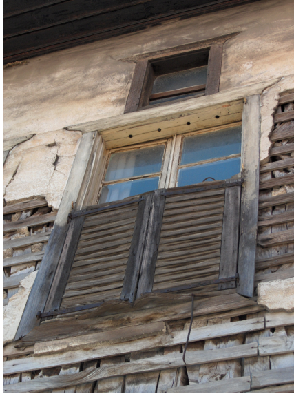
Şekil 5.26 İç mekanda doğal havalandırma ve aydınlatma sağlamak için açılan tepe pencereleri
