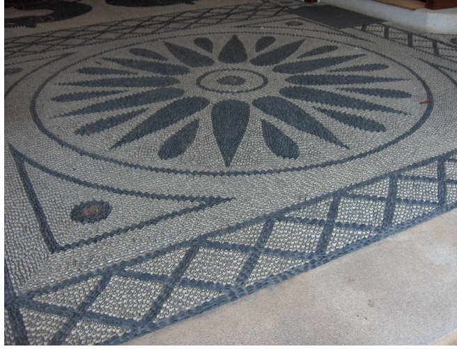
Şekil 5.24 Kaleiçi Evleri'nin taşlıklarında bulunan çakıl yer döşemeleri
