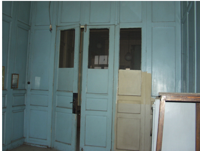
Şekil 6.58 103 Müdür odasını holden ayıran ahşap bölme.
