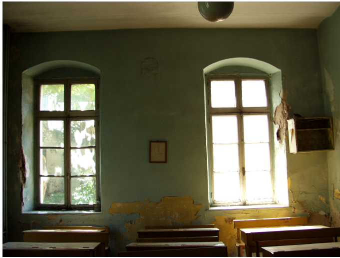
Şekil 6.20 Z01 Sınıf mekanı ahşap pencereler.
