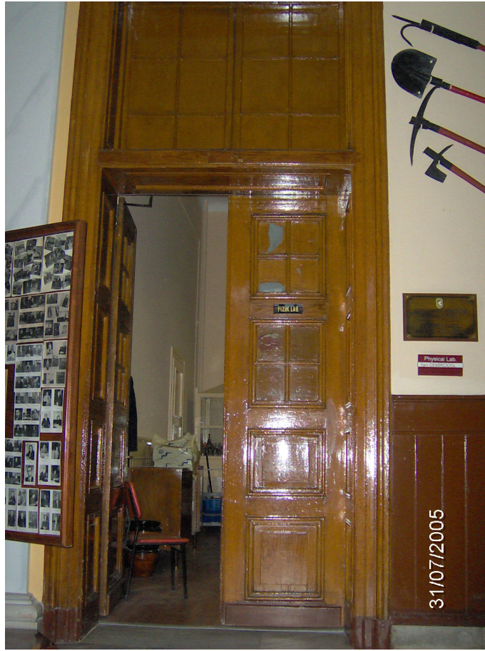
Şekil Ek 5. 4 Özgün ahşap derslik kapısı.
