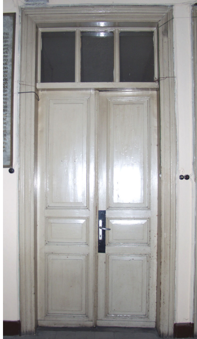
Şekil 6.18 Z01 Sınıf mekanı ahşap giriş kapısı.
