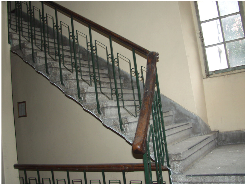
Şekil 6.45 Merdivenin ahşap küpeşte ve demir korkulukları.
