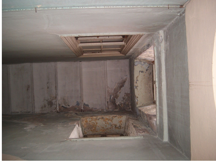
Şekil 6.75 Merdiven holü, sıvalı volta döşeme.
