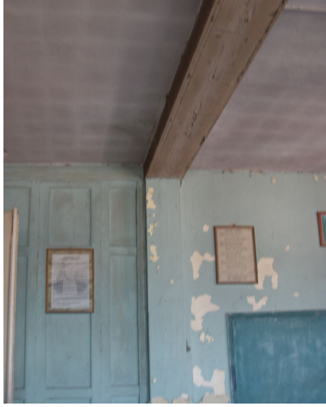
Şekil 6.61 Mekanın büyümesi sırasında kaldırılan duvar hizasına eklenen kiriş.
