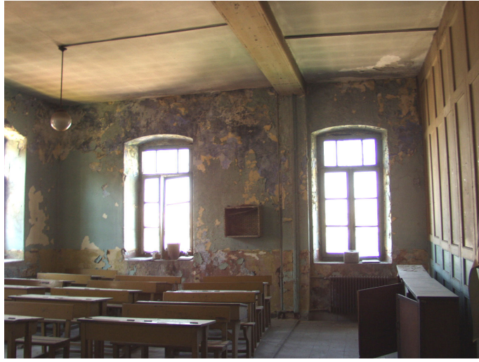
Şekil 6.66 104 sınıf mekanının üzeri sıvalı volta döşeme tavanı.
