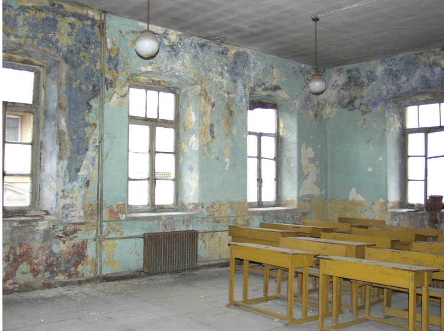
Şekil 6.65 Mekanın Kuzeybatı Cephesi'ne bakan ahşap pencereleri.
