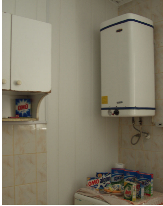
Şekil 6.2 Önü pvc ile kapatılmış B02 depo mekanı.
