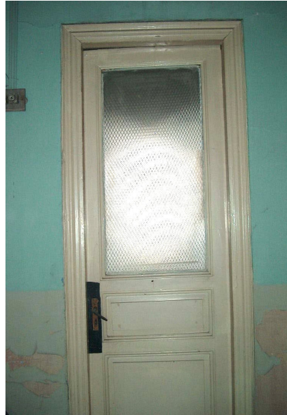
Şekil 6.71 106 sınıf mekanının tek kanatlı ahşap giriş kapısı.
