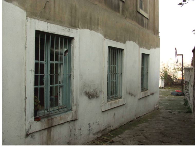
Şekil 6.101 Bodrum kat demir parmaklıklı ahşap pencereler.
