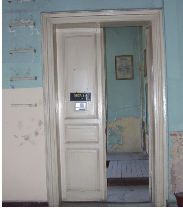
Şekil 6.67 105 sınıf mekanı ahşap giriş kapısı ve çatıya çıkan demir merdivenler.
