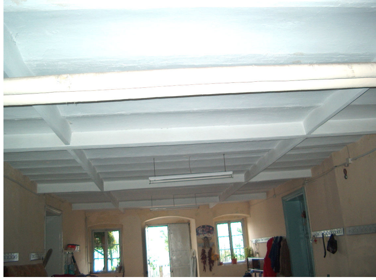
Şekil 6.11 B14 Hol Mekanı, çelik kirişli volta döşeme.
