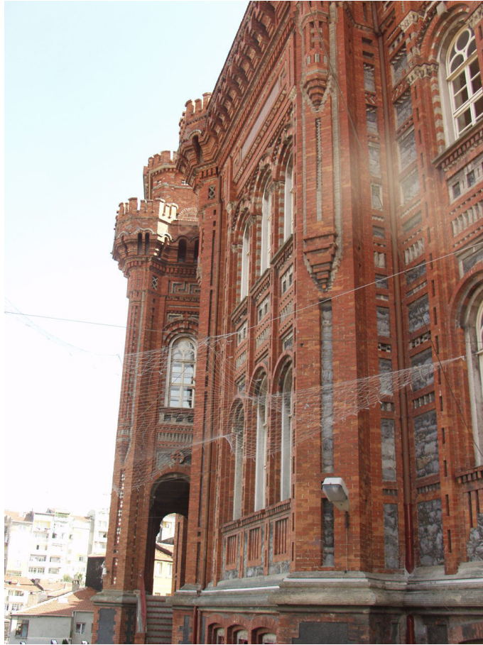
Şekil Ek 3. 6 Giriş Cephesi.
