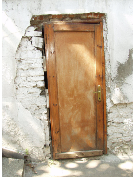
Şekil 6.96 Bodrum kat muhdes wc mekanının ahşap kapısı
