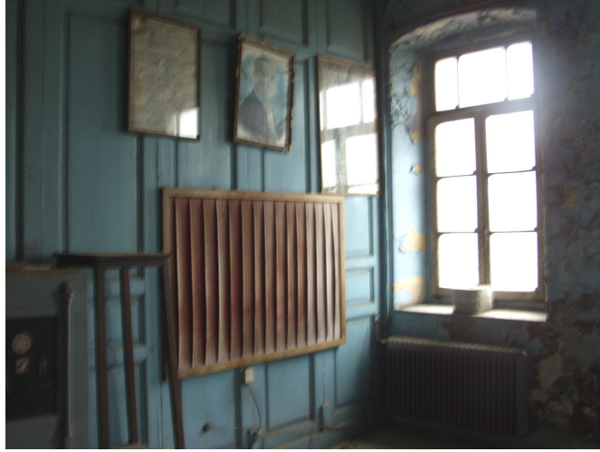
Şekil 6.59 103 müdür odası mekanı ahşap pencere ve ahşap bölme.
