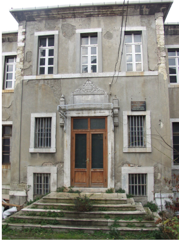
Şekil 6.79 Güneybatı (Giriş) Cephesi.
