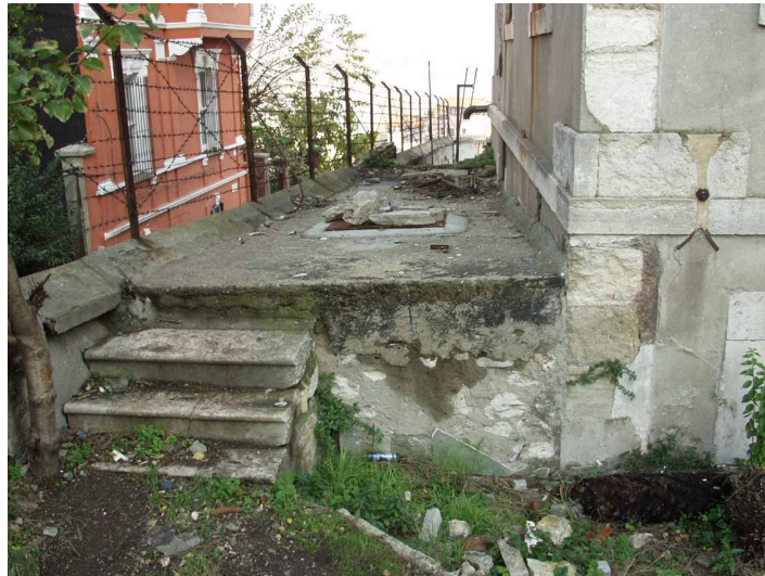
Şekil 6.110 Kuzeybatı Cephesi, muhdes set.
