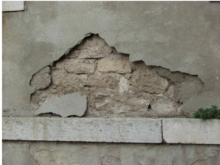
Şekil 6.90 Raspa sonucu ortaya çıkan örgü düzeni.
