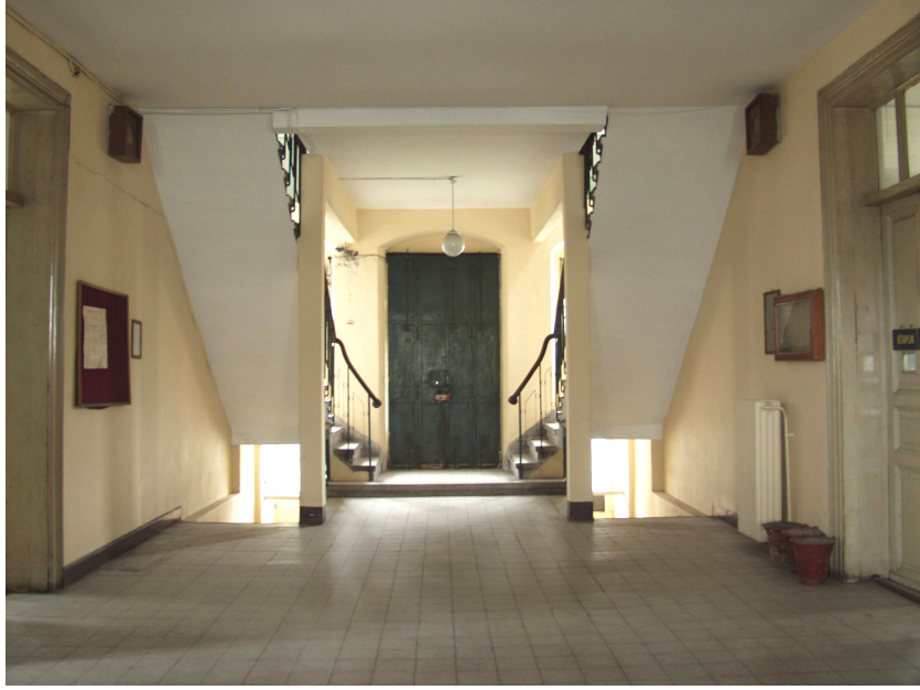
Şekil 6.44 Katlara ulaşımı sağlayan üç kollu mozaik merdiven.
