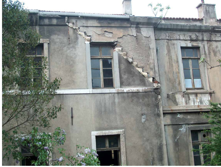
Şekil 6.99 Güneydoğu Cephesinde yer alan muhdes merdiven izi.
