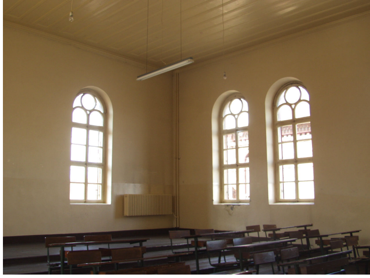
Şekil 4.20 Özgün ahşap pencereler
