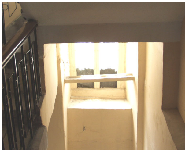
Şekil 6.16 Bodrum Kat Merdiven Holü Sağ Pencere
