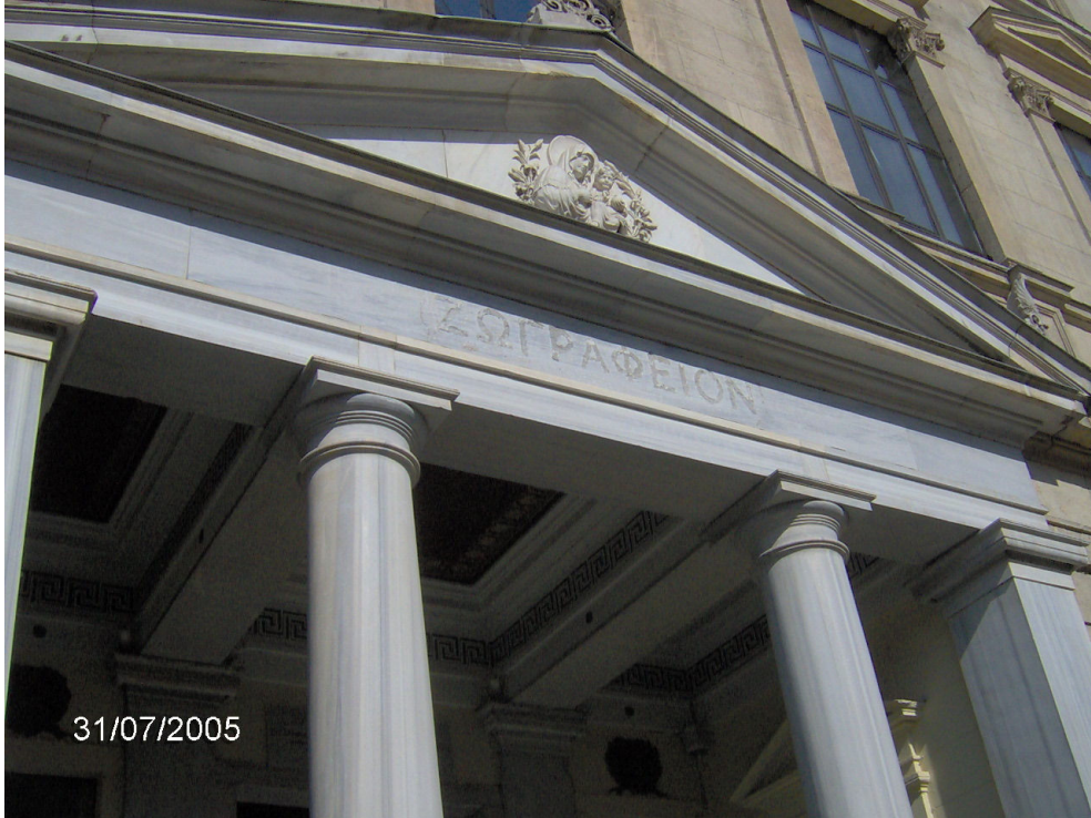
Şekil 4.46 Giriş Cephesi, üçgen alınlık.
