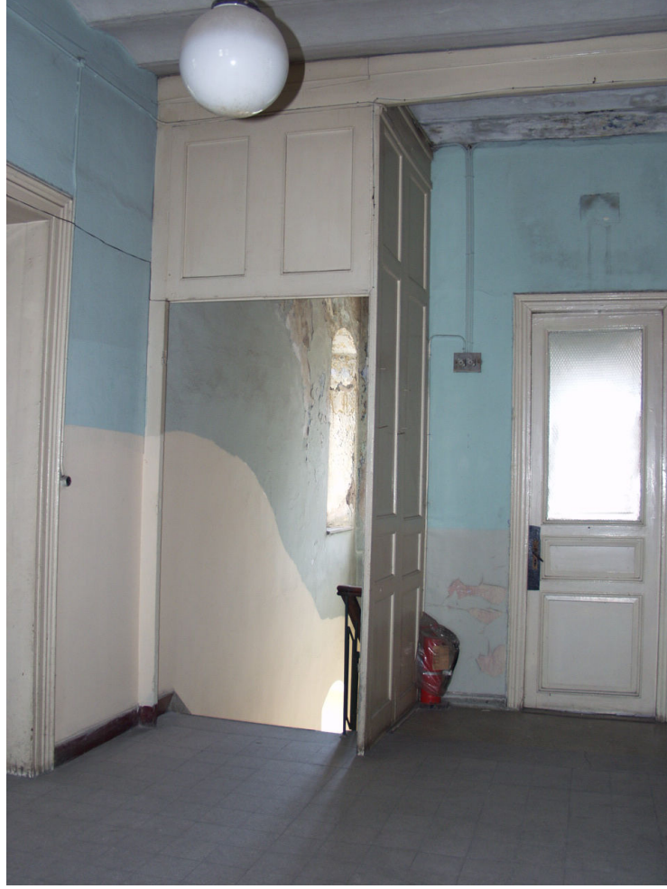
Şekil 6.73 Merdiven holünü sınırlayan ahşap bölme ve hol mekanı.
