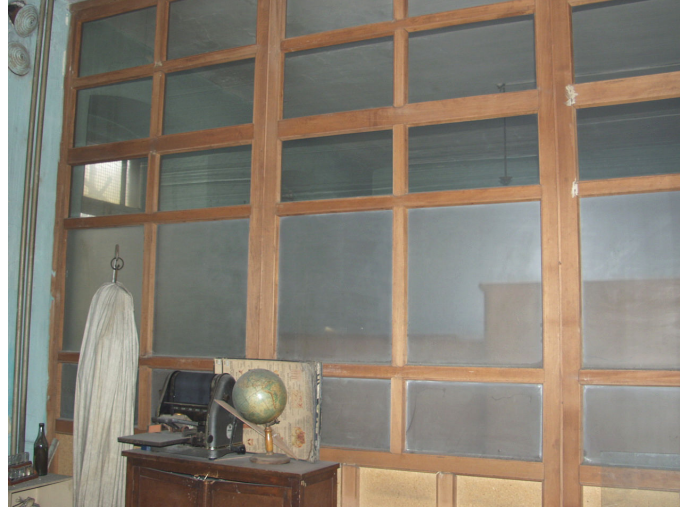
Şekil 6.35 Z06 Mekanını öğretmenler odasında ayıran muhdes ahşap bölücü eleman.
