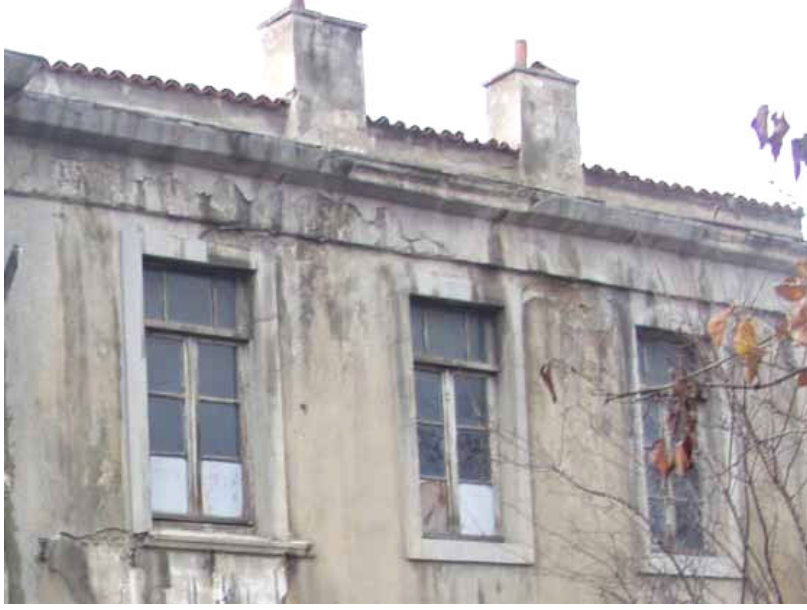
Şekil 6.104 Saçak altı taş silme ve parapetli bitiş.
