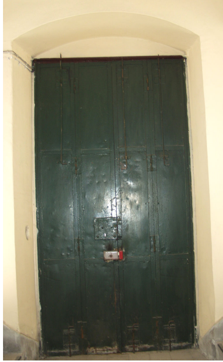
Şekil 6.46 Binanın metal ana giriş kapısı.
