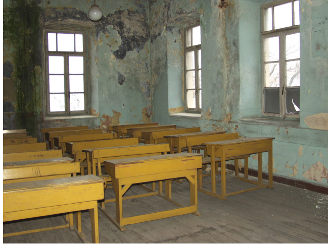
Şekil 6.55 102 sınıf mekanı ahşap döşeme kaplaması.
