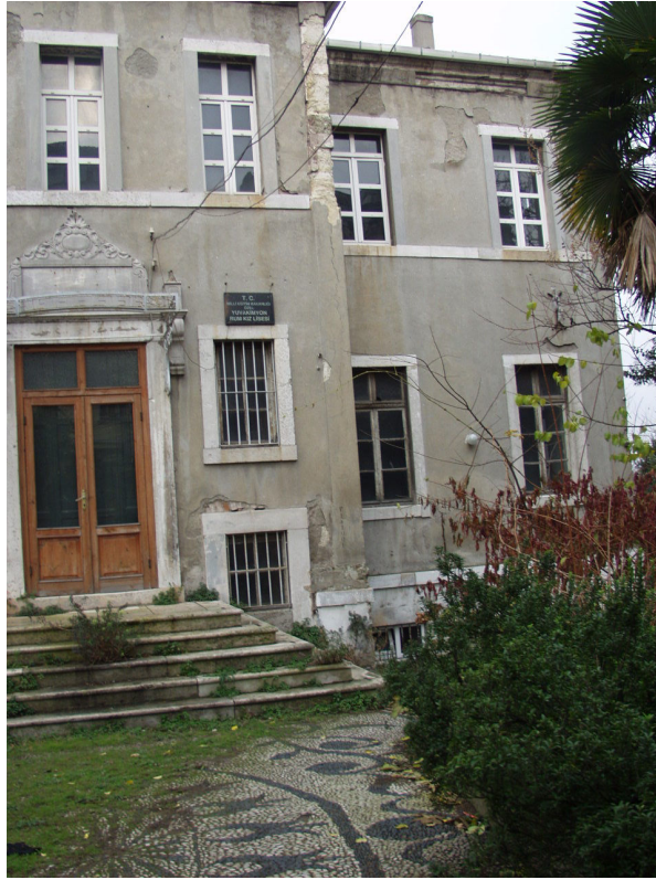
Şekil 6.80 Güneybatı (Giriş) Cephesi.
