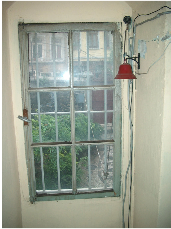
Şekil 6.48 Merdiven holünde yer alan ahşap açılır kanat pencereler.
