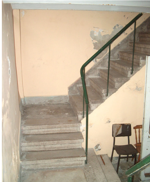
Şekil 6.14 Bodrum kat mozaik merdiven
