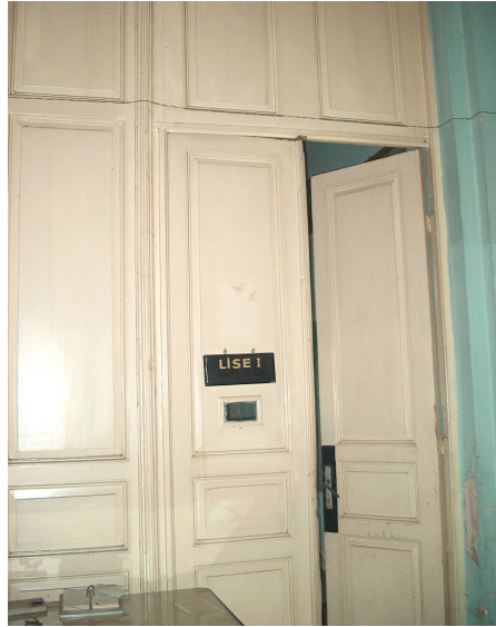
Şekil 6.54 102 sınıf mekanına girişi sağlatan ahşap bölme ve kapı.
