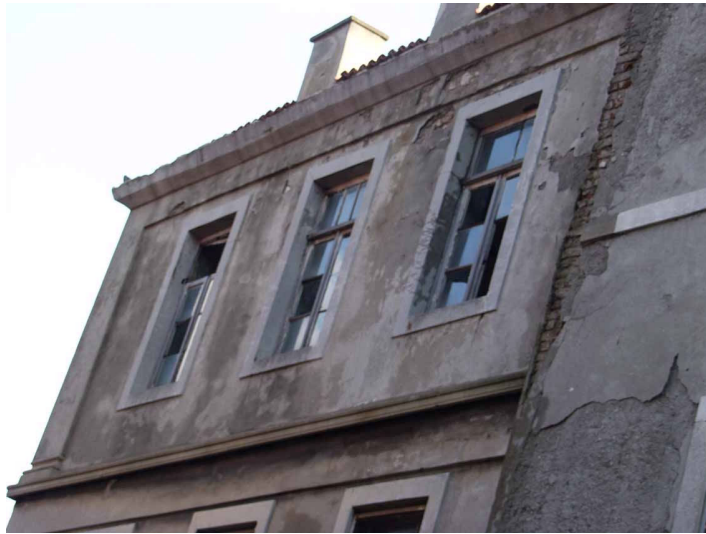
Şekil 6.112 Sonradan eklenen baca için yapılan tuğla örgü.
