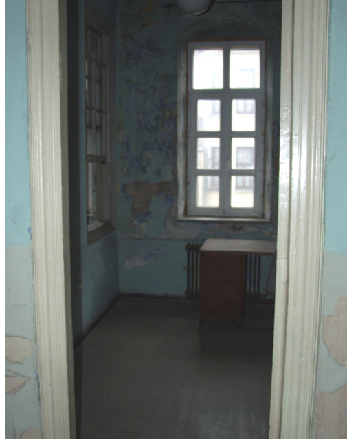
Şekil 6.72 106 Revir mekanı linolium döşeme kaplaması ve pvc pencere.
