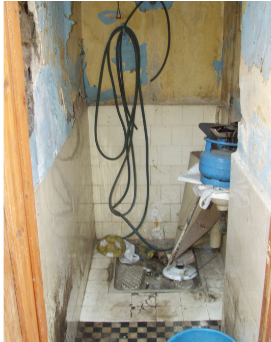
Şekil 6.3 B03 Wc mekanı.
