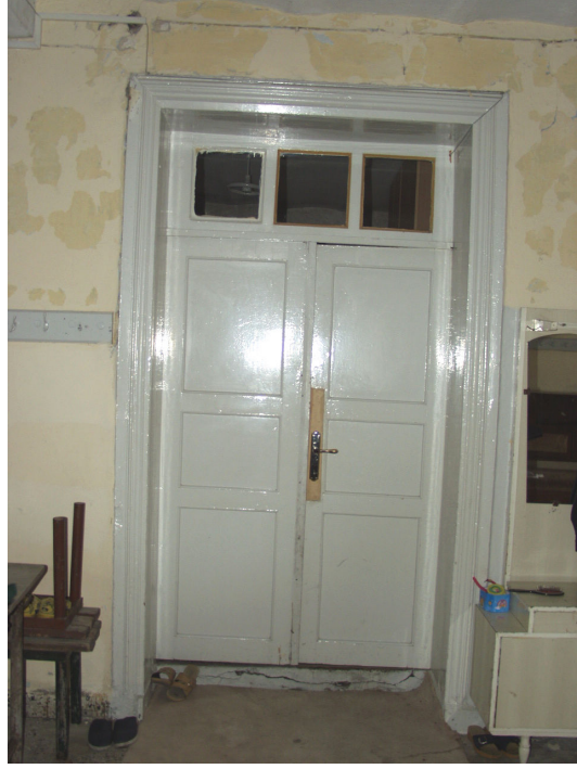
Şekil 6.7 B09 Mekanı ahşap giriş kapısı.
