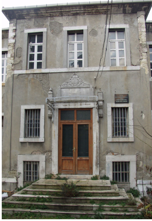
Şekil 4.26 Güneybatı (giriş) Cephesi, taş ve sıvalı yüzeyler.
