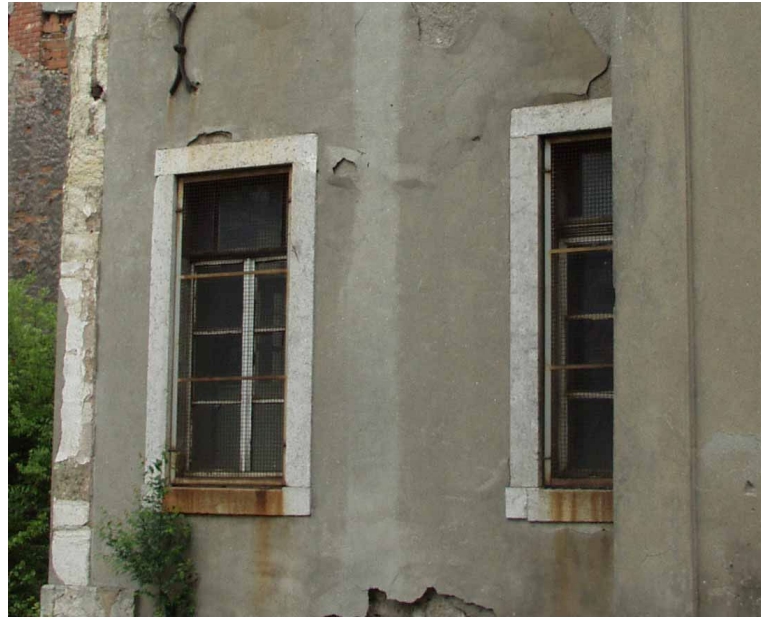
Şekil 6.86 Zemin kat metal kafesli pencereler.
