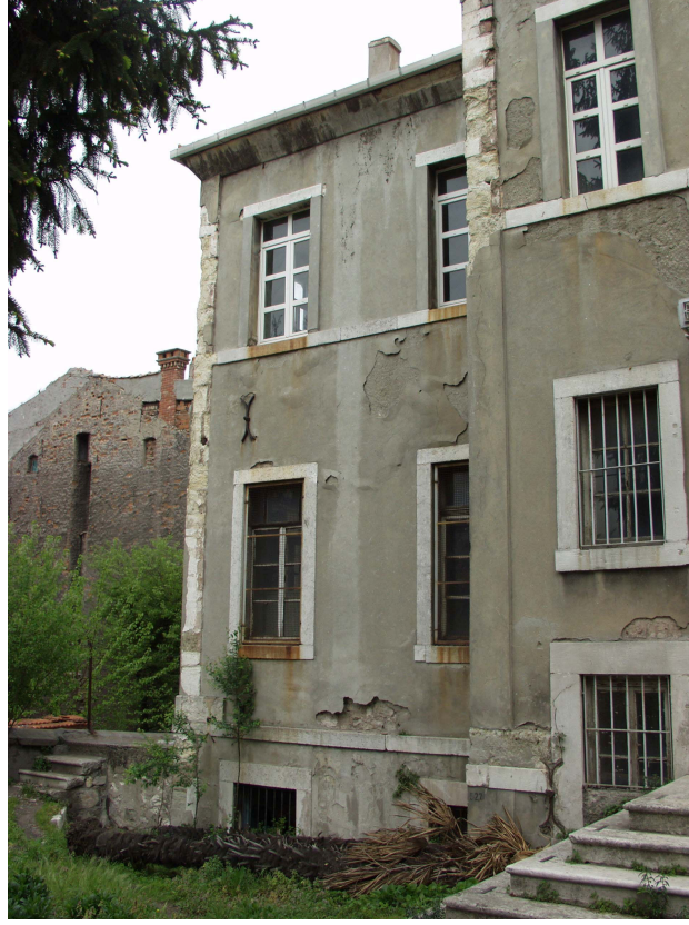
Şekil 6.81 Güneybatı (giriş) Cephesi.
