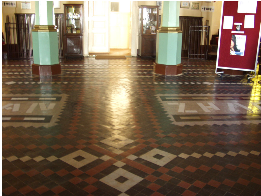
Şekil Ek 3. 2 Giriş holü özgün döşeme kaplaması.
