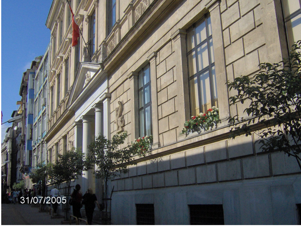
Şekil 4.45 Zoğrafyon Rum Erkek Lisesi, Batı (giriş) Cephesi genel görünüş.
