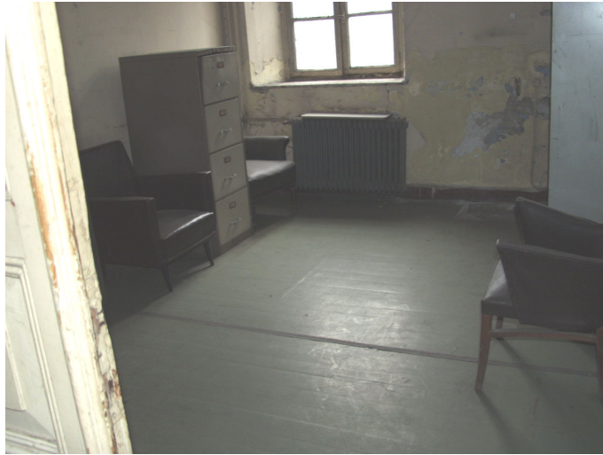
Şekil 6.24 Z02 Mekanının ahşap üzeri linolyum kaplaması.
