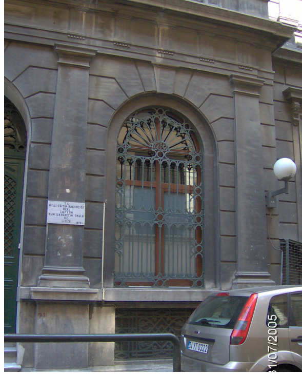
Şekil 4.36 Taş izlenimi veren sıvalı yüzey, plastrlar.
