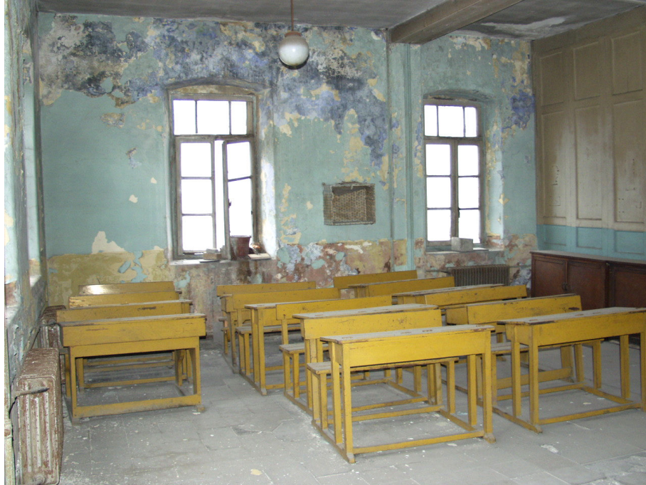
Şekil 6.64 Mekanın Kuzeydoğu Cephesi'ne bakan ahşap pencereleri.
