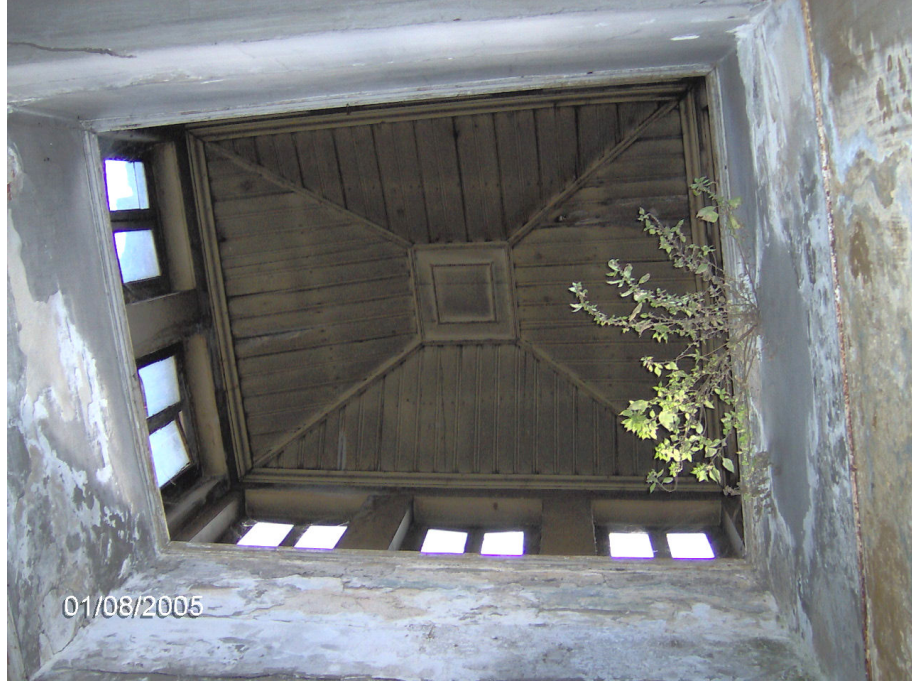
Şekil Ek 2. 3 Kule tavan kaplaması.
