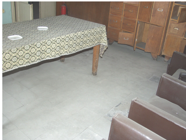
Şekil 6.32 Z05 Mekanı pvc karo döşeme kaplaması.
