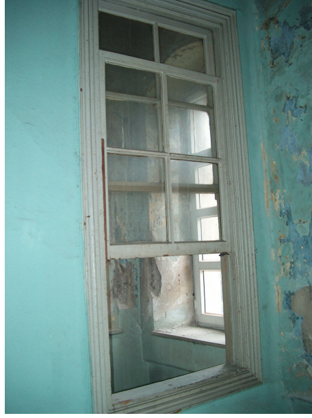
Şekil 6.70 106 revir mekanının muhdes ahşap giyotin penceresi.
