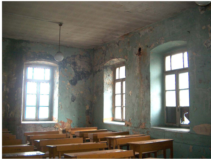
Şekil 6.56 102 Mekanı ahşap pencereleri ve koltuk silmesi.
