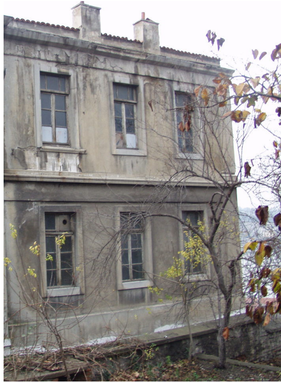
Şekil 6.102 Güneydoğu Cephesi taş kat silmesi ve çerçeve görüntüsü.
