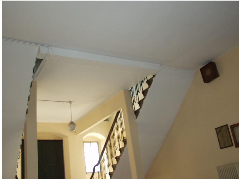
Şekil 6.43 Merdiven holünde yer alan kolon ve kiriş takviyesi.
