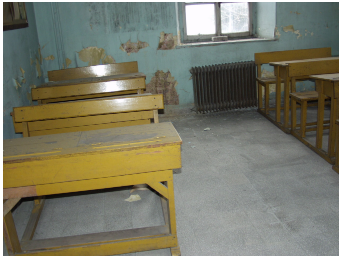
Şekil 6.26 Z03 Mekanı döşeme ve duvar kaplaması.
