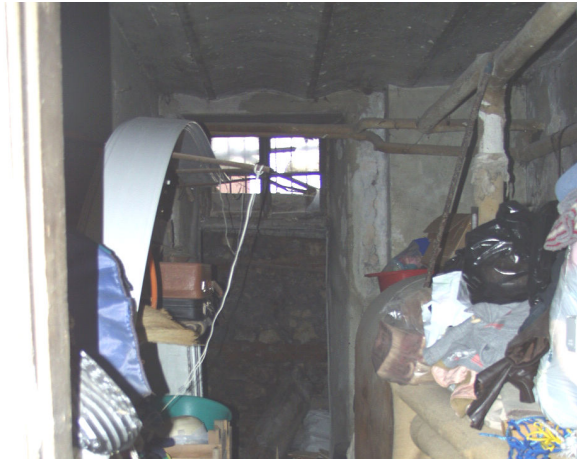
Şekil 6.8 B10 Kalorifer dairesinin tavanı ve penceresi.
