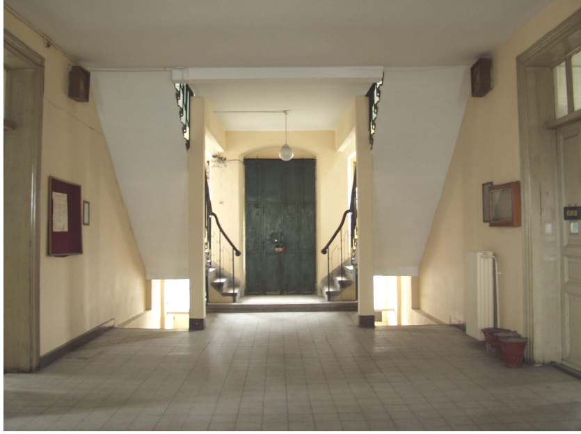
Şekil 6.42 Merdiven holü, sonradan binaya eklenen kolonlar ve kiriş.
