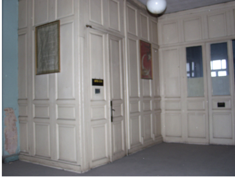
Şekil 6.62 104 sınıf mekanını holden ayıran muhdes ahşap bölme.
