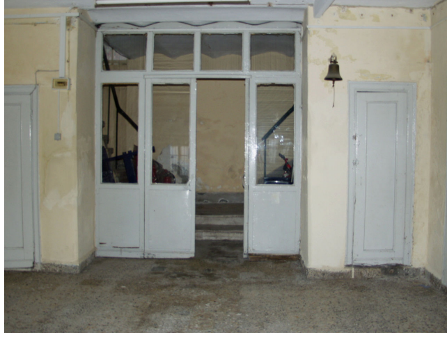
Şekil 6.13 Merdiven Holüne bağlantıyı sağlayan muhdes ahşap bölme.
