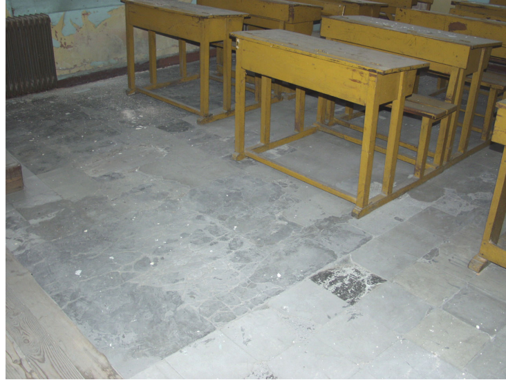
Şekil 6.52 101 mekanı pvc karo döşeme kaplaması.
