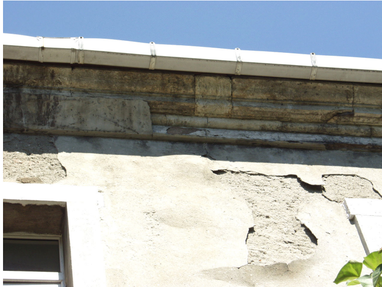
Şekil 6.88 Saçak altı taş silme.
