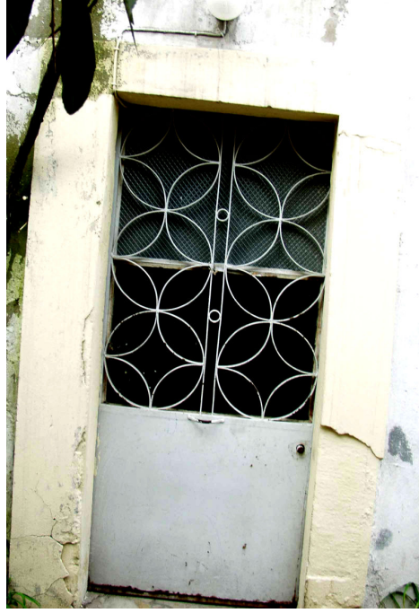
Şekil 6.95 Bodrum kat metal giriş kapısı.
