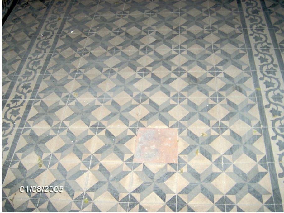
Şekil Ek 2. 2 Özgün hol döşeme kaplaması.
