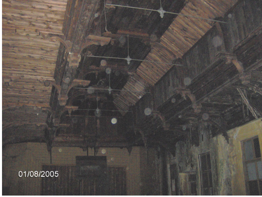
Şekil 4.10 Jimnastikhanenin tavanı, ahşap payandalar.
