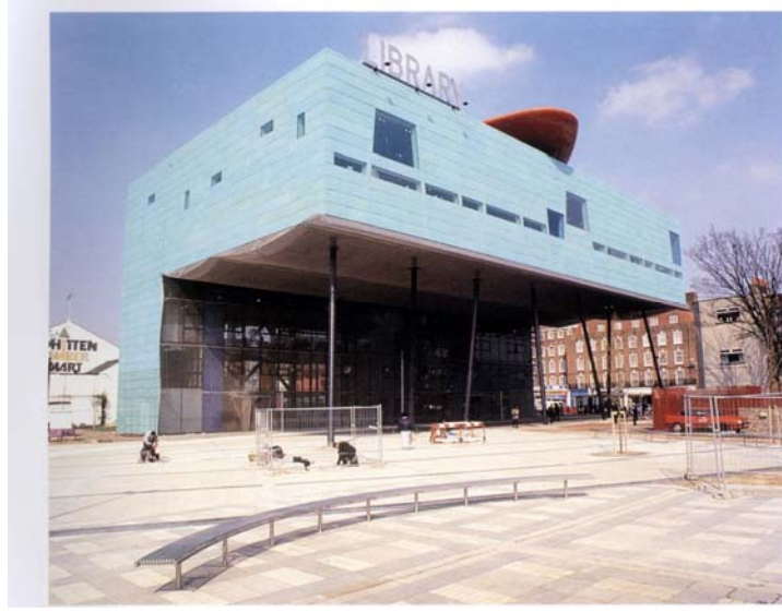
Şekil 5.2.1.11 Meydandan görünüş (Güzer,2001)
