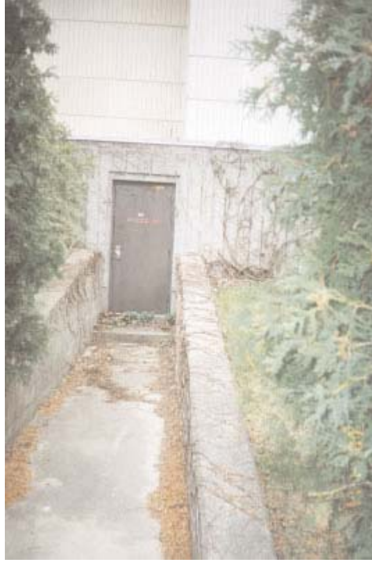
Şekil 5.3.1.10 Bitişik zeminden daha düşük kottaki giriş
