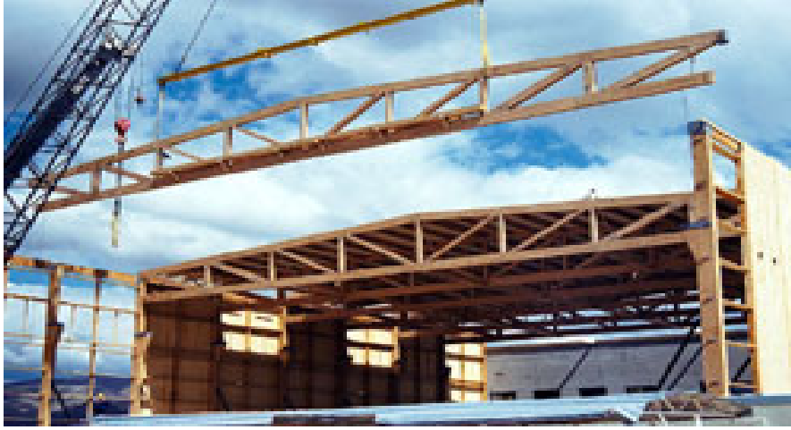
Resim 3.6 Bir hangar inşaatında ahşap makasın yerine montajı [13].
