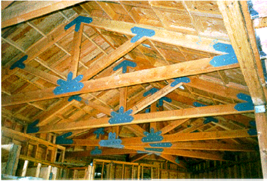
Resim 3.1 Ahşap makaslarda metal plakaların kullanıma ait uygulama örneği
