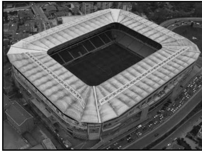
Şekil 3.16: Fenerbahçe Şükrü Saracoğlu Stadyumu, İstanbul [8]
