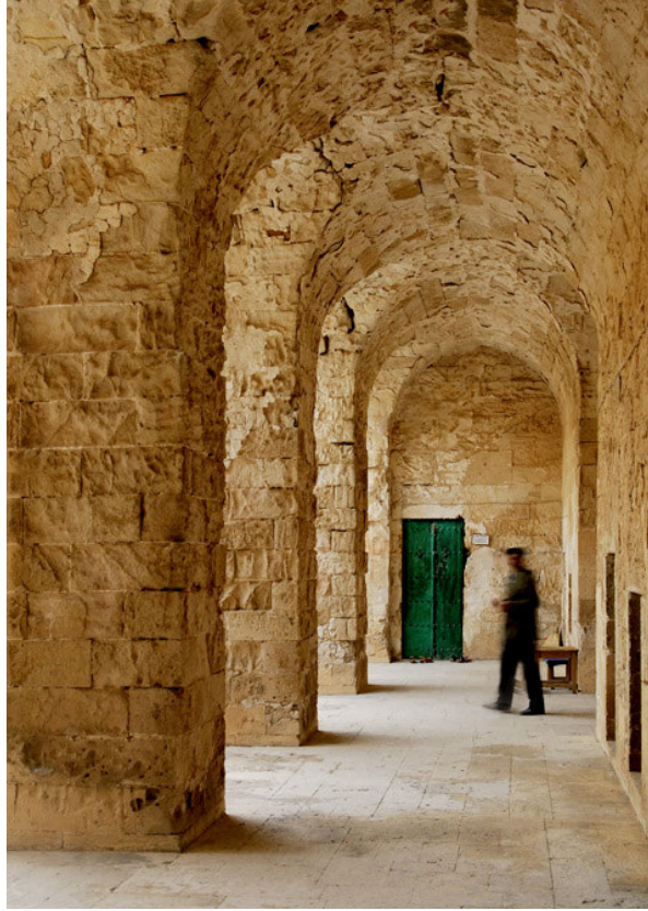
Şekil 3.5 Revak biriminin içinden yapı girişine bakış
