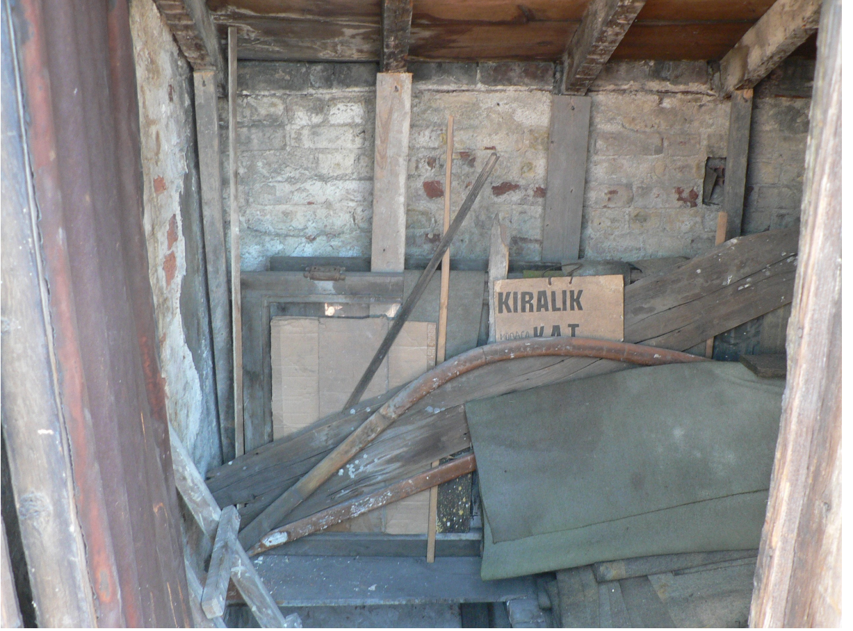
Ek 1 Şekil 12 Çatıya açılan oda
