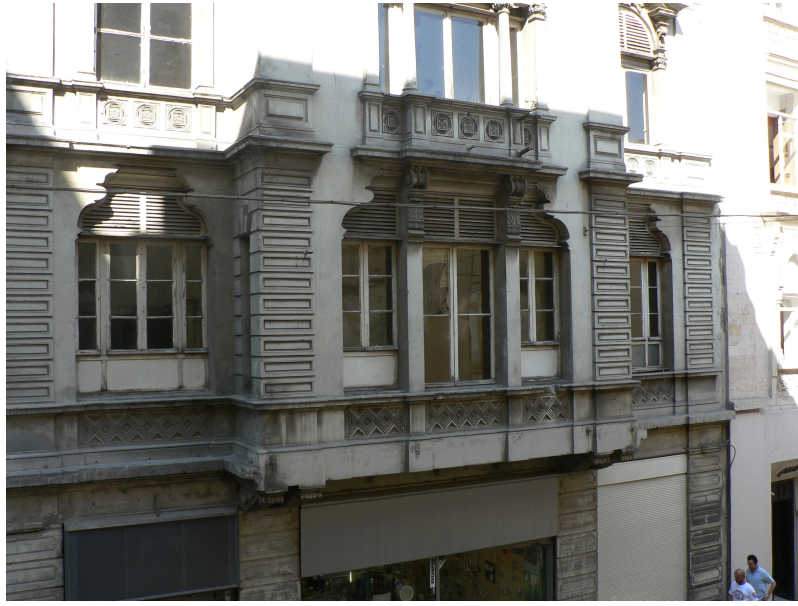
Şekil 3.16 Hezaren Han 1. kat cephesi
