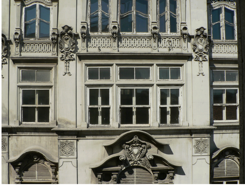
Şekil 3.18 Hezaren Han 3. kat cephesi
