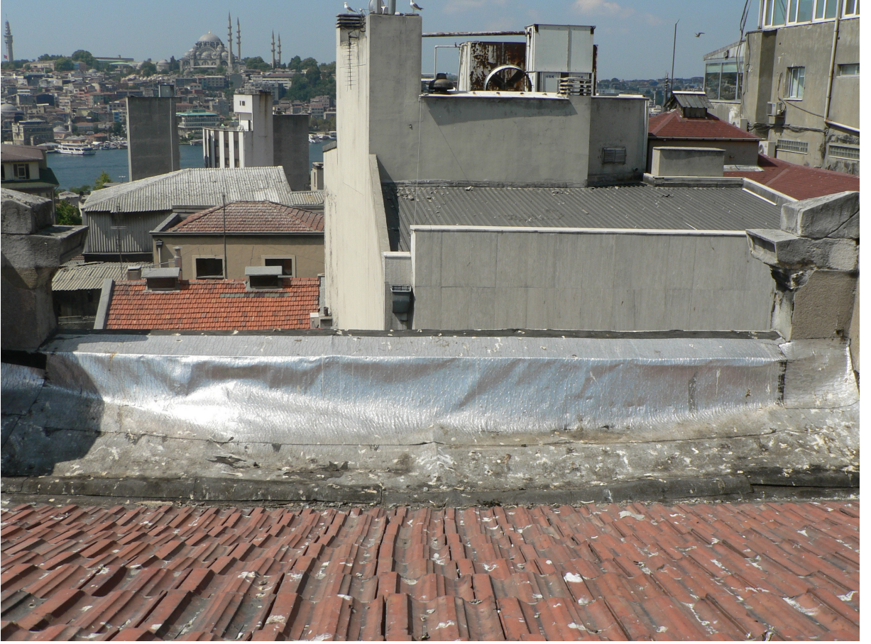
Ek 1 Şekil 8 Çatı-yatay dere birleşimi
