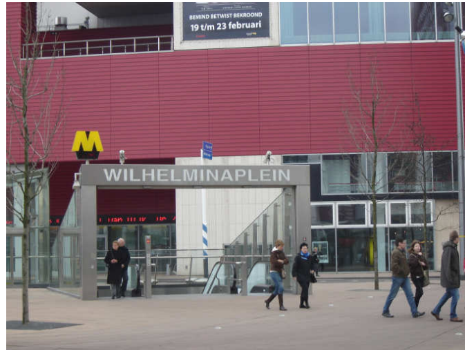
Şekil 5.10 Wilhelminaplein metro istasyonu
