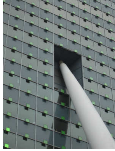
Şekil 5.69 Çelik borunun cephe ile birleşimi
