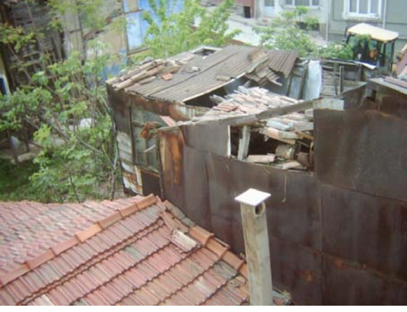
Şekil 4.59 Çatının kuzey bölümü
