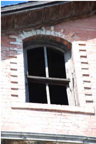
Şekil 4.24 Güney cephesi sürme pencere
