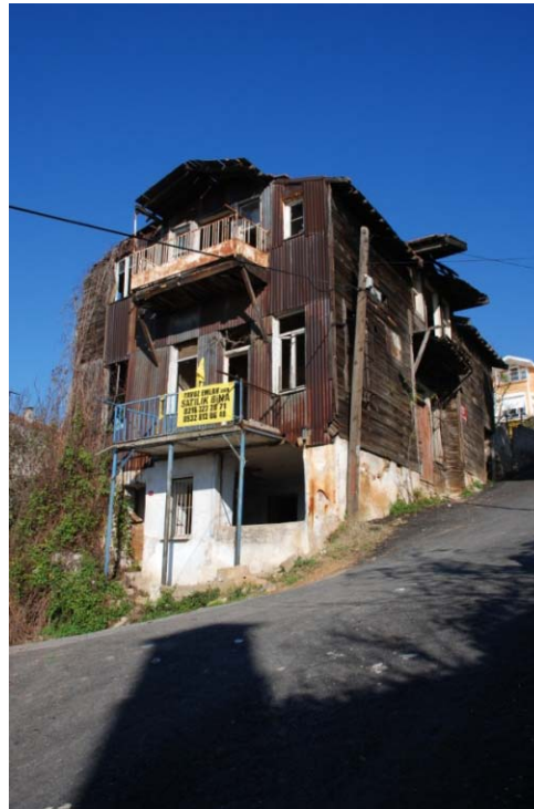
Şekil 3.117: 455 Ada, 11 parsel, güney cephesi (2006)
