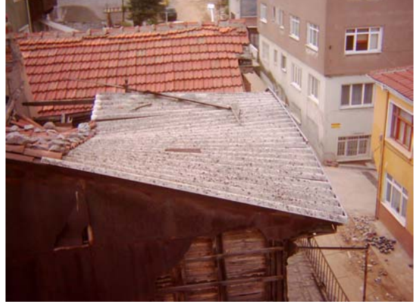
Şekil 4.60 Çatının güney bölümü
