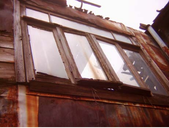
Şekil 4.61 Batı cephesi 2. kat penceresi
