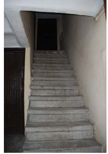
Şekil 4.12 Muhdes 1. Kat merdiveni
