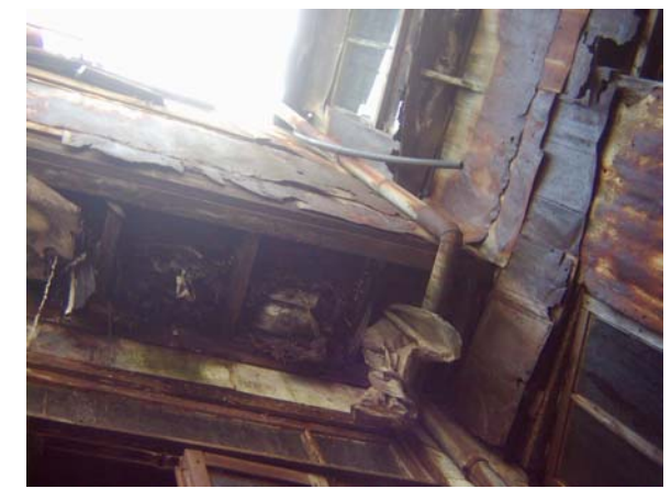
Şekil 4.64 Batı ve kuzey cephesi birleşimi
