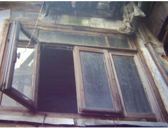
Şekil 4.63 Batı cephesi 1. kat penceresi
