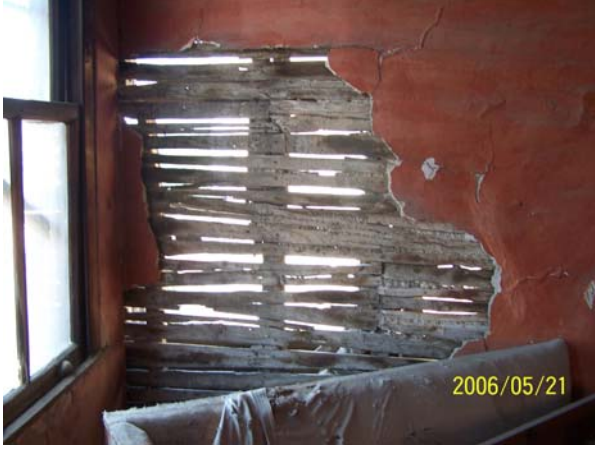
Şekil 4.49 Oda batı duvarı (202)
