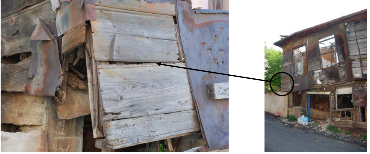
Şekil 3.388: 455 Ada, 1 parsel, geçmeli ahşap kaplama detayı (2007)
