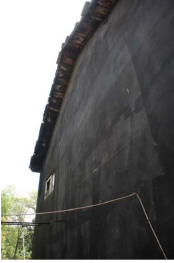
Şekil 4.22 Muhdes yapı, kuzey cephesi
